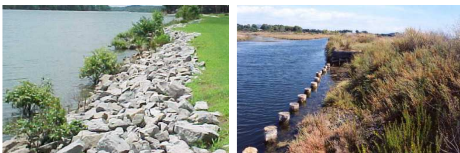
Figura 6. Esempi di scogliere, terrazzi vivi rinforzati o palificate in legno vivo.
