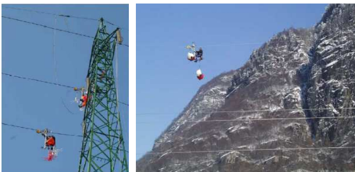
Figura 8. Esempi di dispositivi a sfera installati sulle linee ad alta tensione in ambito montano.
