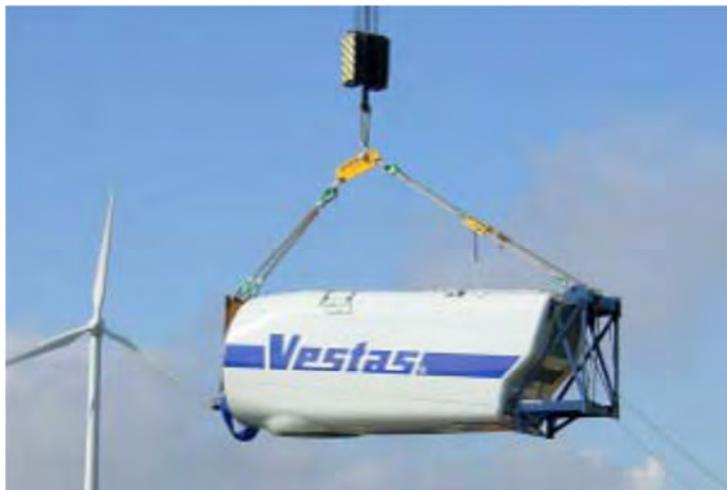
Fig. 3-2b. Navicella durante il posizionamento (Vestas V90)
