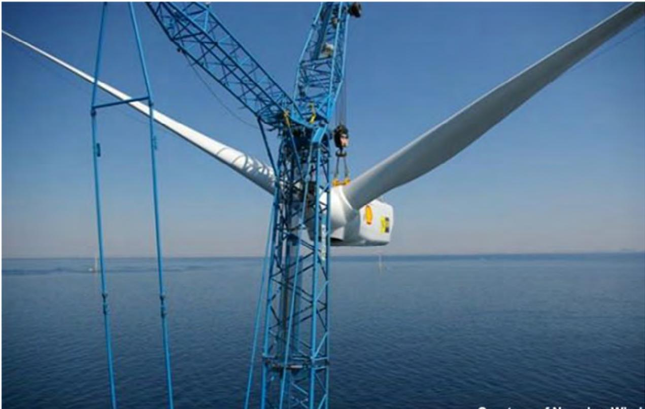
Fig. 3-2m. Montaggio di navicella (Vestas V90) su torre del campo di Egmond aan Zee (NoordzeeWind)
