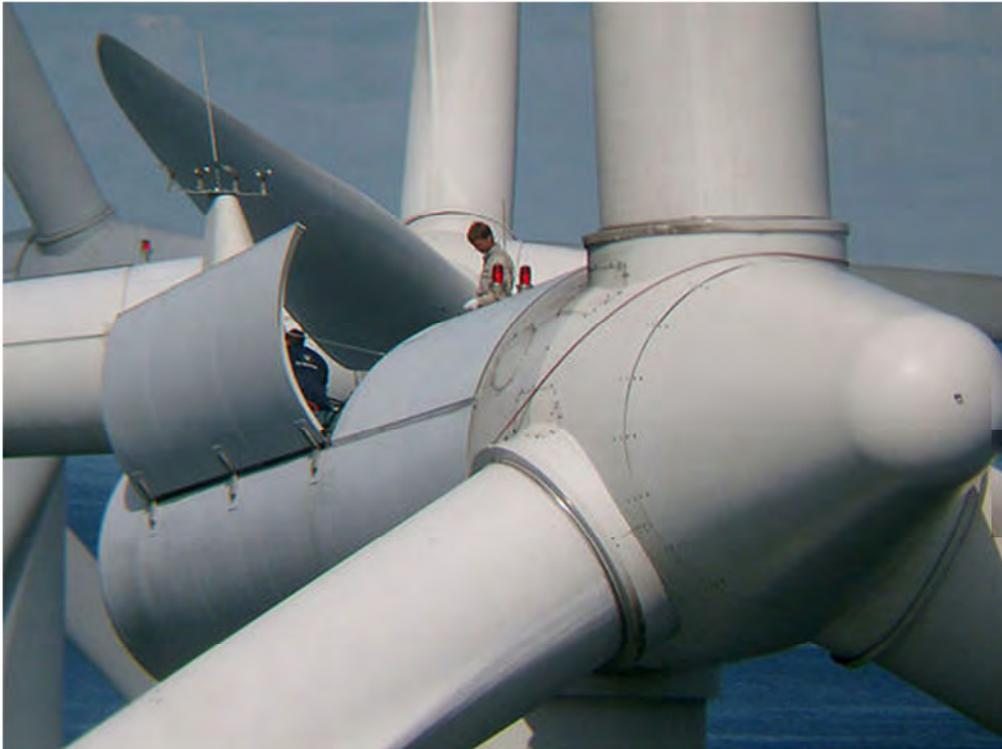
*Fig. 3-2h. Macchine eoliche in montaggio*
