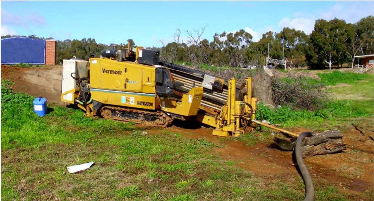
**1) Realizzazione vasca di entrata (Entry Point), posizionamento macchina perforatrice a mast inclinabile e gruppo di miscelazione e pompaggio fluidi a base d'acqua (con bentonite biodegradabile al 100% tipo BIO-BORE);**
