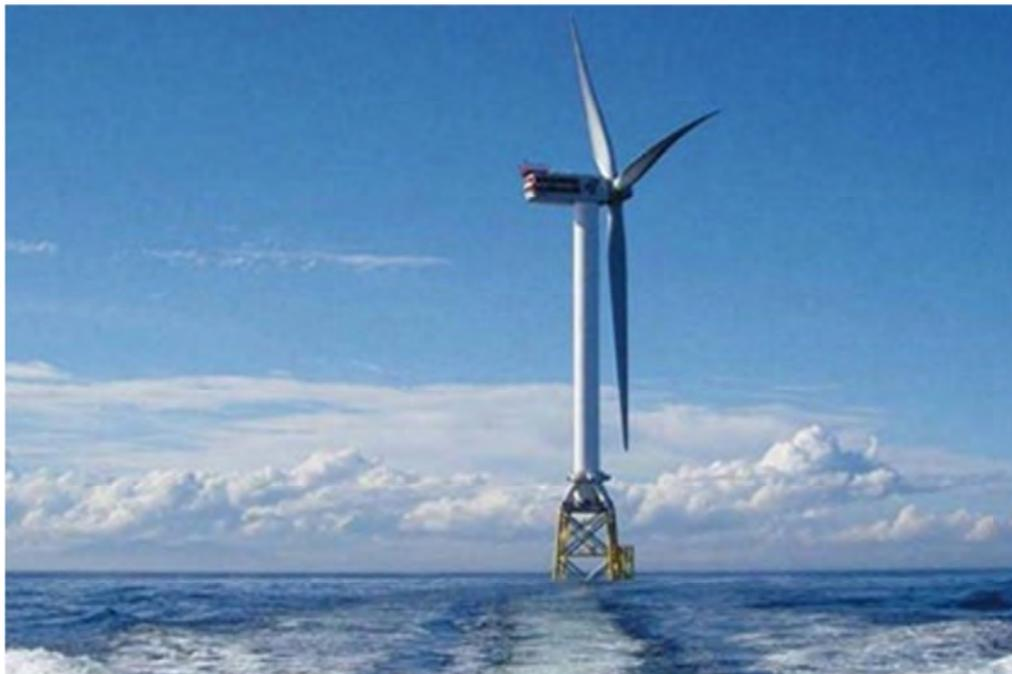
*Fig. 3-3a. Struttura portante a castello per turbina eolica offshore 5M montata a Moray Firth (REpower)*
