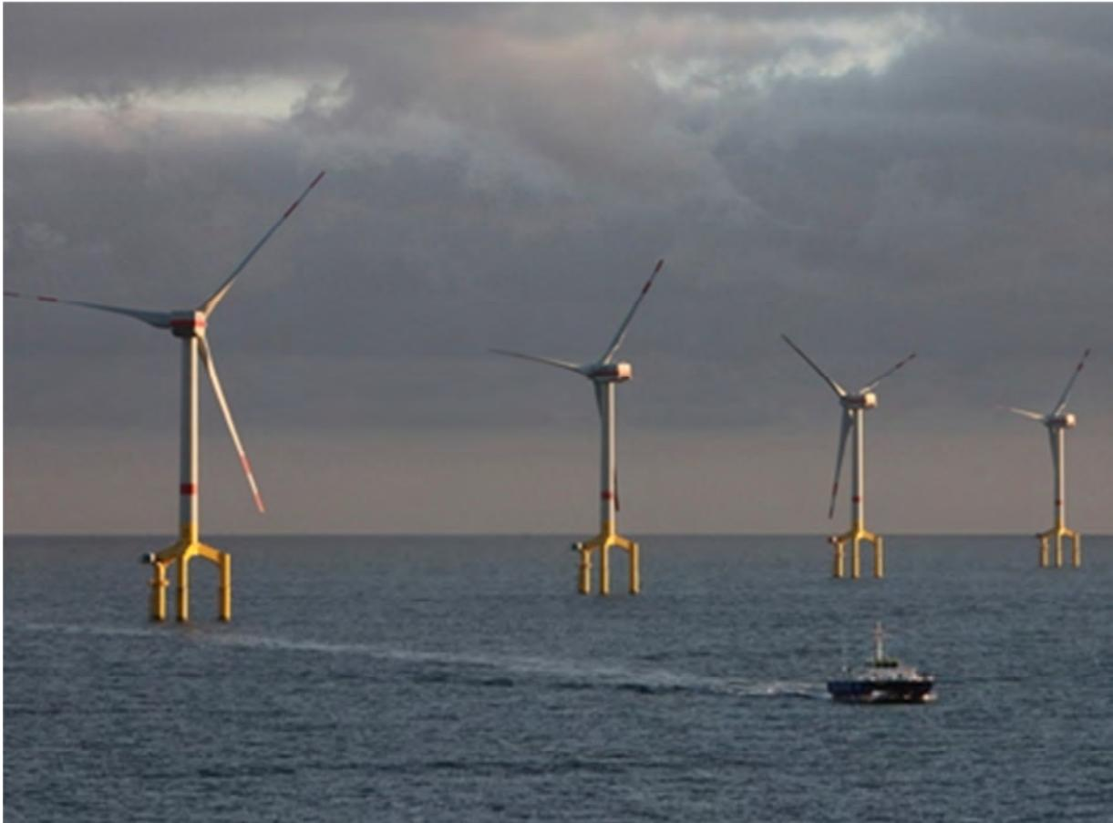
*Fig. 5-1f. Campo Bard Offshore 1 di circa 60 kmq, costituito da 80 unità Bard 5 MW su fondale da 30-40 m di profondità a circa 90-100 km dall'isola di Borkum (DE)*
