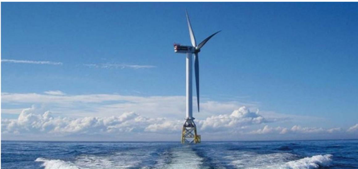
Fig. 5-1a. Struttura portante a jacket per turbina eolica 5M montata a Moray Firth (REpower)
