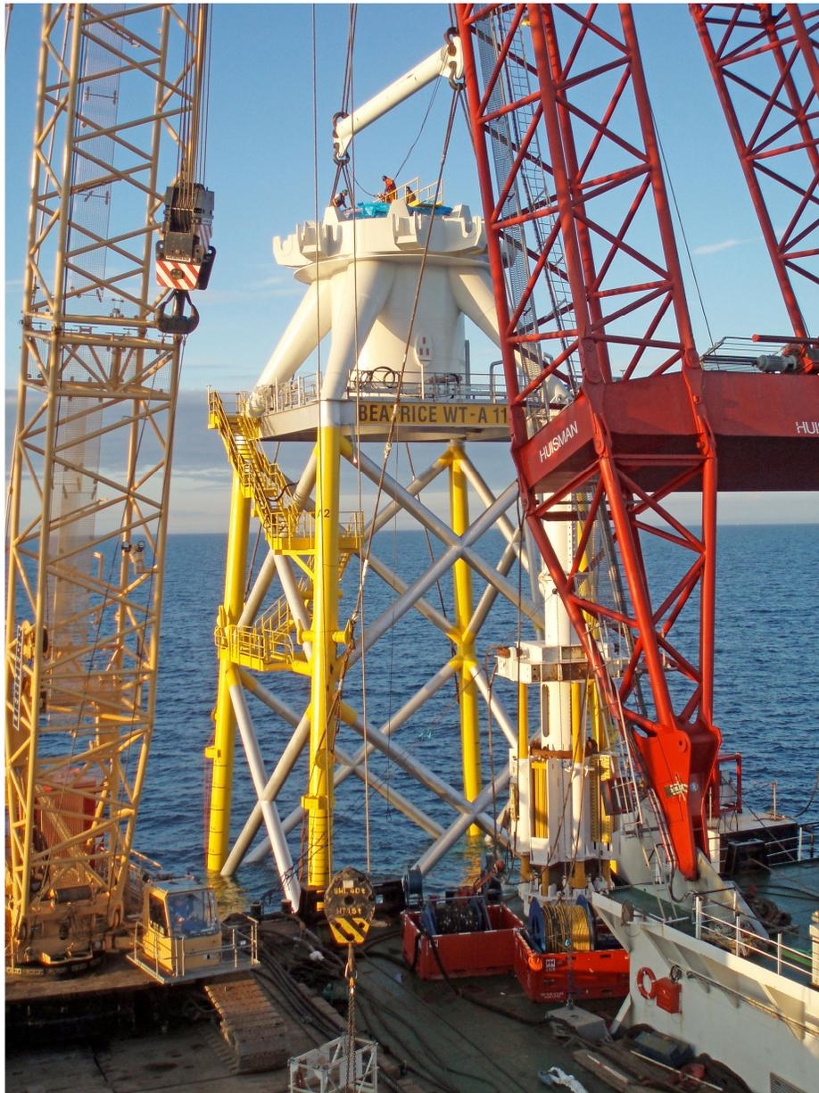
Fig. 4-3a. Fondazione a castello a quattro montanti per turbina eolica 5M, mentre si sta predisponendo lo zoccolo di base della torre (REpower)
