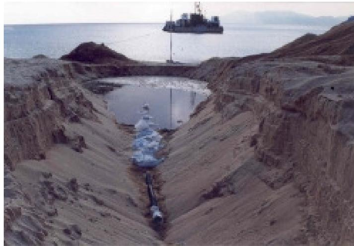
*Fig. 8-2w.4. Scavo e posa di cavo sul lido con mezzi escavanti di terra*
