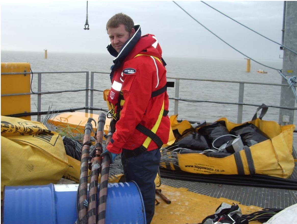
Fig. 8-2m.2. Preparazione delle estremità del cavo sottomarino
