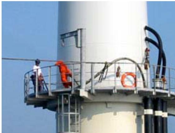
*Fig. 4-1a. Sistemazione del tubo di difesa cavi (J-Tube) in una fondazione a monopila e relativi passaggi entro la torre*
