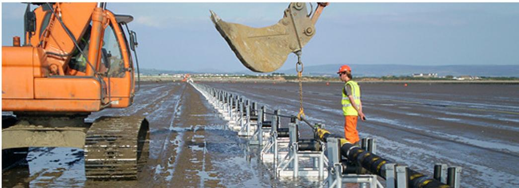
Fig. 8-2w.1. sistemazione di guide per cavo sottomarino lungo un lido
