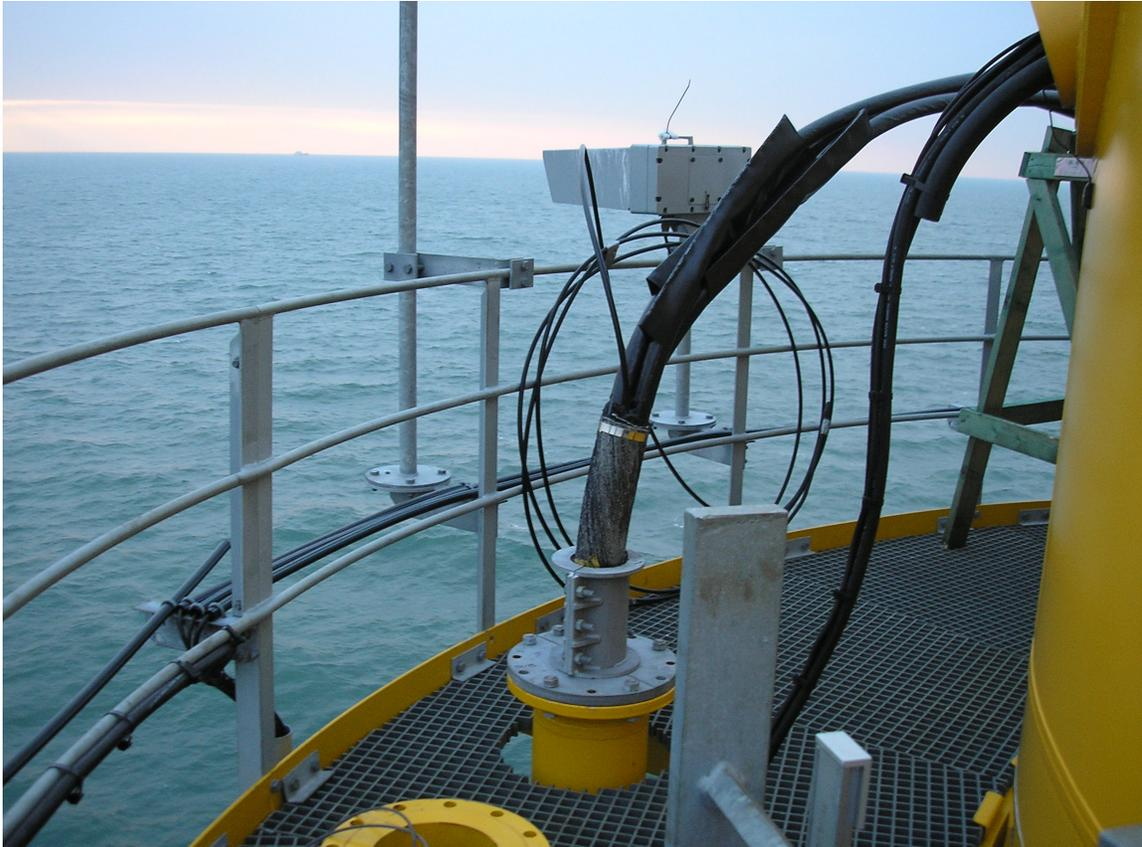
Fig. 4-2b. Uscita dei cavi dal tubo di guida e connessioni con i quadri all'interno dell'aerogeneratore
