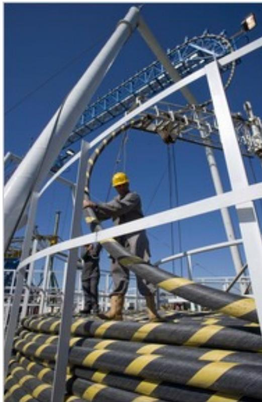
*Fig. 8-1h. Assistenza manuale a cavo da battello durante i lavori per il Trans Bay Cable Project a San Francisco, che richiede la posa di 53 mil di cavo*
