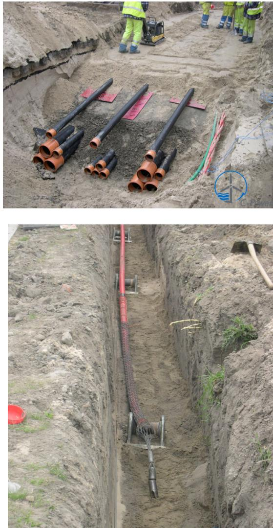
*Fig. 8-2w.6. Cavi variamente interrati nel percorso a terra verso le stazioni elettriche (C-Power)*
