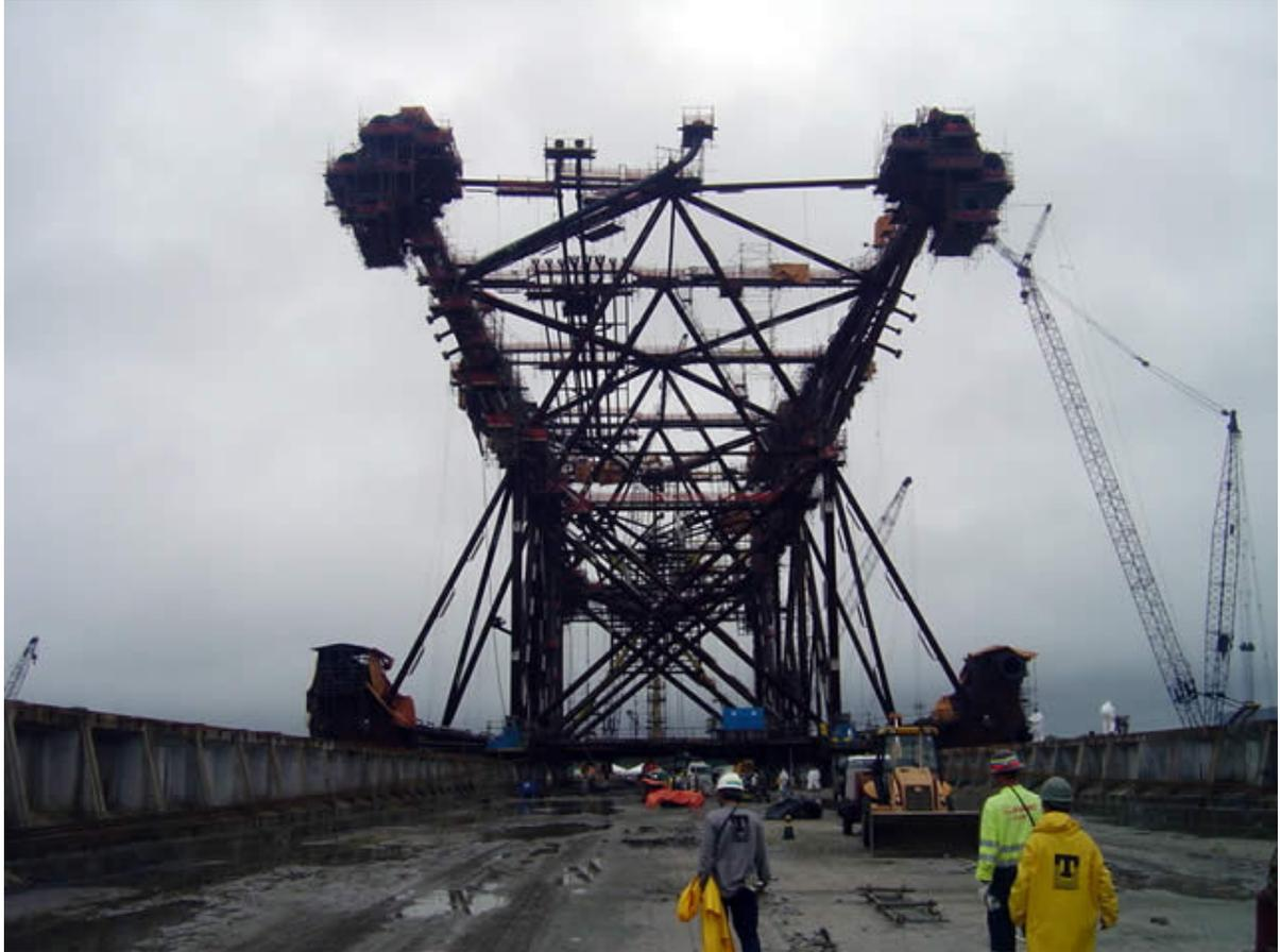
Fig. 5-4. Grande struttura di supporto (6.000 ton) in fase di spostamento a mezzo scivolamento da cantiere a mezzo navale (Fagioli USA)
