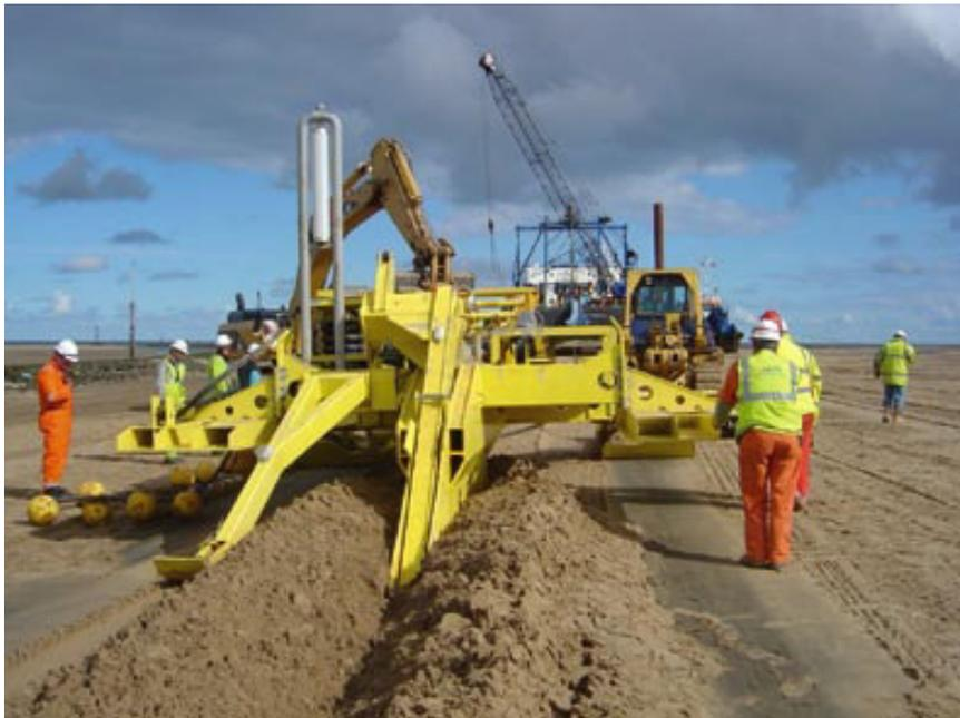
Fig. 8-2c. Tracciamento di solco per cavo sottomarino in spiaggia (Thanet)
