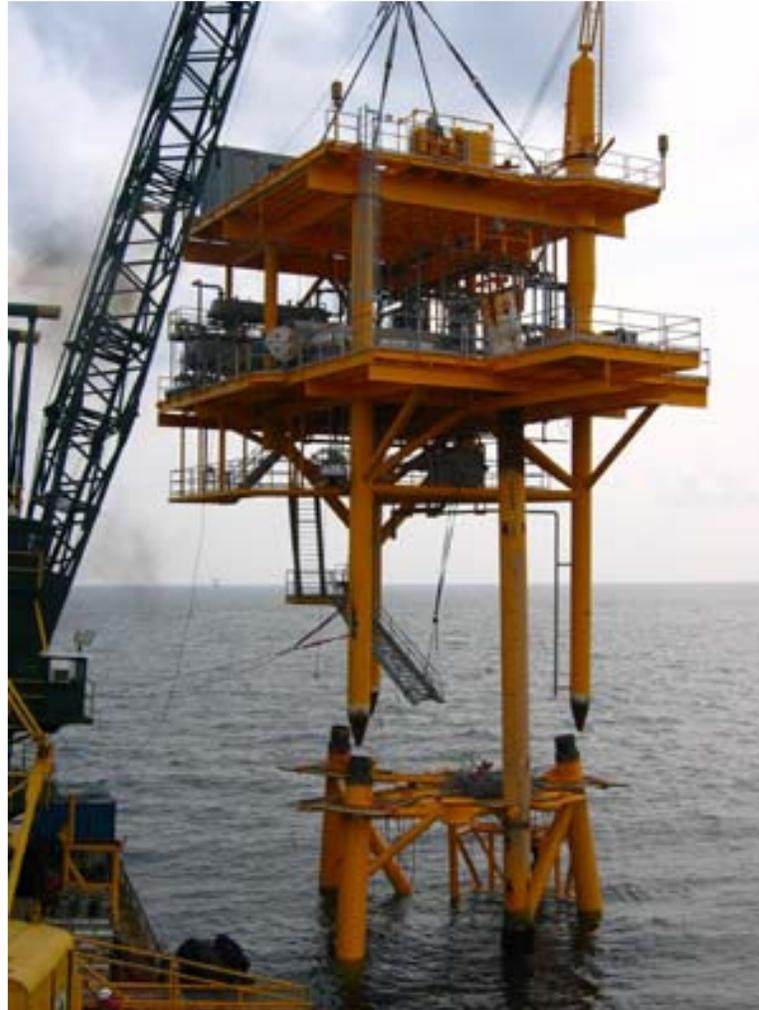
Fig. 5-2. Montaggio del deck sul jacket di una postazione petrolifera (Bisso)
