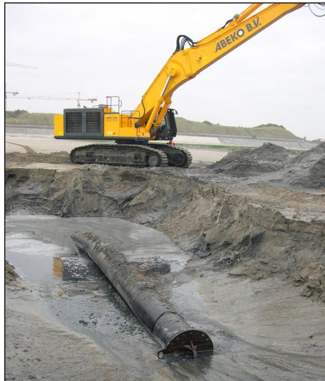
*Fig. 8-2w.5. Scavo lungo litorale sabbioso e posa di schermatura metallica per cavi*
