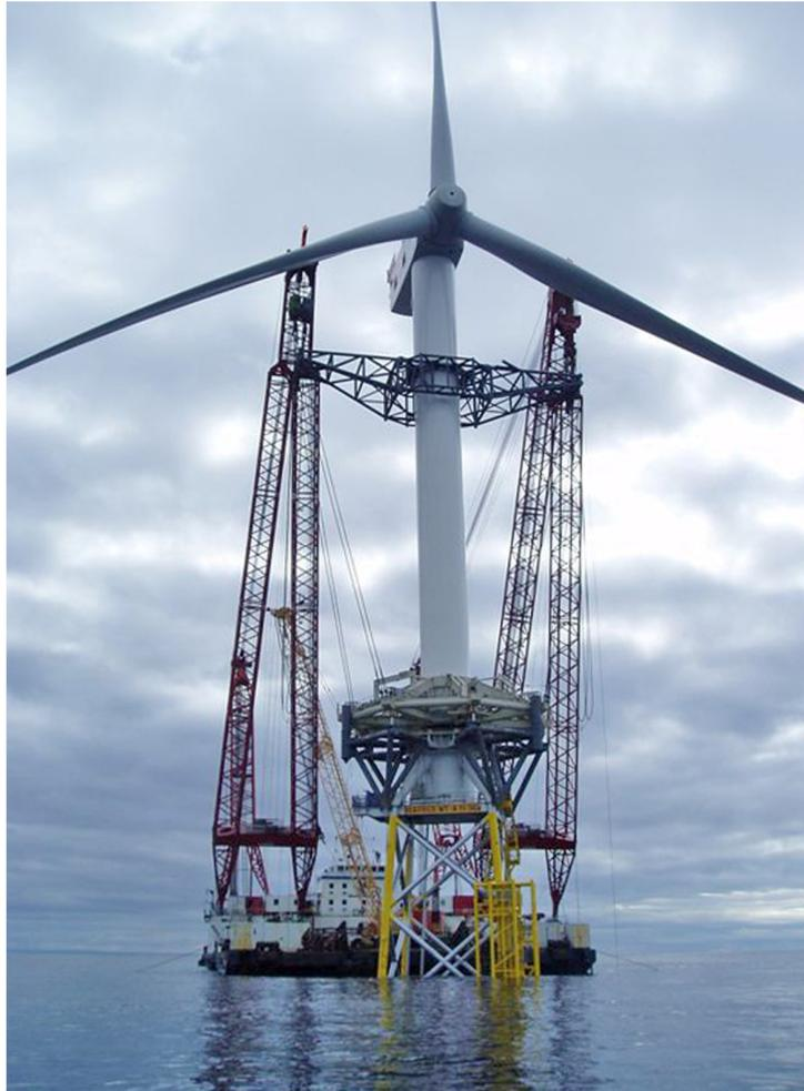
*Fig. 5-5. Vista frontale degli equipaggiamenti per il completamento del montaggio di turbina REpower 5M al largo delle coste scozzesi*
