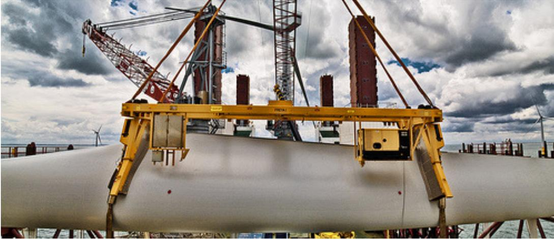
*Fig. 8-1c. Spostamento di pala (Lynn & Inner Dowsing)*
