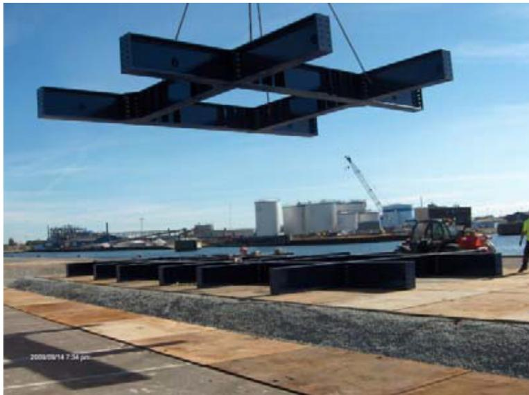
*Fig. 5-1o. Grigliato a grosse travi di legno per reggere torri complete/sezione di base nell'area prospiciente il punto di carico dei battelli per il sito con strato di ghiaia di diversa granulometria per livellamento (Vestas)*
