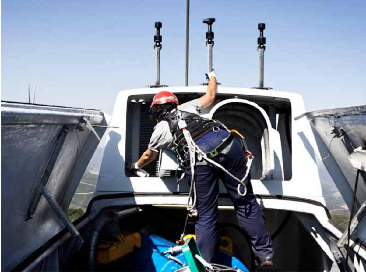
*Fig. 4-1b. Navicella della turbina V112 a cielo aperto*
