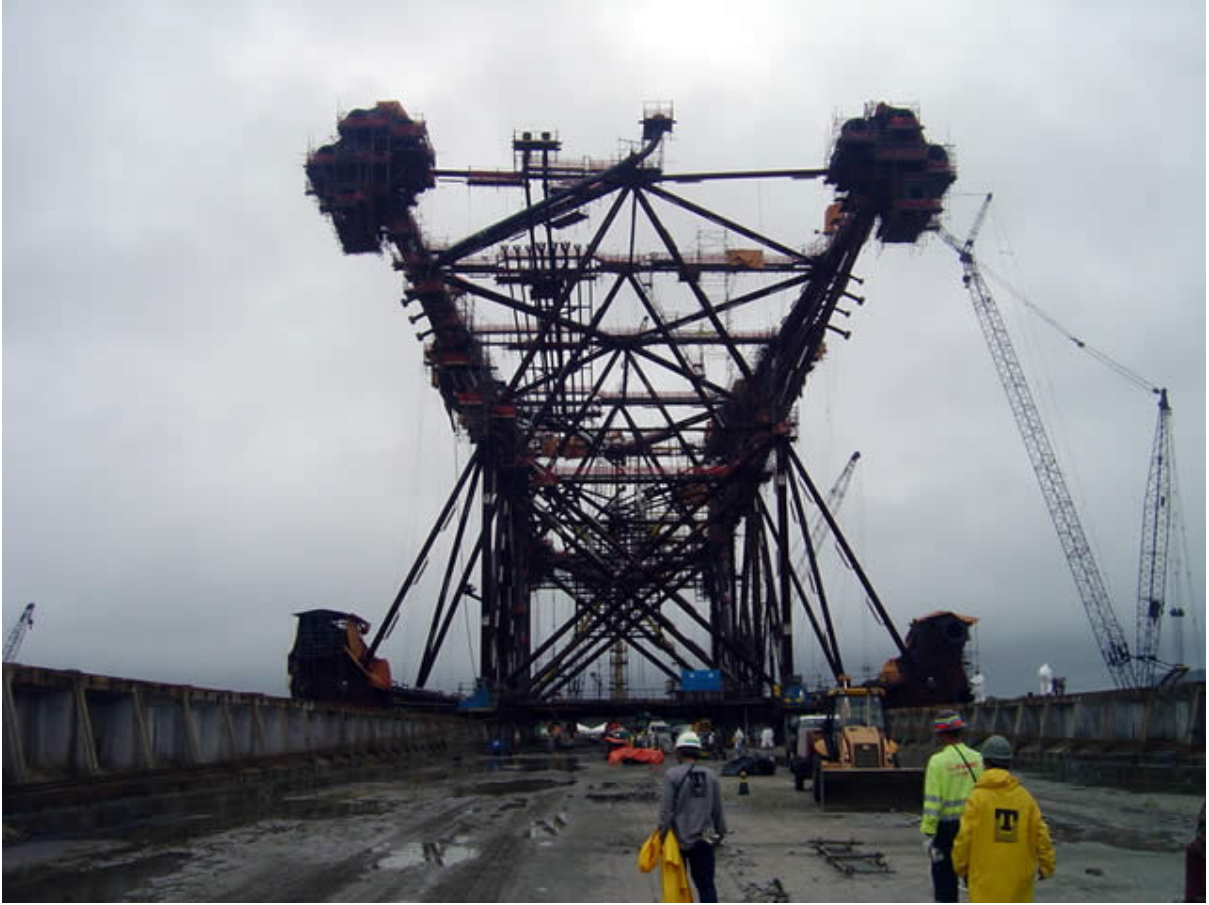
Fig. 3-1e. Grande struttura di supporto (6.000 ton) in fase di spostamento a mezzo scivolamento da cantiere a mezzo navale (Fagioli USA)
