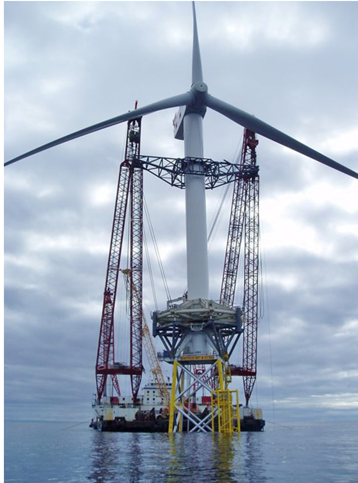
Fig. 3-1f. Vista frontale degli equipaggiamenti per il completamento del montaggio di turbina REpower 5M al largo delle coste scozzesi
