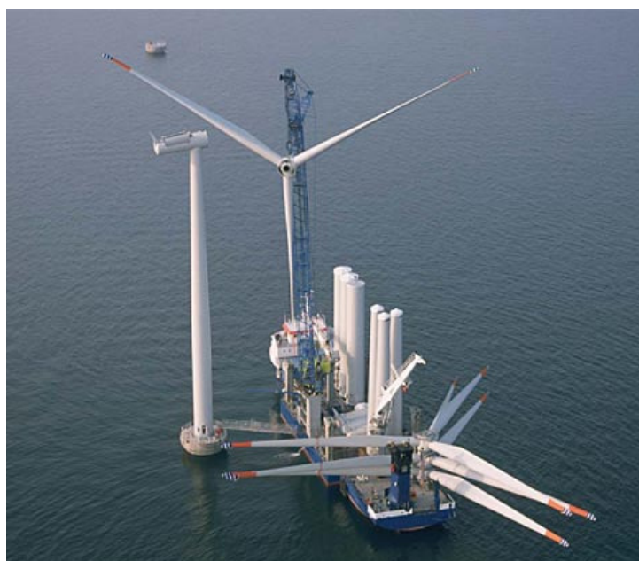
Fig. 6-1c. Costruzione pezzo a pezzo (1, 2 e 3) del rotore (Greater Gabbard) o sistemazione (6) del rotore completo sull'asse lento (Nysted)
