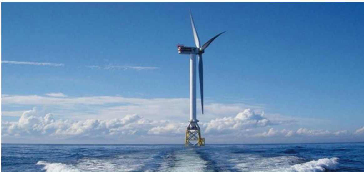
Fig. 3-1a. Struttura portante a jacket per turbina eolica 5M montata a Moray Firth (REpower)
