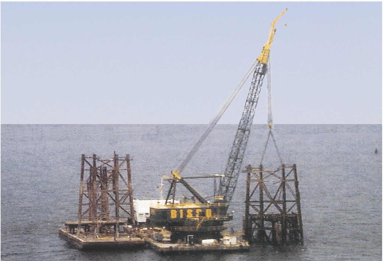
Fig. 6-1j. Operazione di recupero nel Golfo del Messico del castello metallico di jacket petrolifero mediante gru montata su pontone e sistemazione del traliccio a tubi su piccolo pontone (Bisso-Gulf)
