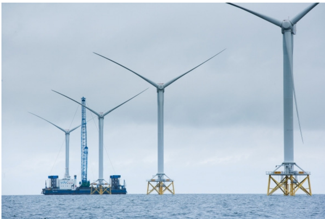
Fig. 1-1. Fase di installazione di turbine e precisamente del rotore (a) e vista (b) di alcune unità con il jack-up sullo sfondo nel sito di Ormonde (Vattenfall)
