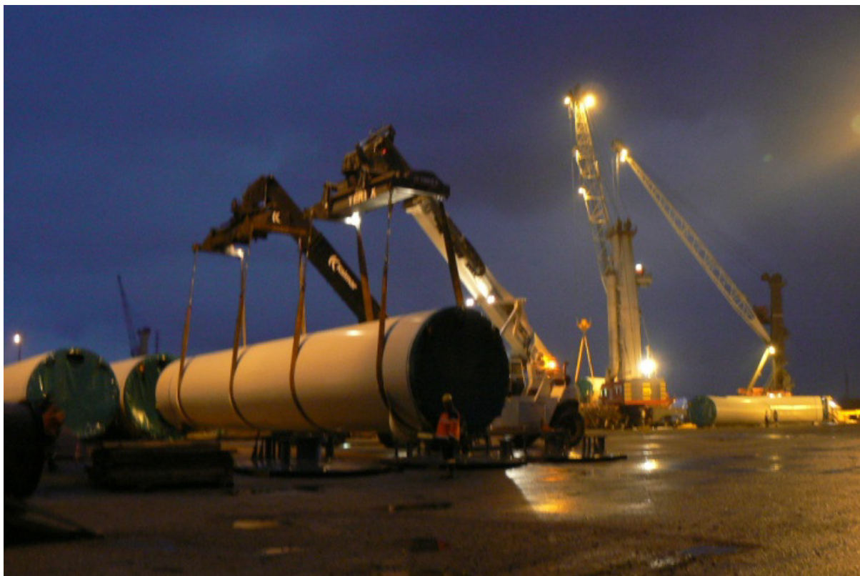
Fig. 6-1r. Movimentazione di tronchi di torre mediante coppia di elevatori e mediante cinghie (Vestas)
