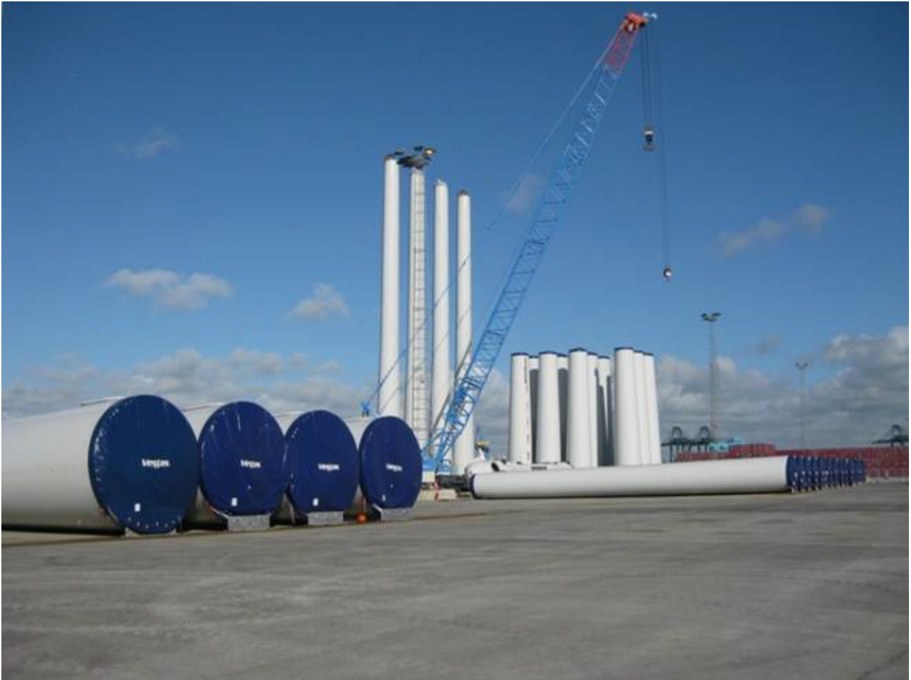
Fig. 6-1q. Vista del cantiere per unità V112 con sezioni di base delle torri, con torri durante/a montaggio ultimato e con gru (Vestas)
