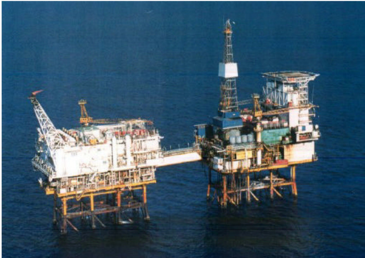
Fig. 3-1b. Piattaforme accoppiate per sfruttamento di giacimento petrolifero (Alpha Beatrice)
