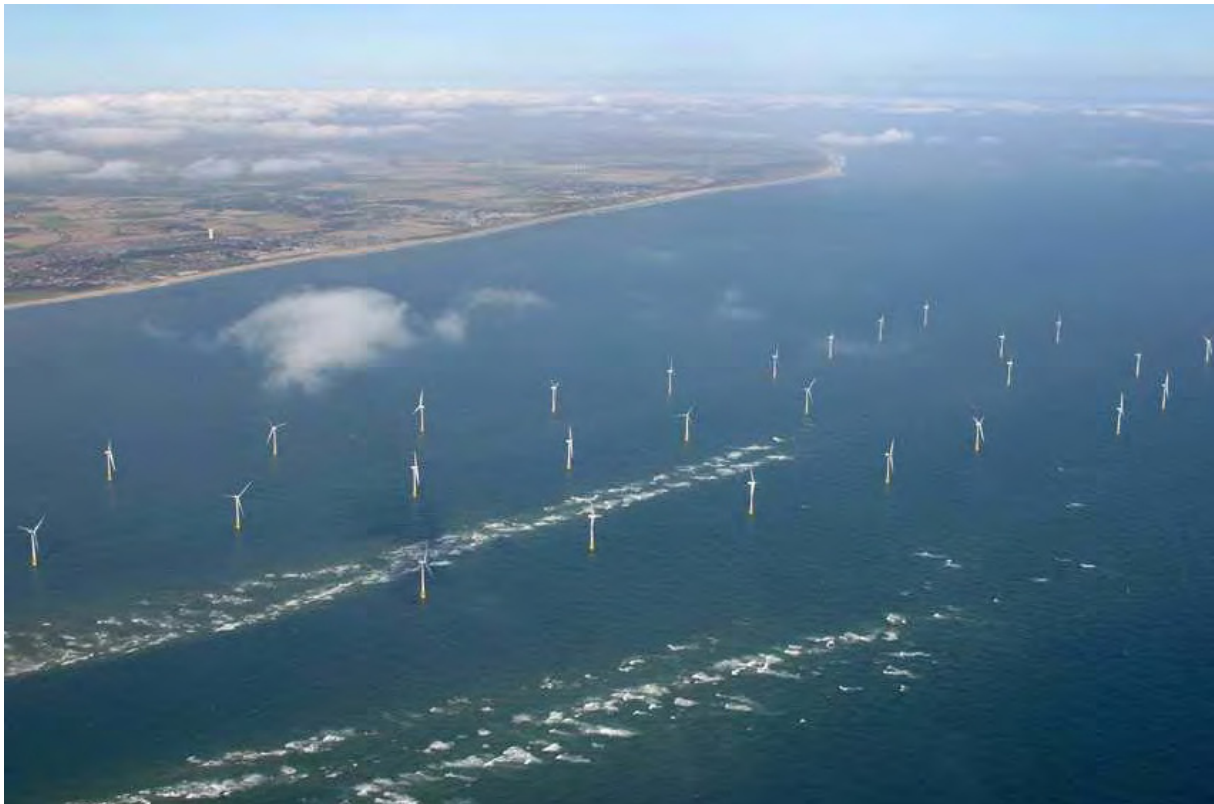
Fig. 5-2a. Campo eolico inglese composto da 30 unità da 2 MW (Vestas V80) impostate su fondazione monopila su fondale posto tra 13 m e 30 m di profondità a circa 2,5 km dalla costa (Scroby Sands)
