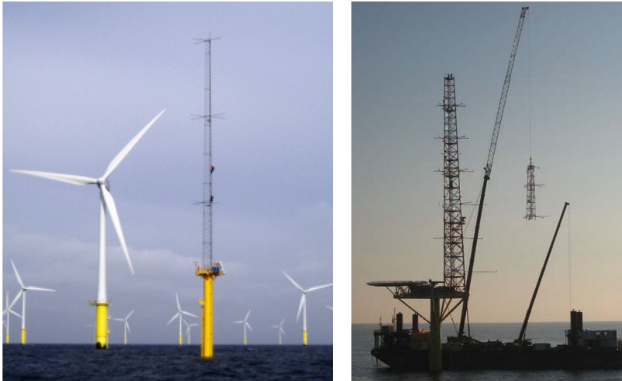
1) 2) Fig. 6-1m. Torre anemometrica del campo di North Hoyle (1) e della stazione tedesca Fino 3 (in fase di montaggio)
