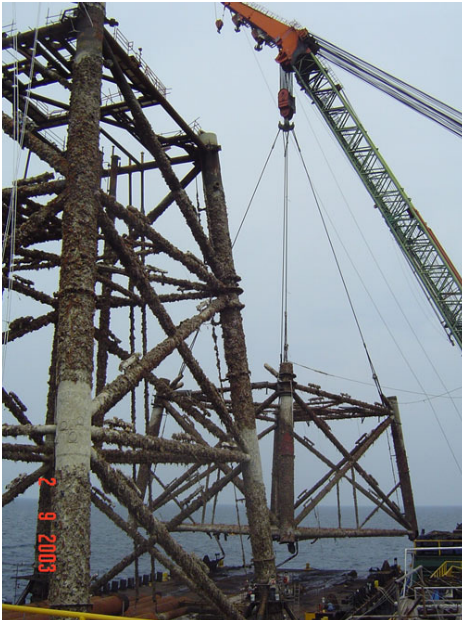
Fig. 6-1i. Rimozione di jacket (Shell)
