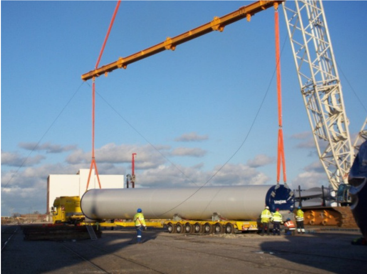
Fig. 6-2b. Scarico da natante della torre retta da asta di supporto e sistemazione su cocodrillo per V112 (Vestas)
