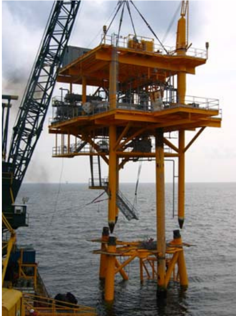
Fig. 3-1c. Montaggio del deck sul jacket di una postazione petrolifera (Bisso)
