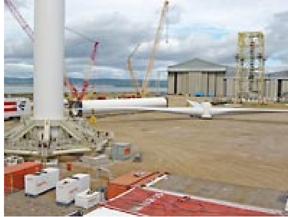
Fig. 3-2a. Basamento di torre in cantiere (REpower)
