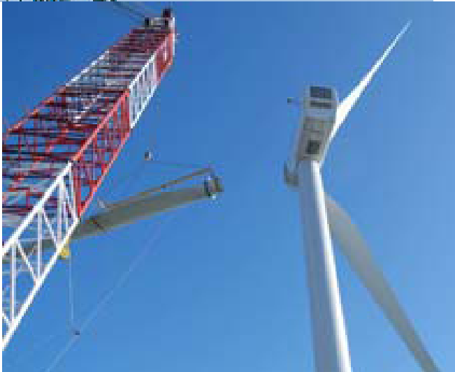
Fig. 6-1a. Montaggio (1, 2) del monopila (Horns Rev,), (3) del transition piece (Arklow Bank), della (4) torre (North Hoyle), della (5) navicella con due pale (Horns Rev) e (6) dell'ultima pala (Greater Gabbard)
