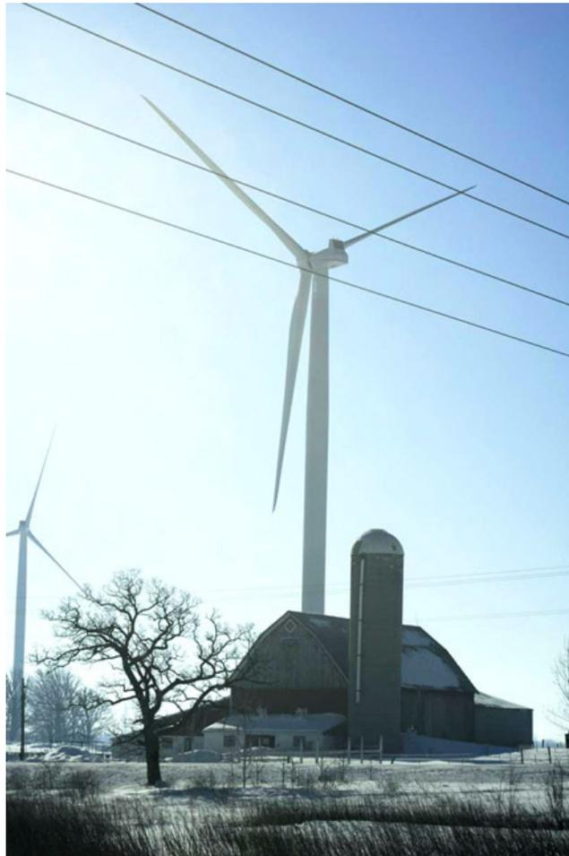
Fig. 6-3e. Sistemazione di campo eolico e di linee aree troppo a ridosso di costruzioni civili
