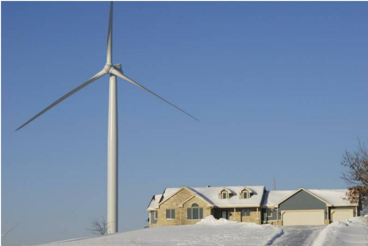
*Fig. 6-3d. Esempi di mancata osservanza delle distanze di rispetto*
