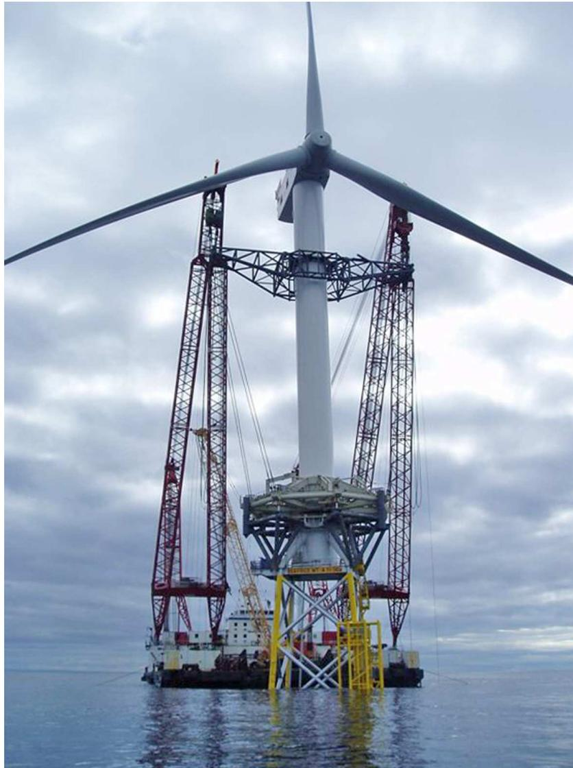
*Fig. A-2d. Completamento del montaggio di turbina REpower 5M (sistemazione su jacket a 4 montanti mediante pontone attrezzato con gru di diversa gittata in prospettiva) nel Mar del Nord al largo delle coste scozzesi (REpower)*
