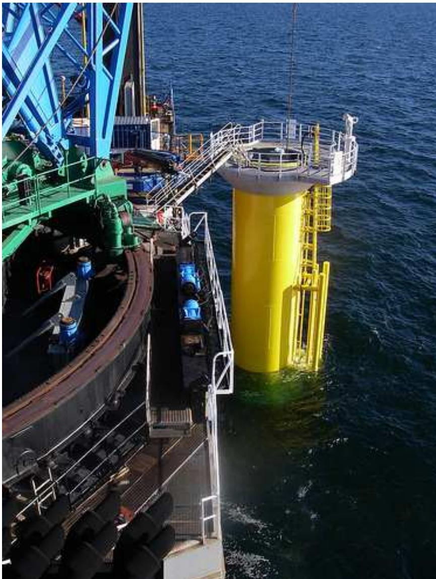
*Fig. A-7a. Struttura fondaria a monopila per turbina eolica durante i montaggi (Horns Rev)*
