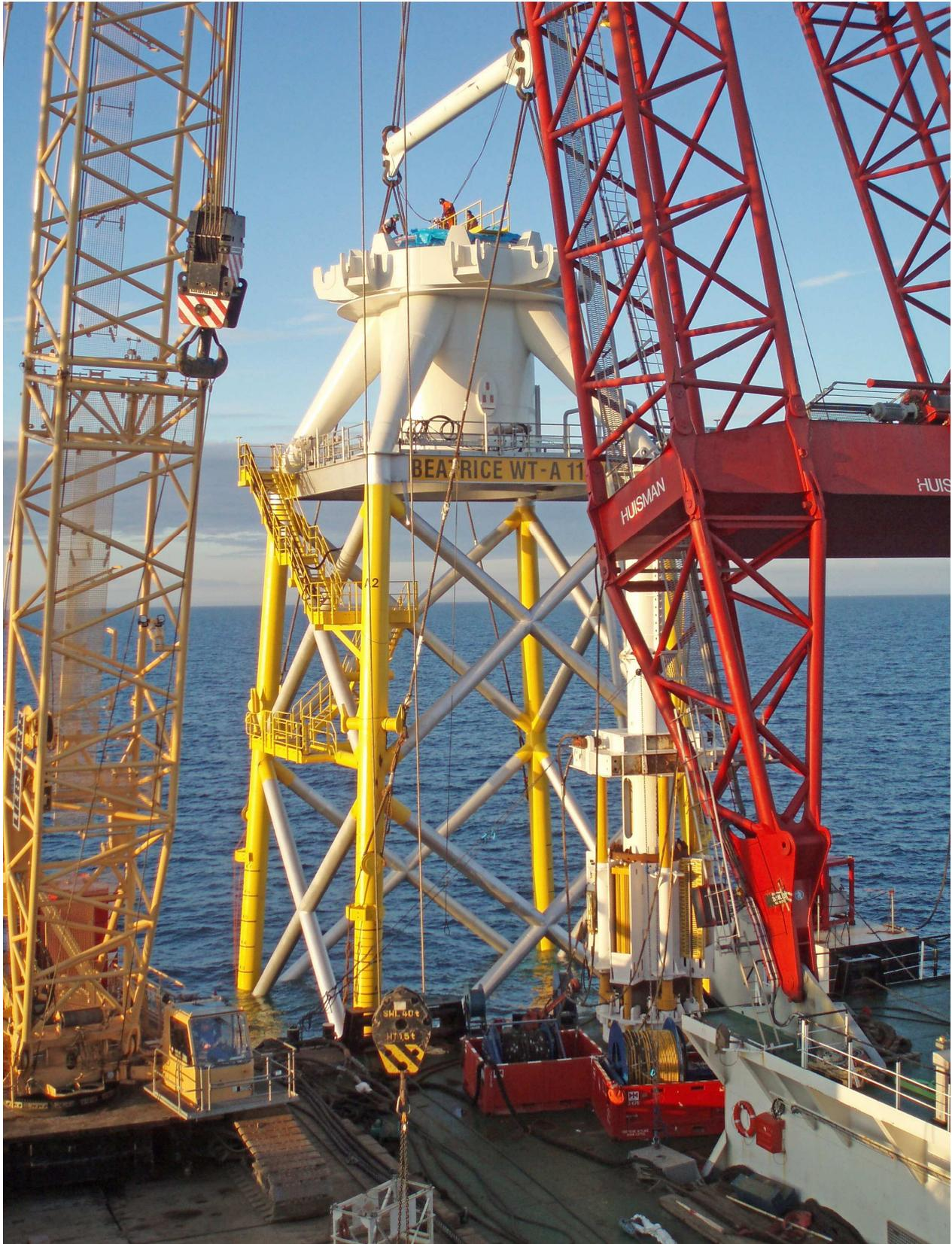
*Fig. A-4a. Fondazione a traliccio e collegamento con la torre di turbina 5M a Moray Firth (REpower)*
