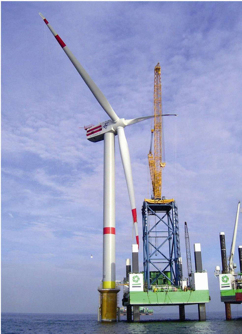
*Fig. A-7b. Montaggi su turbina sostenuta da struttura a monopila (REpower)*
