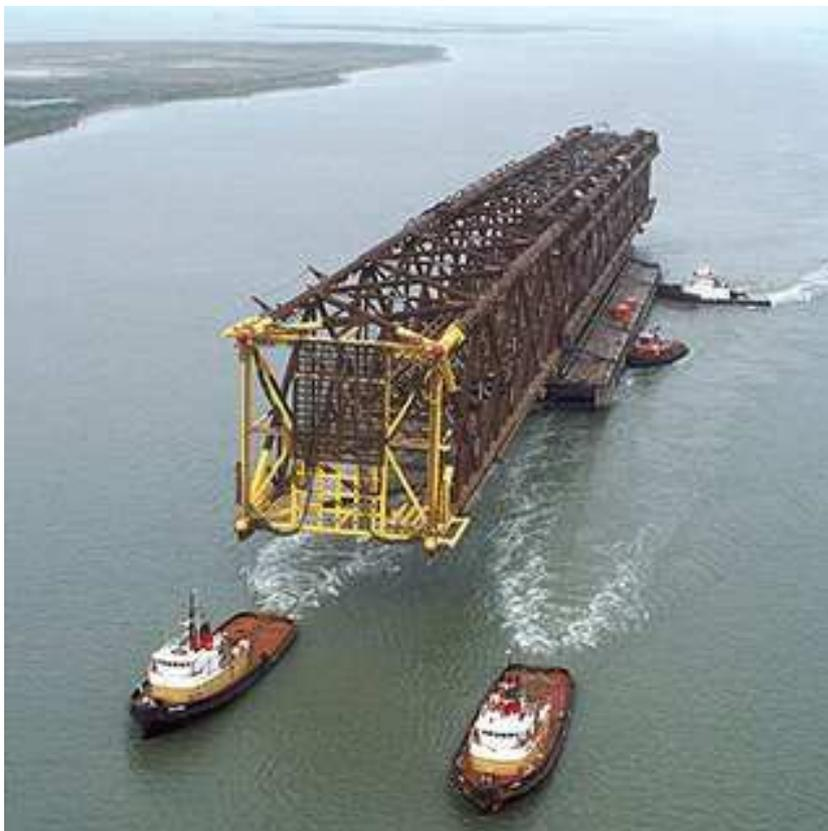
Fig. A-3b. Struttura portante durante il trasporto sul sito
