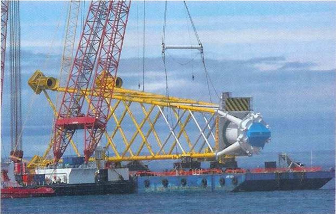
Fig. B-8c. Struttura portante della Fig. B-8a durante la fase di imbracamento per l'installazione a mare (REpower)
