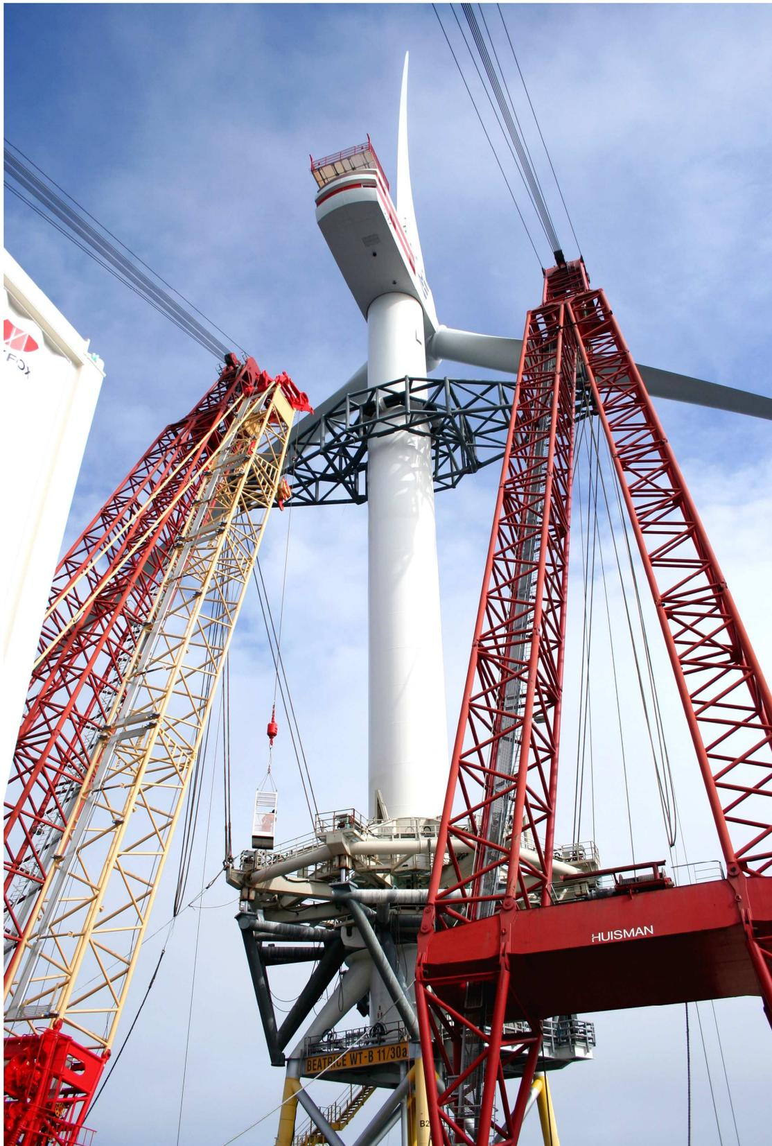
*Fig. A-4b. Particolare del collegamento tra la testa della fondazione, già equipaggiata con la sede per ospitare il basamento della torre, e la base della turbina 5M, dotata di struttura di guida (REpower)*
