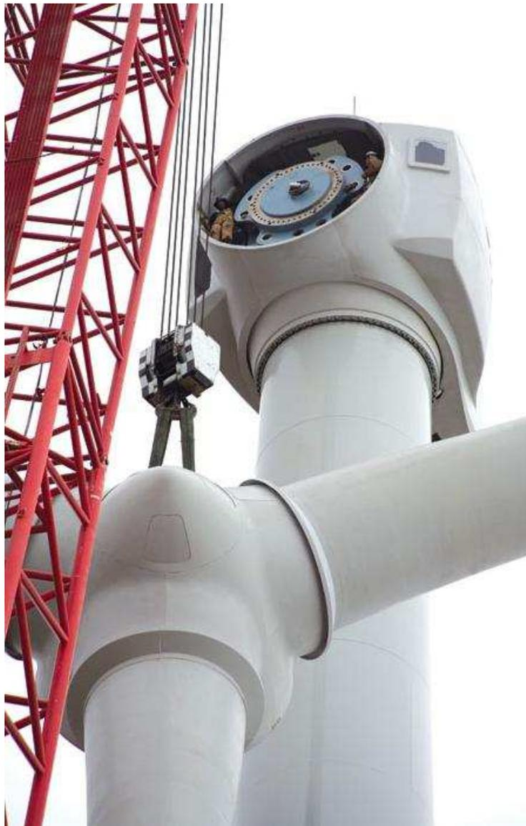
Fig. A-9. Rotore in fase di montaggio sull'albero e sui componenti della catena di produzione dell'energia, contenuti nella navicella
