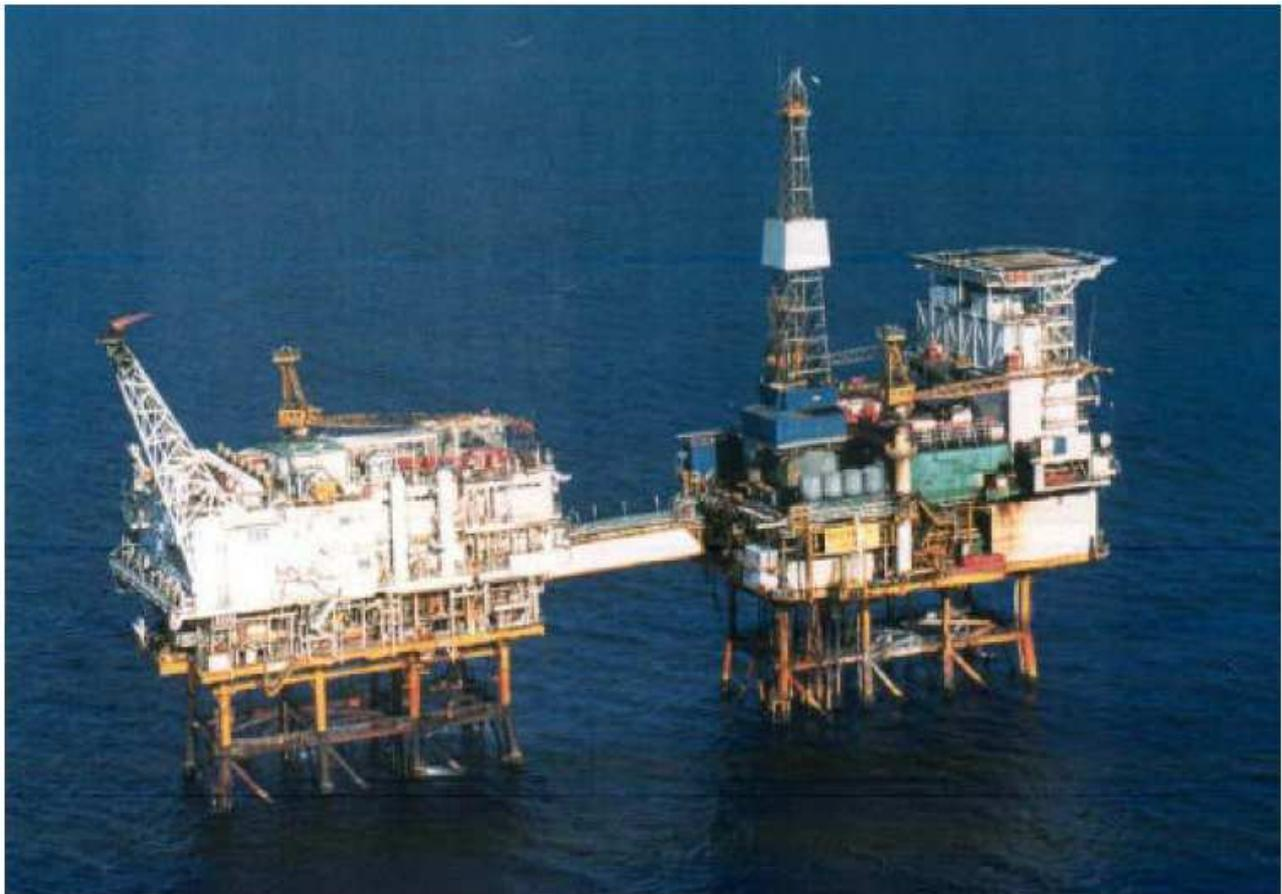
Fig. A-2a. Piattaforme accoppiate per sfruttamento di giacimento petrolifero (Alpha Beatrice)
