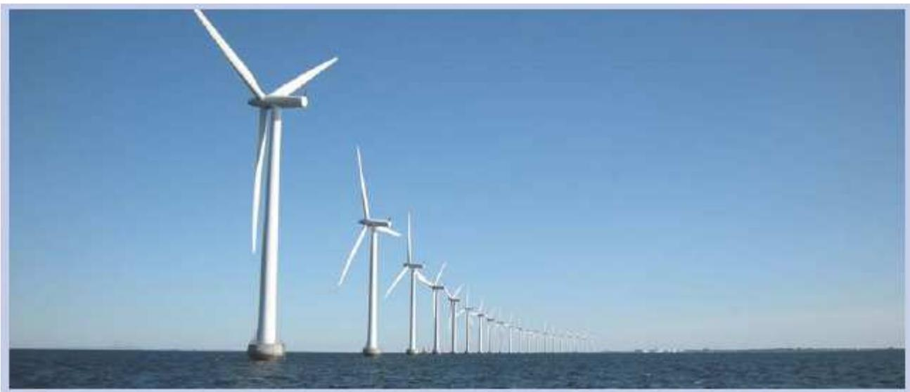
*Fig. A-8b. Turbine su fondazione a gravità ad impianto realizzato (Middelgrunden)*
