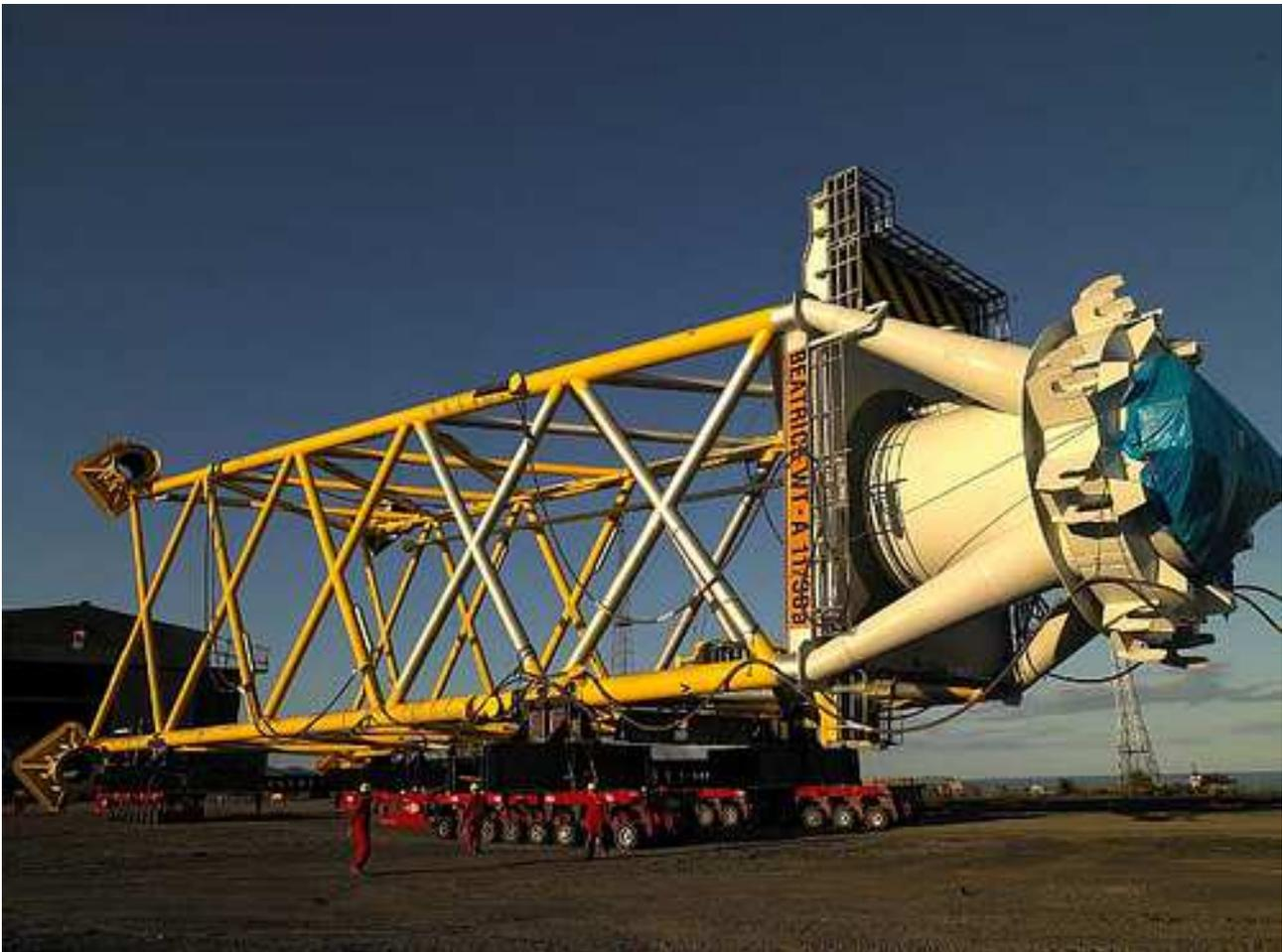
*Fig. B-8a. Castello a jacket per turbina 5M, dotato di tronchetti di fissaggio al fondale (che sono fissati al piede dei montanti e che servono di guida per i pali di fondazione), durante il trasferimento a terra verso la darsena*
