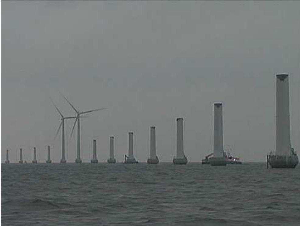
*Fig. A-8a. Montaggio di turbine eoliche su fondazione a gravità (Middelgrunden)*
