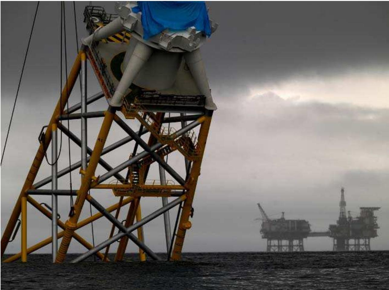
*Fig. B-8d. Immersione della struttura portante della Fig. B-8a e discesa nella sua posizione finale del sito a mare*
