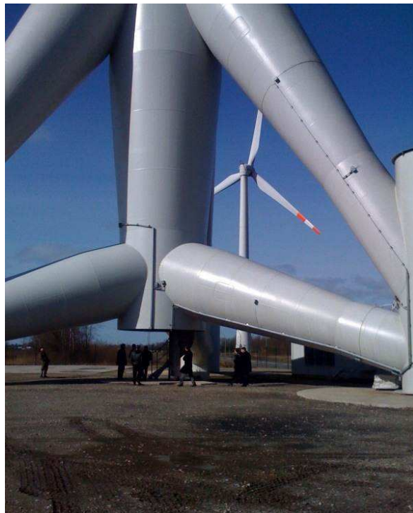
Fig. 3-3i. Altra vista del prototipo realizzato a terra con il particolare del collegamento della candela centrale con le gambe periferiche
