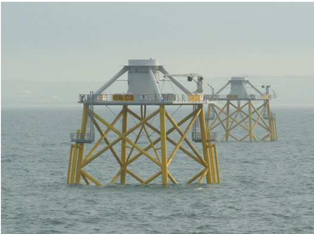
Fig. 3-4m. Fondazioni a castello in attesa del montaggio delle turbine (Ormonde)
