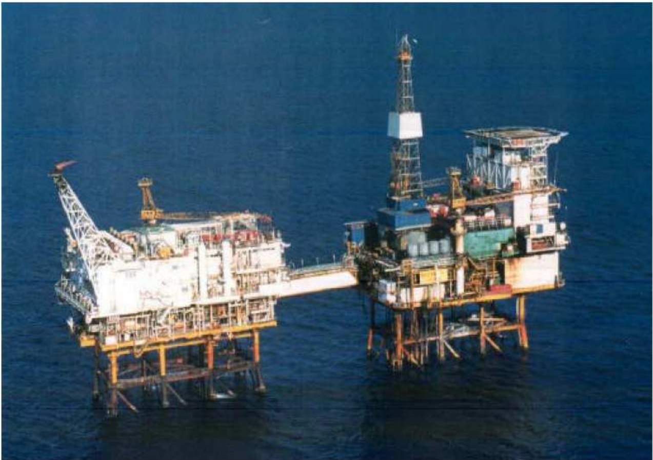
Fig. 2-8b. Piattaforme accoppiate per sfruttamento di giacimento petrolifero (Alpha Beatrice)
