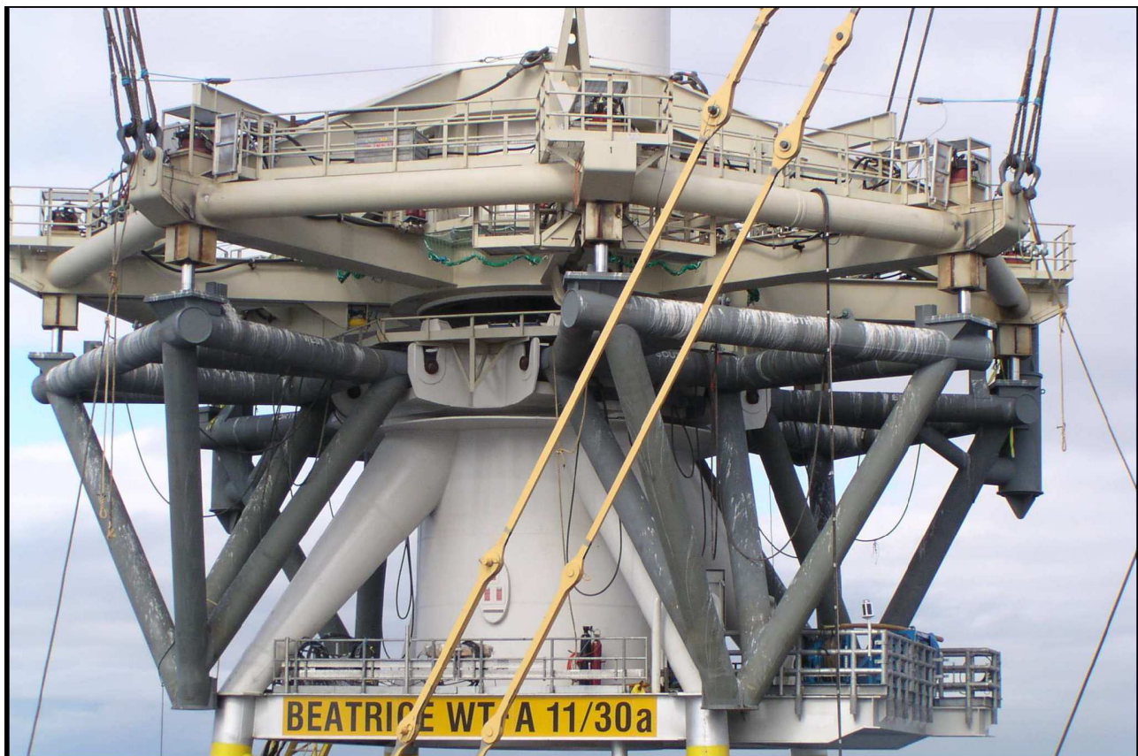
Fig. 2-12a. Attrezzamento della base della torre di unità 5M su analogo apprestamento sulla sezione di transizione della struttura fondaria (Beatrice Windfarm)
