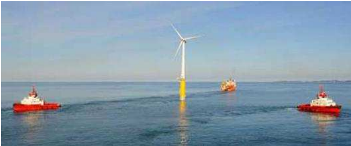
Fig. 3-5b. Unità Hywind in trasporto verso il sito finale (StatoilHydro)
