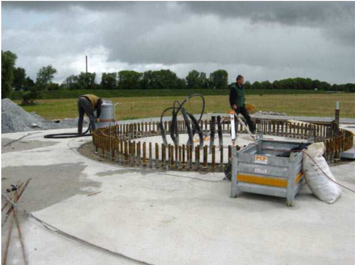
Fig. 1-2. Basamento di turbina 5M con i bulloni di fondazione (REpower)
