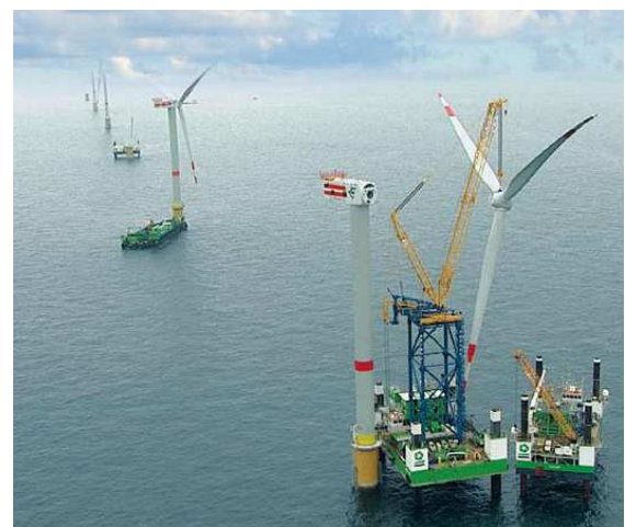
Fig. 3-1m. Unità con fondazione a gravità per turbina eolica 5M (Thornton Bank)
