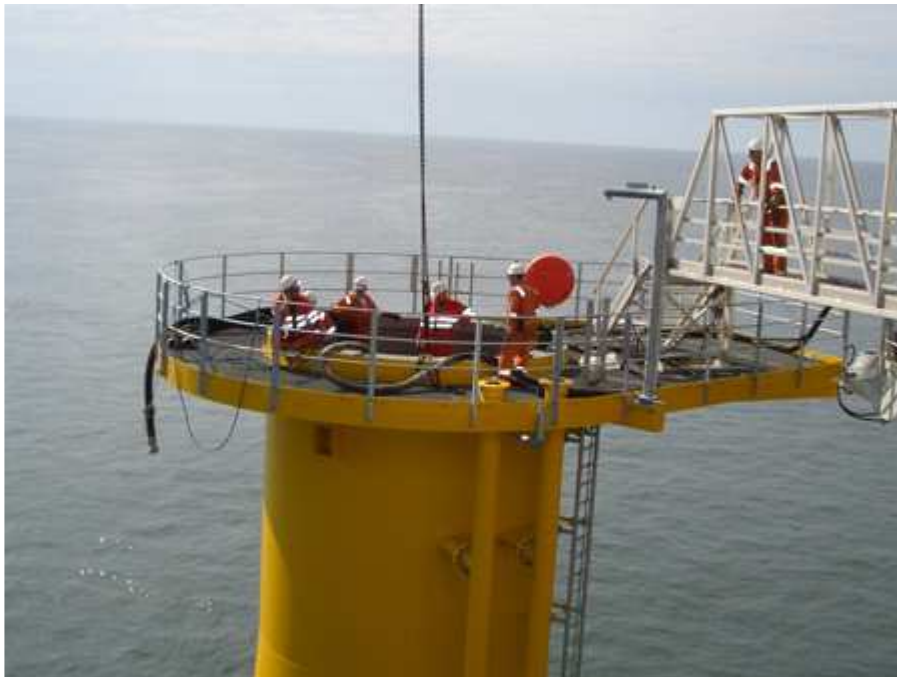
Fig. 3-2c. Piattaforma in cima alla fondazione a monopila (Barrow)
