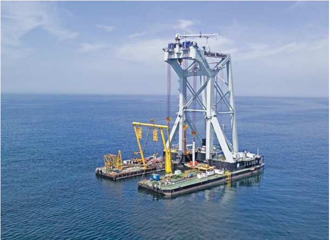
Fig. 3-2h. Crane barge "Svanen" all'installazione del transition piece di un monopila (Gunfleet)
