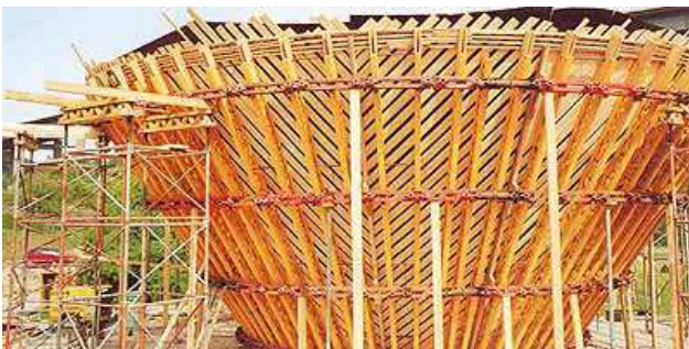
Fig. 3-1d. Centinatura del calice superiore in c.a. della fondazione a gravità (Middelgrunden)
