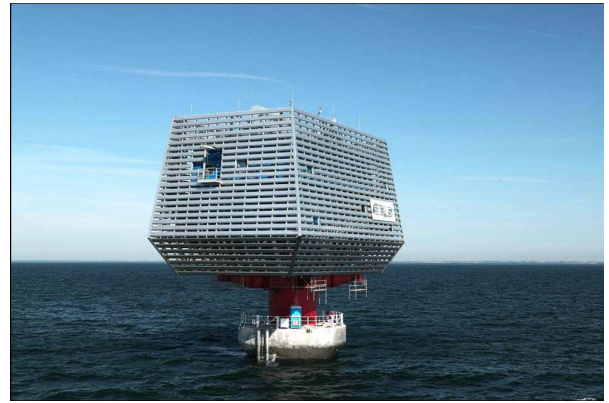
Fig. 3-1y. SSE a montaggio completato (Nysted)
