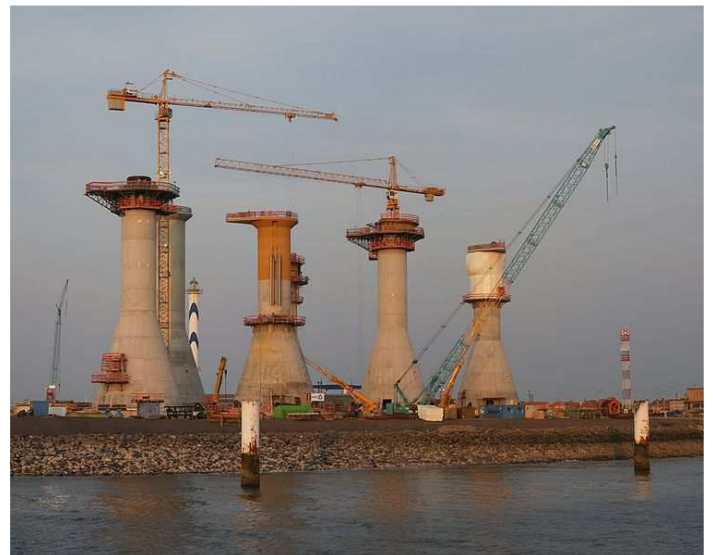
Fig. 3-1f. Fondazioni a gravità quasi completate
