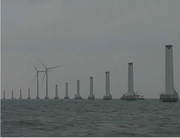
Fig. 3-1h. Impostazione delle torri su fondazioni a gravità ed installazione dei rotori delle turbine (Middelgrunden)
