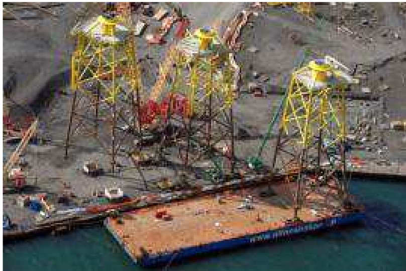
Fig. 3-4p. Strutture in fase di caricamento su pontone (Ormonde)
