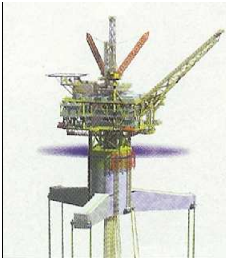
Fig. 3-5d. Tensostruttura di sostegno di fondazione semisommersa per prospezioni petrolifere, il cui concetto potrebbe essere impiegato per soluzioni analoghe nel settore eolico
