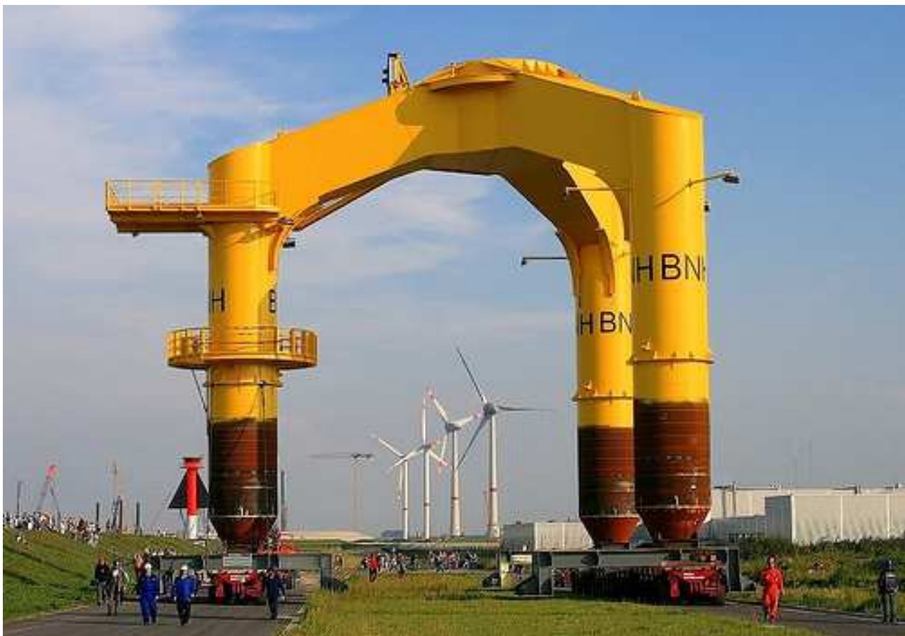
Fig. 3-3f. Struttura pluripile in spostamento verso l'imbarco a Cuxhaven (De)
