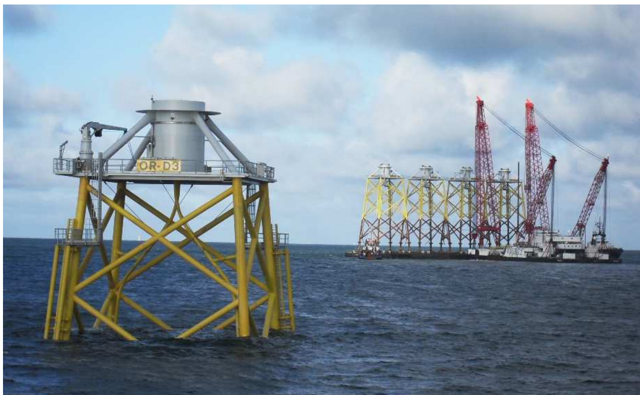
Fig. 3-4o. Struttura portante installata e mezzo per trasporto/montaggio carico di altre quattro unità in movimento verso il sito eolico (Ormonde)
