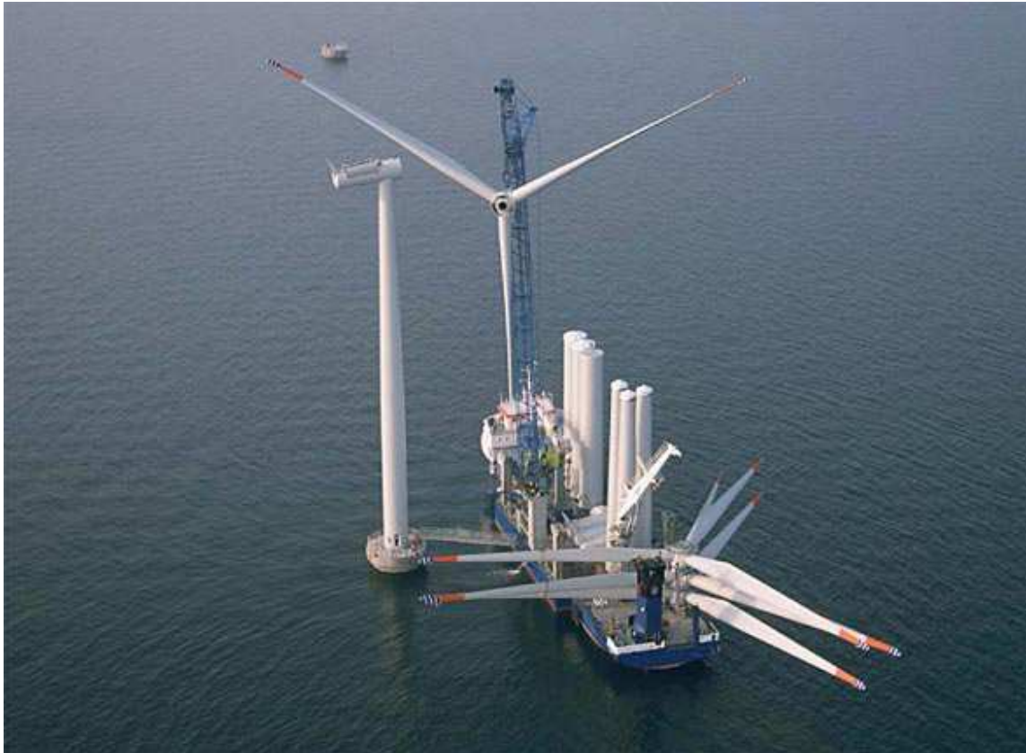
Fig. 2-5b. Costruzione della prima turbina eolica del parco di Nysted
