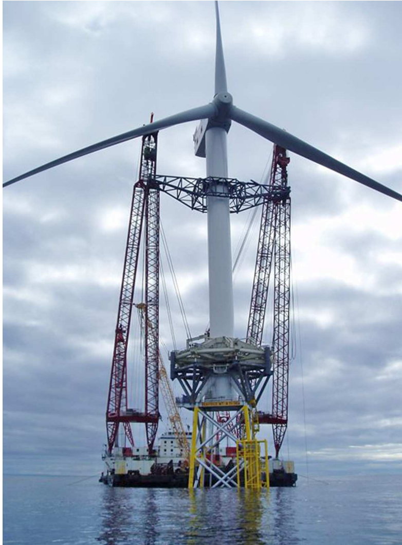
Fig. 3-4i. Trasporto ed installazione di turbina REpower 5M al largo delle coste scozzesi (sistemazione su jacket a 4 montanti mediante pontone attrezzato con gru di diversa gittata in prospettiva)
