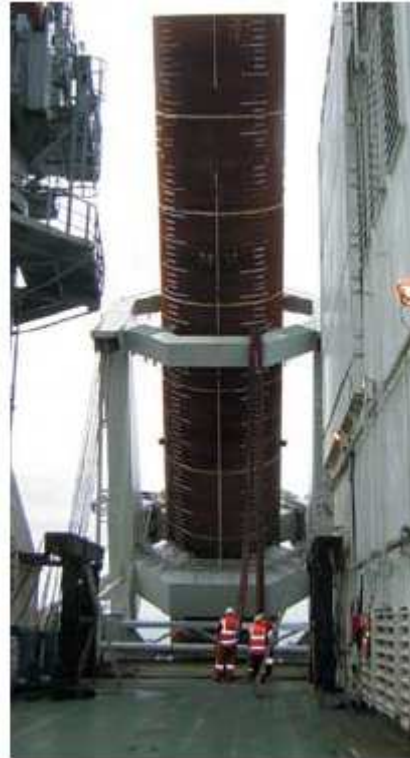
Fig. 3-2e. Scarico di monopila in situ
