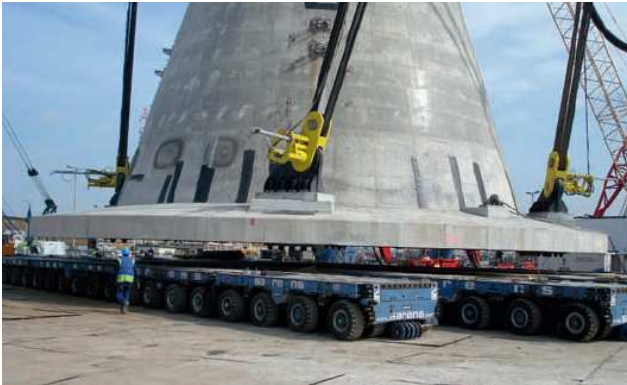
Fig. 3-1n. Trasporto della fondazione sul bordo della darsena per poterla varare (Thornton Bank)
