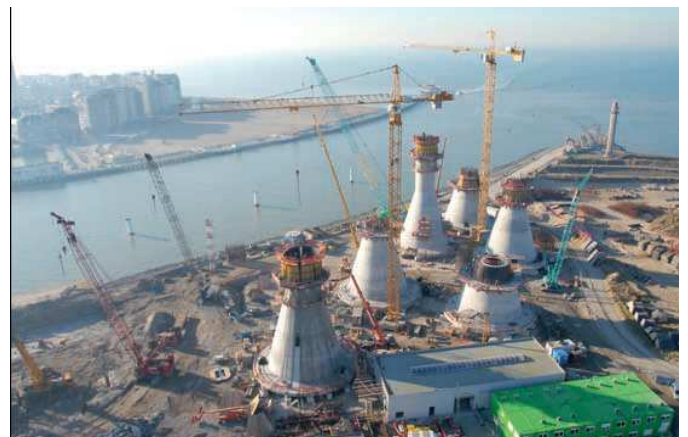
Fig. 3-1g. Visione del cantiere (Thornton Bank)
