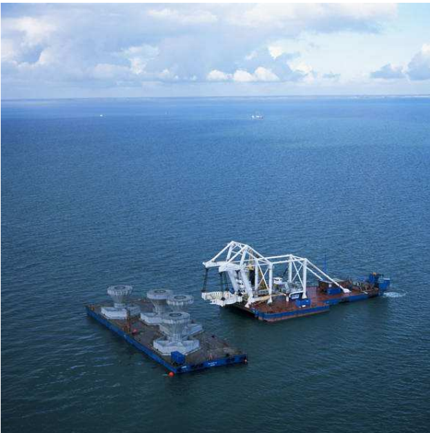
Fig. 3-1l. Posizionamento delle fondazione a gravità (Lillgrund)
