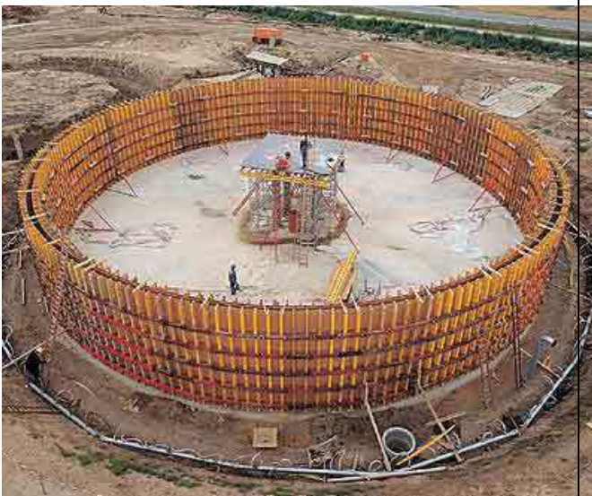
Fig. 3-1c. Centinatura del tamburo di base di fondazione a gravità (Middelgrunden)
