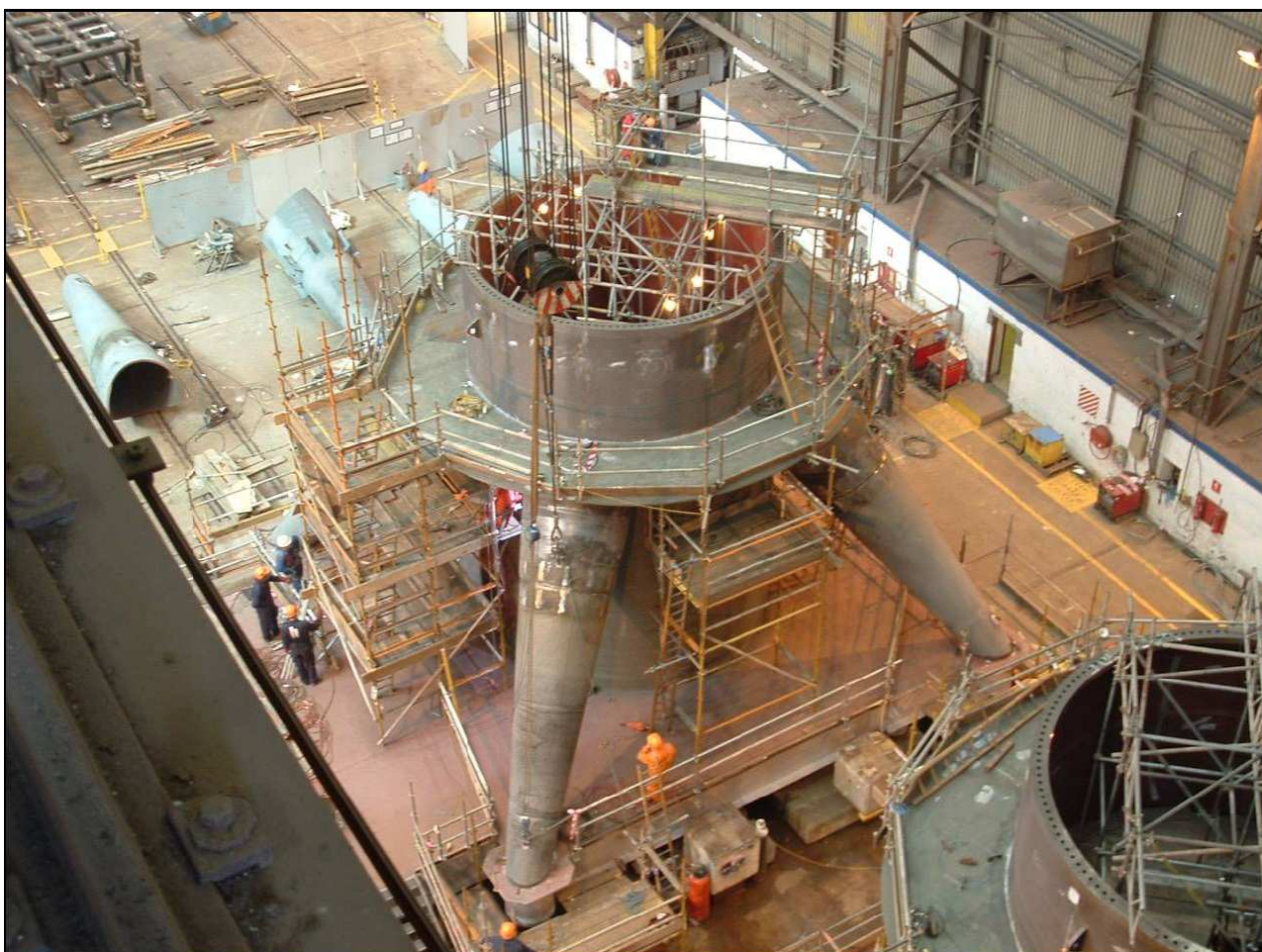
Fig. 2-12b. Costruzione della sezione di transizione della fondazione per 5M (Beatrice W.f.)
