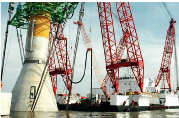
Fig. 3-1n. Trasporto della fondazione sul bordo della darsena per poterla varare (Thornton Bank)
