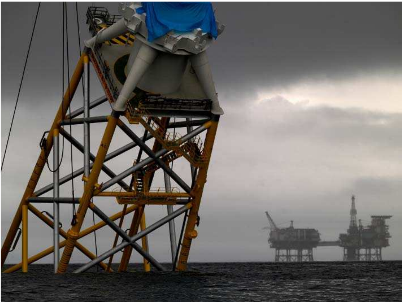
Fig. 2-11. Immersione della struttura portante della Fig. 1-1 e discesa nella sua posizione finale del sito a mare (sul coronamento è evidente la transizione jacket-torre)
