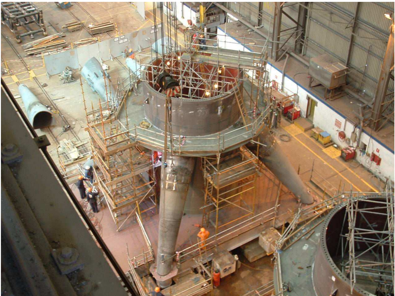
Fig. 3-4d. Fabbricazione dell'elemento di transizione per le unità Beatrice (Burntisland Fabrications Ltd.)
