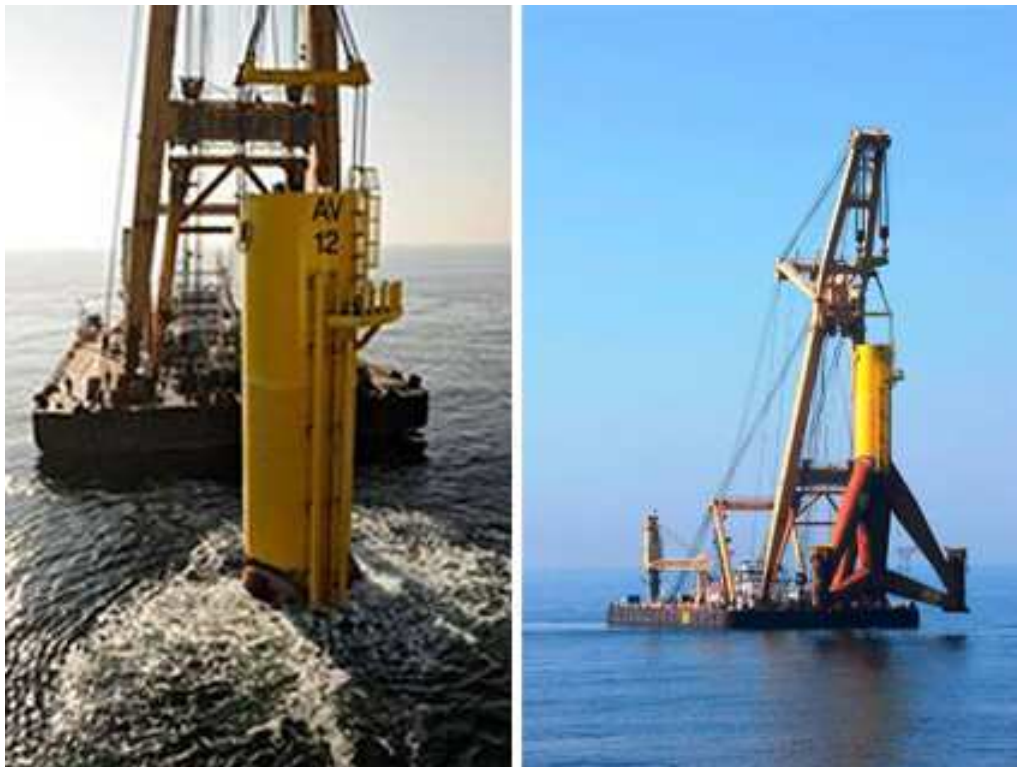
Fig. 3-3n. Tripode Multibrid Areva in fase di installazione
