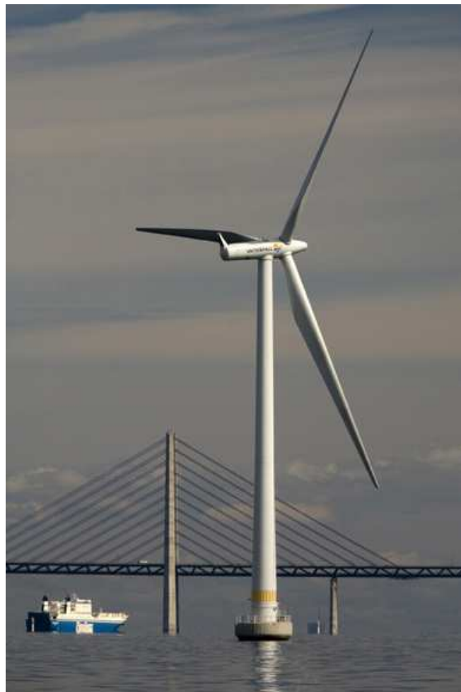
Fig. 2-2. Aerogeneratore da 2,3 MW su fondazione a gravità del campo eolico di Lillgrund (Sv)
