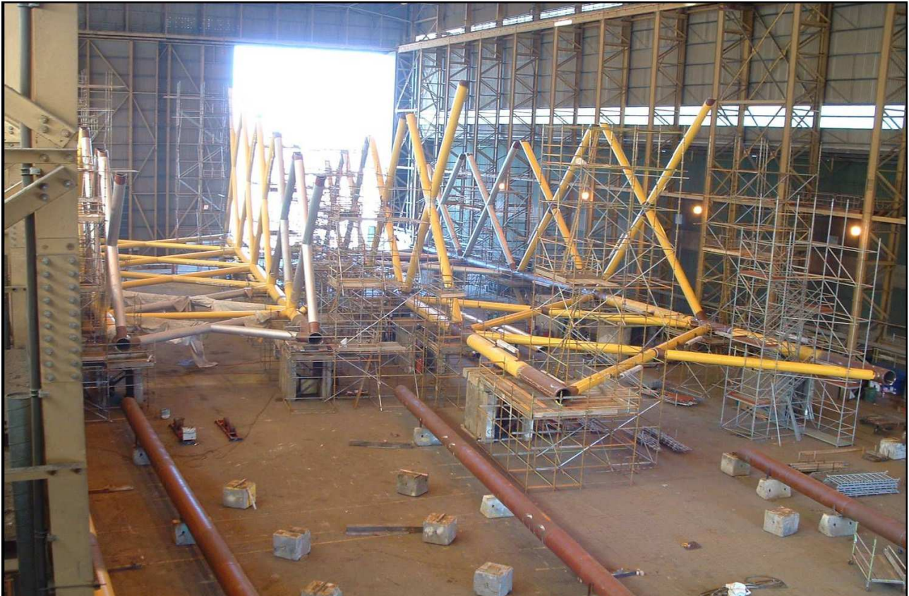
Fig. 3-4l. Sottostruttura fondaria per turbine REpower 5M del progetto Beatrice (Burntisland Fabrications Ltd.)
