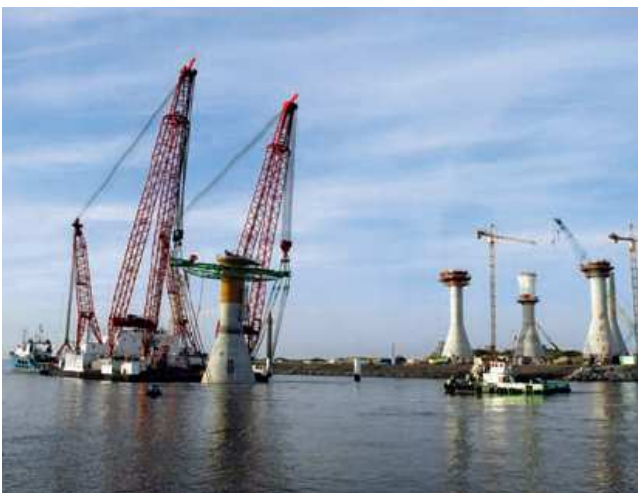
Fig. 3-1o. Varo ed affondamento della fondazione (Thornton Bank)
