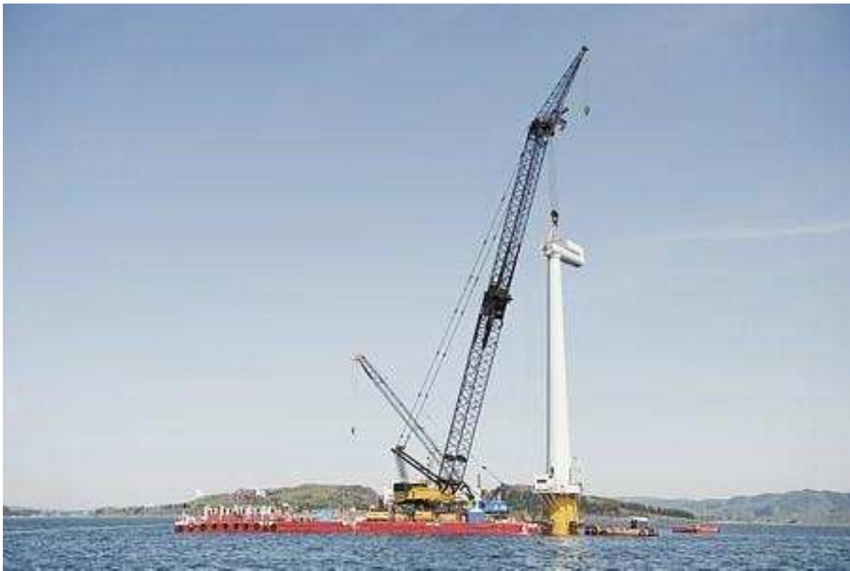
Fig. 3-5a. Hywind in fase realizzativa (StatoilHydro)
