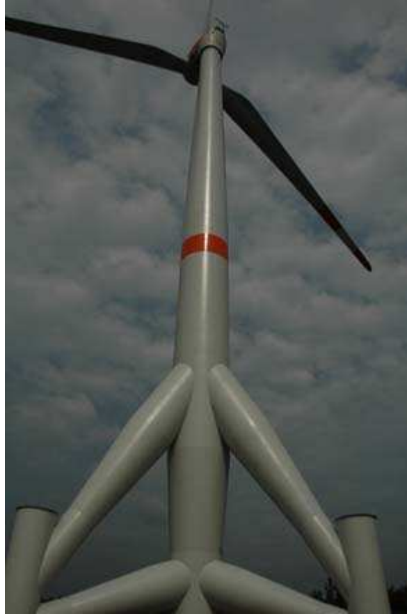
Fig. 3-3h. Vista ravvicinata del sistema portante per M5000 (Multibrid)
