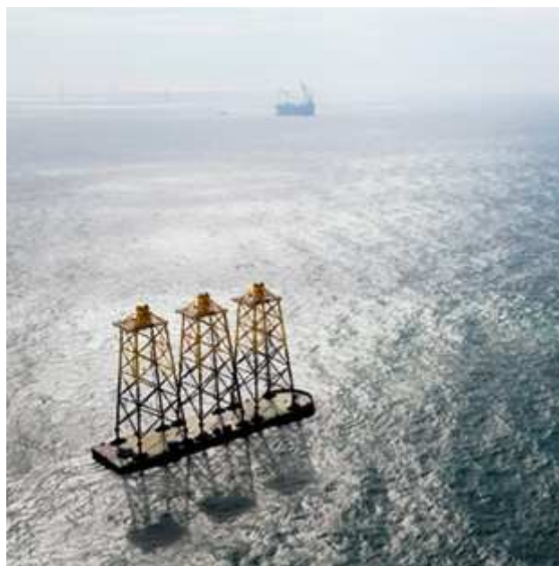
Fig. 3-3p. Strutture a castello in trasporto a mare (Alpha Ventus)
