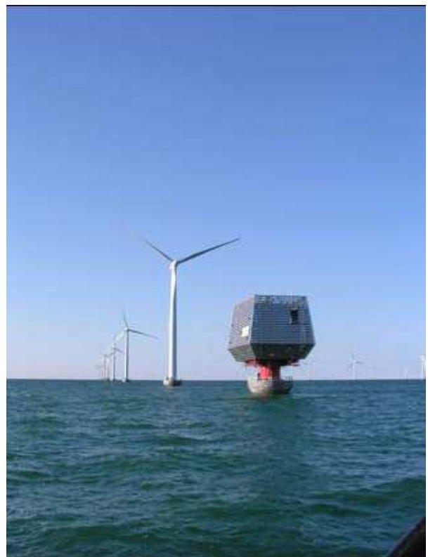
Fig. 3-1z. Vista del campo eolico con la SSE in primo piano (Nysted)
