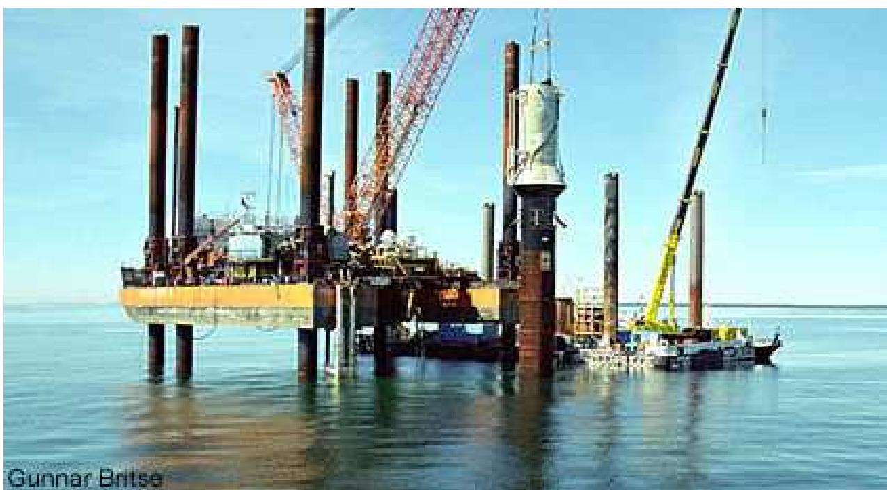
Fig. 3-2d. Struttura a monopila in fase di inserimento nel fondale per azione del battipalo, che è applicato sulla sua estremità superiore (North Hoyle)
