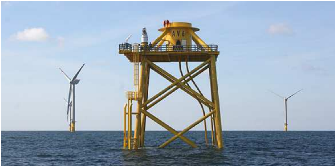
Fig. 3-3o. Struttura a castello per le unità REpower del sito Alpha Ventus
