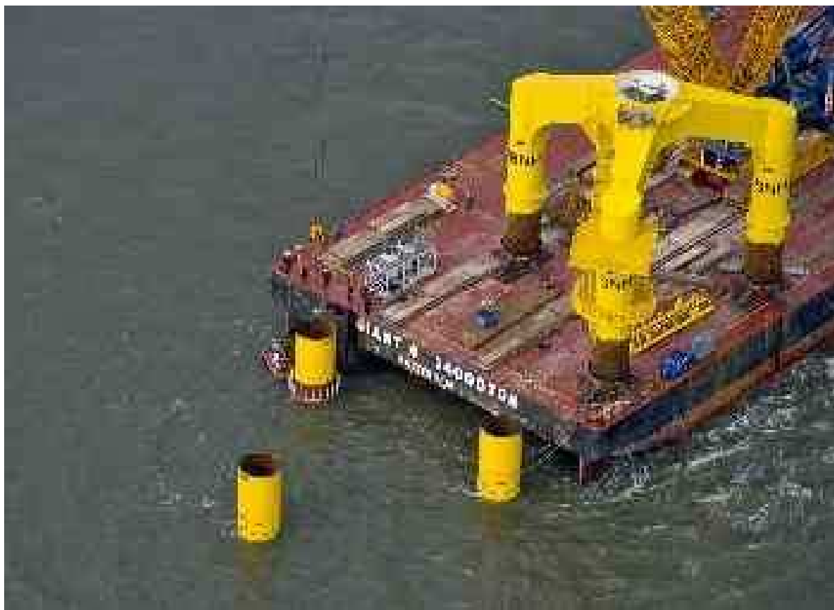
Fig. 3-3g. Preparazione all'installazione a mare
