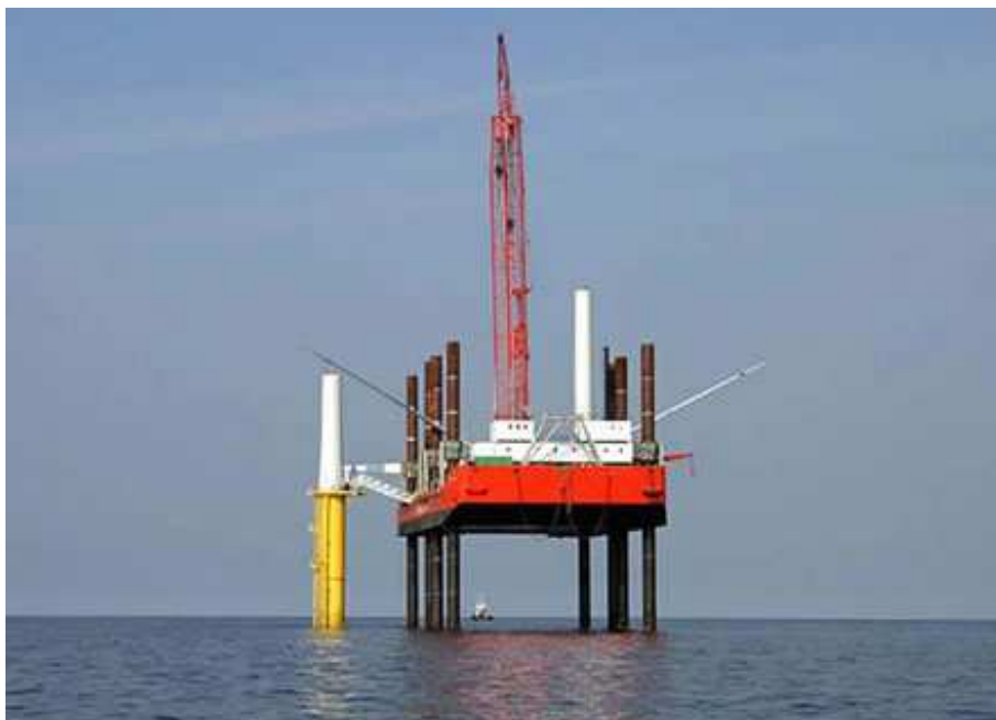
Fig. 3-2f. Erezione di torre su struttura monopila già in situ (North Hoyle)
