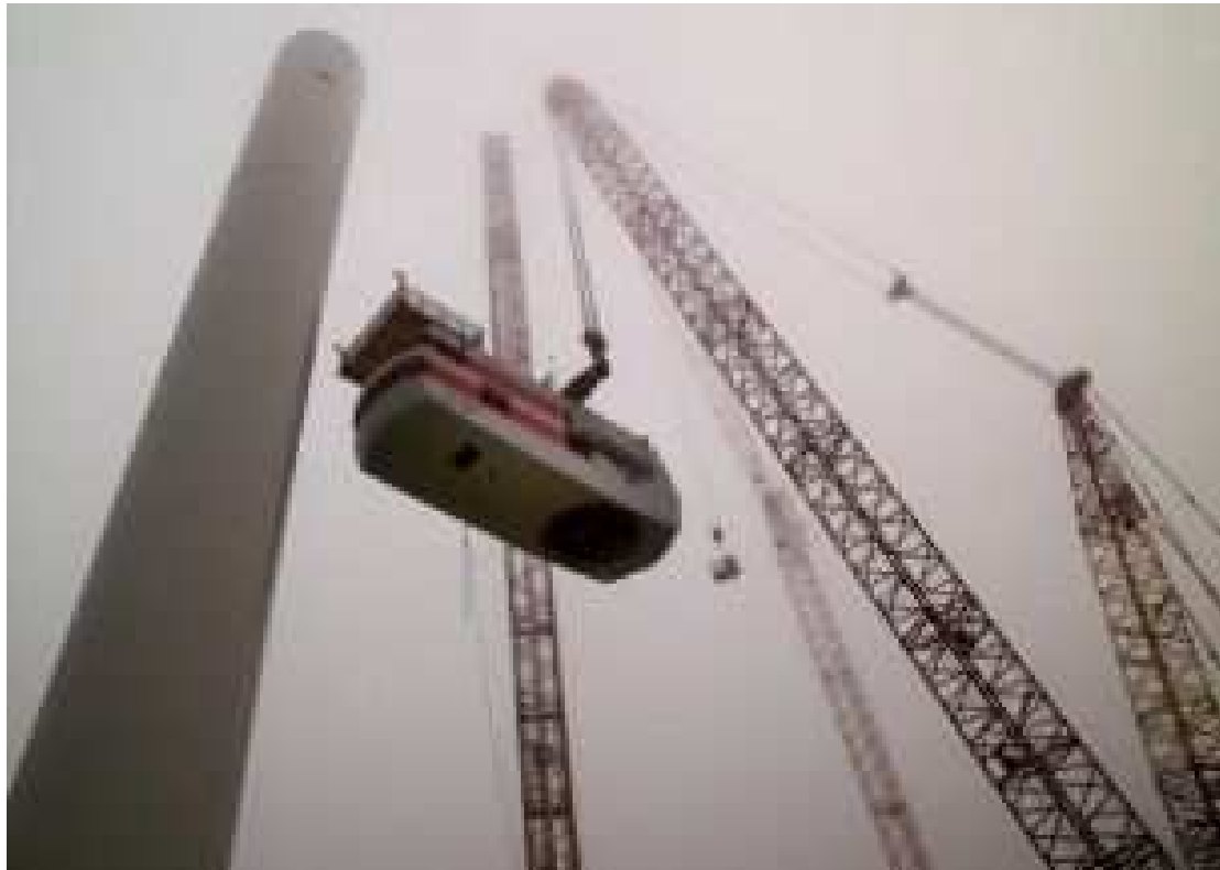
Fig. 3-3g. Mezzi di sollevamento nella movimentazione della navicella
