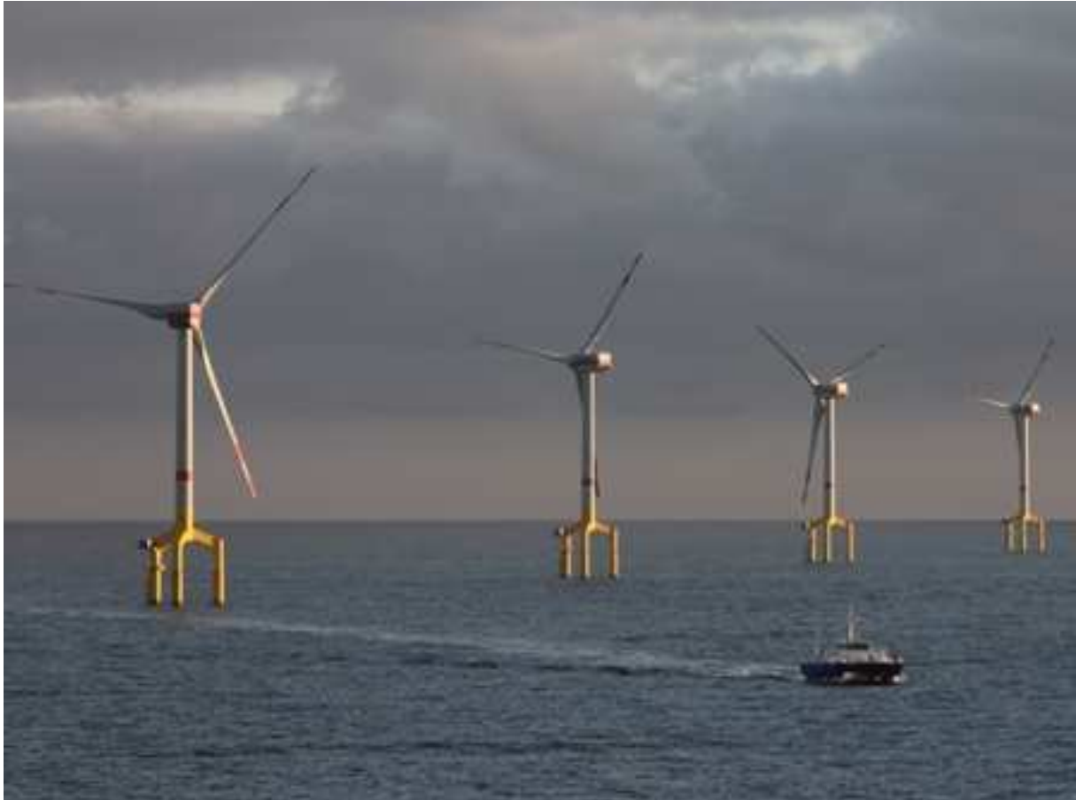
Fig. 2-2a. Campo Bard Offshore 1 di circa 60 kmq, costituito da 80 unità Bard 5 MW su fondale da 30-40 m di profondità a circa 90-100 km dall'isola di Borkum (DE)
