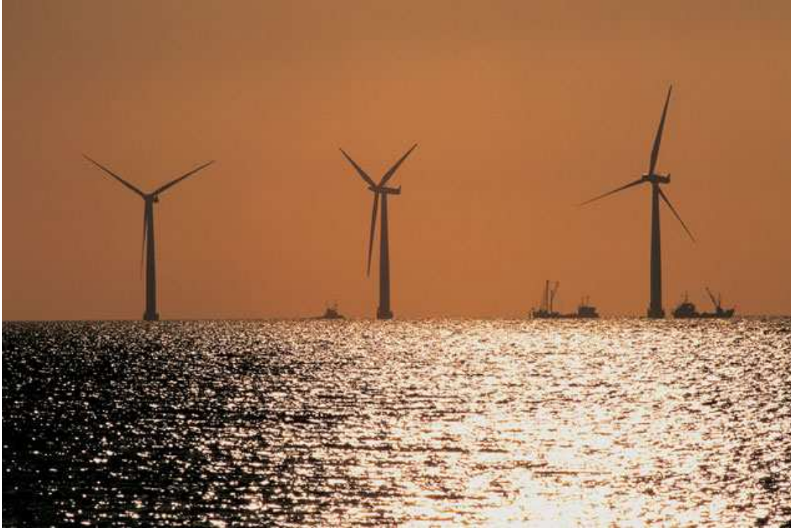
Fig. 3-3n. Impianto di Samsø (Dk), composto da 10 unità (Bonus 2,3 MW)
