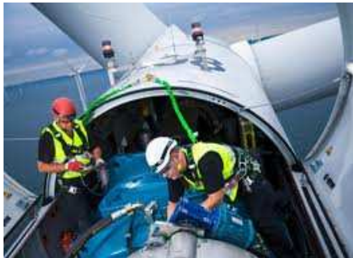
Fig. 3-3d. Manutenzione in navicella
