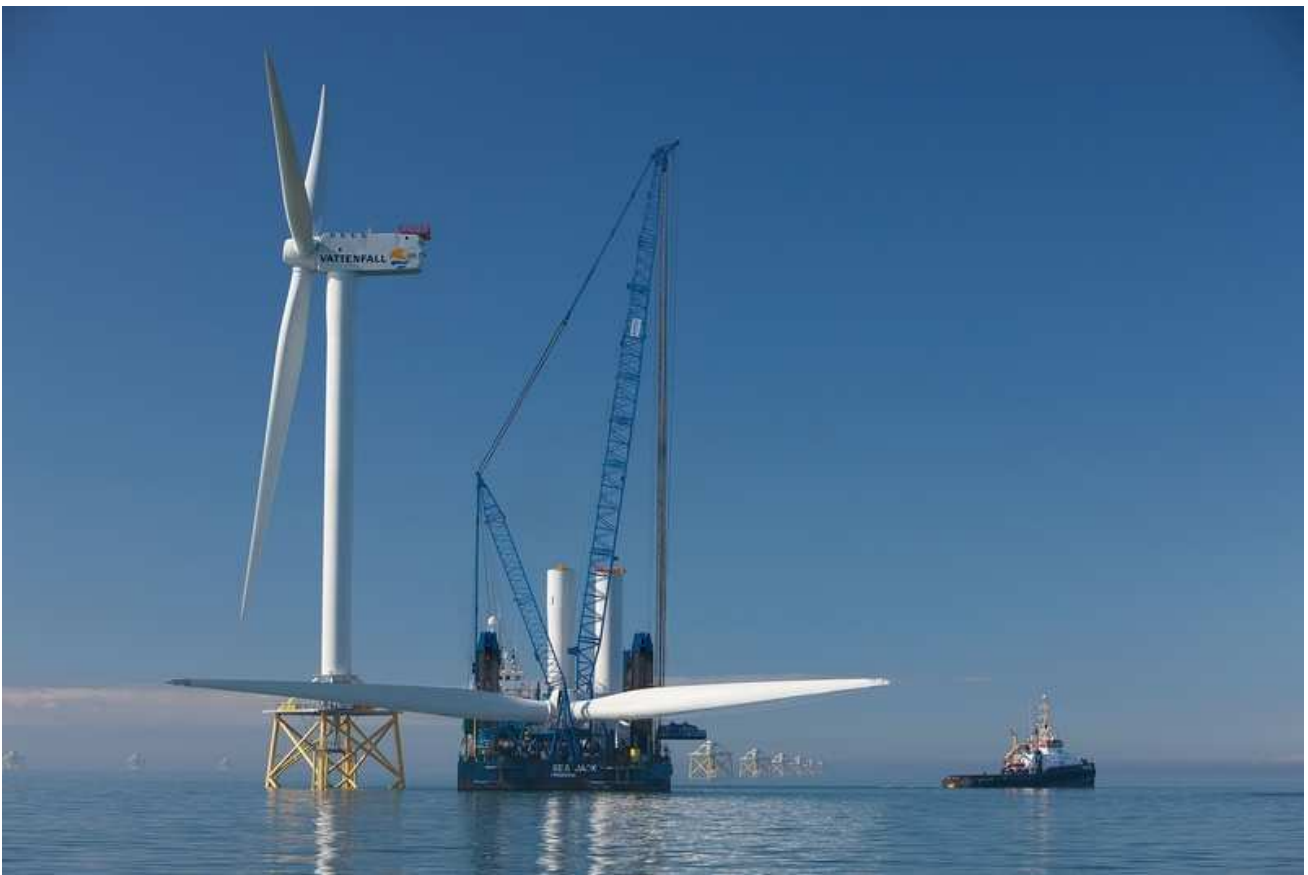
Fig. 1-2a. Fase installativa della turbina da 5 MW (Ormonde)
