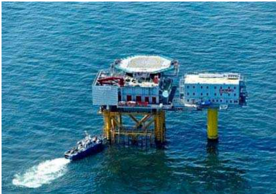
Fig. 3-3a. Sottostazione elettrica con aggiunta foresteria (accomodation platform) ad Horns Rev (dongenergy)
