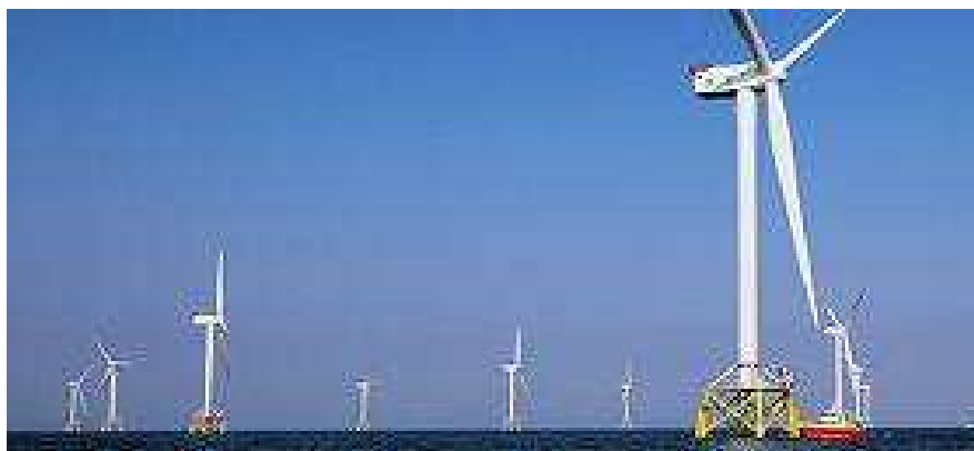
Fig. 3-3b. Impianto finito con unità alla manutenzione (Ormonde)
