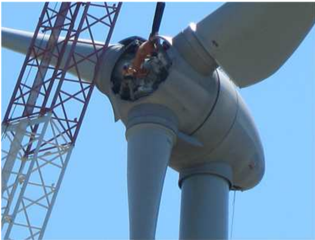
Fig. 3-3h. Intervento alla connessione rotore-naso del mozzo
