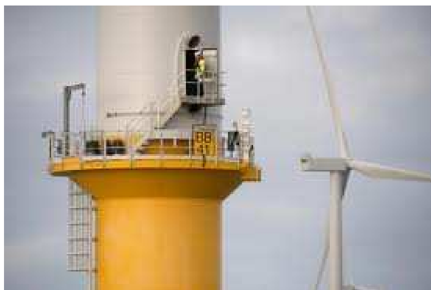
Fig. 3-3c. Piattaforma e porta di accesso
