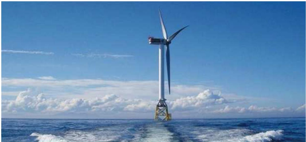
Fig. 3-1. Struttura portante a jacket per turbina eolica 5M montata a Moray Firth (REpower)
