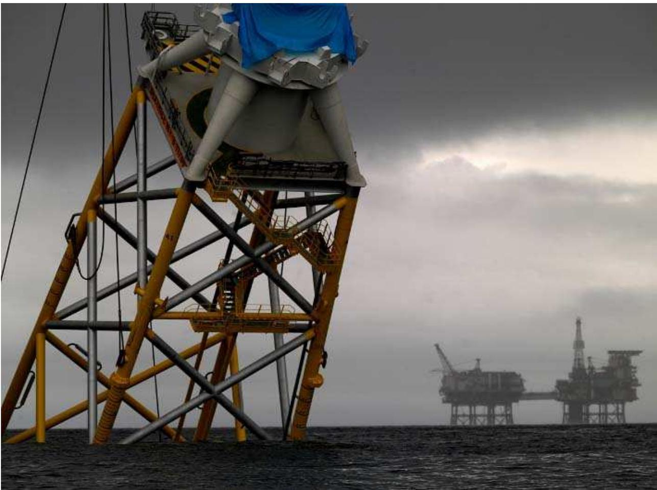
*Fig. 2-9. Immersione della struttura portante della Fig. 1-1 e discesa nella sua posizione finale del sito a mare (sul coronamento è evidente la transizione jacket-torre)*
