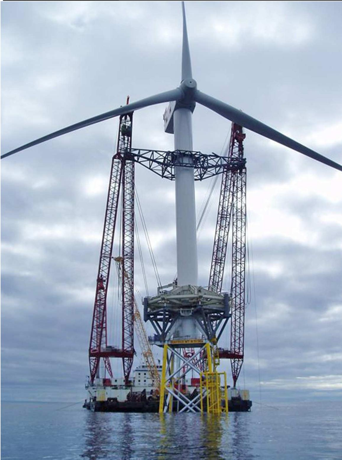
*Fig. 1-2. Completamento del montaggio di turbina 5M (sistemazione su jacket a 4 montanti mediante pontone attrezzato con gru di diversa gittata in prospettiva) nel Mar del Nord al largo delle coste scozzesi (REpower)*
