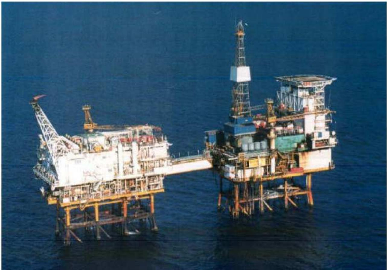
Fig. 2-8. Piattaforme accoppiate per sfruttamento di giacimento petrolifero (Alpha Beatrice)
