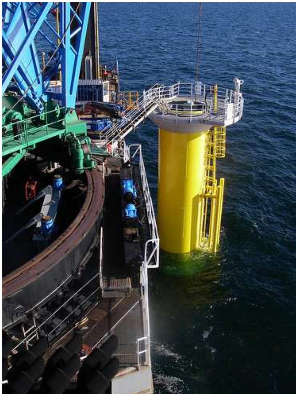
*Fig. 2-4. Struttura fondaria a monopila per turbina eolica durante i montaggi (Horns Rev)*
