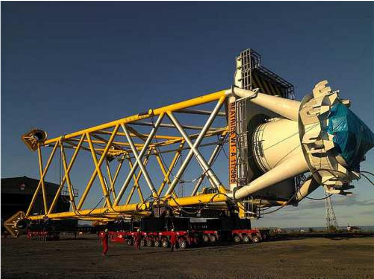
*Fig. 2-19. Castello a jacket per turbina 5M, dotato di tronchetti di fissaggio al fondale (che sono fissati al piede dei montanti e che servono di guida per i pali di fondazione), durante il trasferimento a terra verso la darsena*
