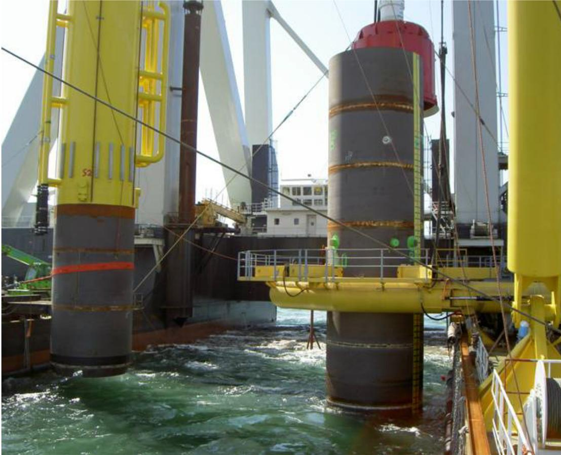
*Fig. 6-2b. Lavori per l'inserimento di monopila nel fondale (Egmon aan See)*
