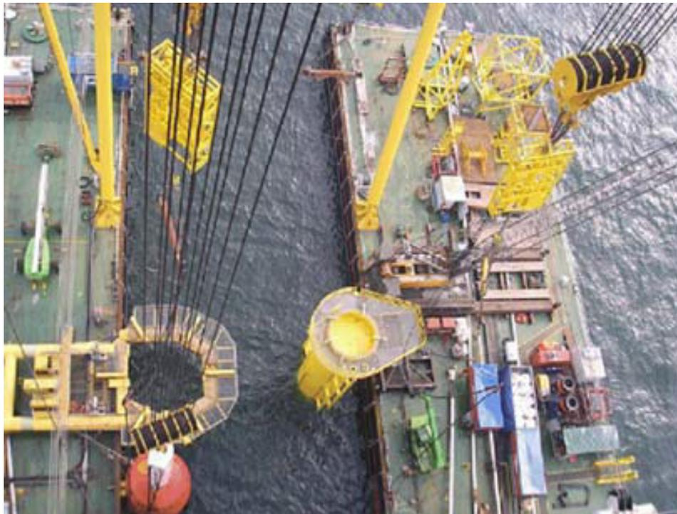
Fig. 6-2c. Vista dall'alto del pontone Svanen a TP installato su monopila (Egmon aan Zee)
