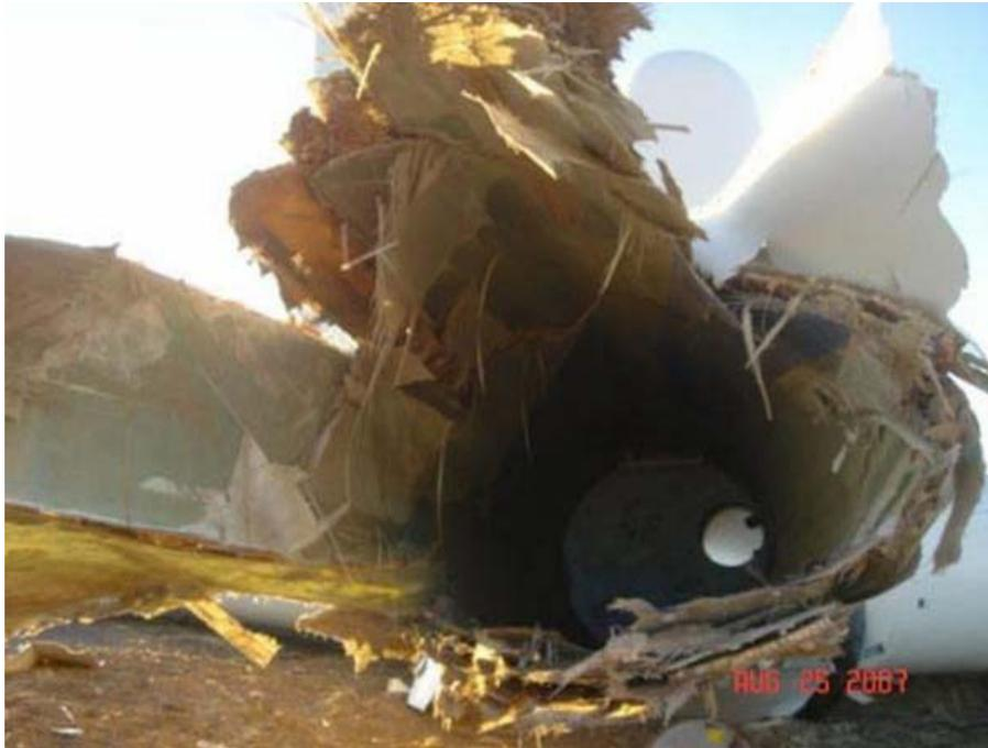
*Fig. 6-2e. Esempio di collasso di torre*
