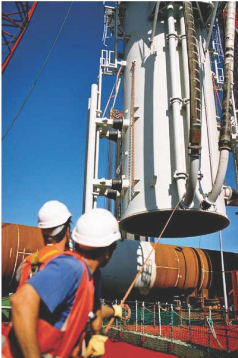
*Fig. 5-2b. Operazioni di sollevamento per montaggio della sezione terminale di fondazione monopila equipaggiata con tubi per la discesa dei cavi elettrici di potenza, con scalette per l'accesso di personale alla turbina e con opportuni ripari contro urti da natanti per sbarco di personale e/o materiale leggero*
