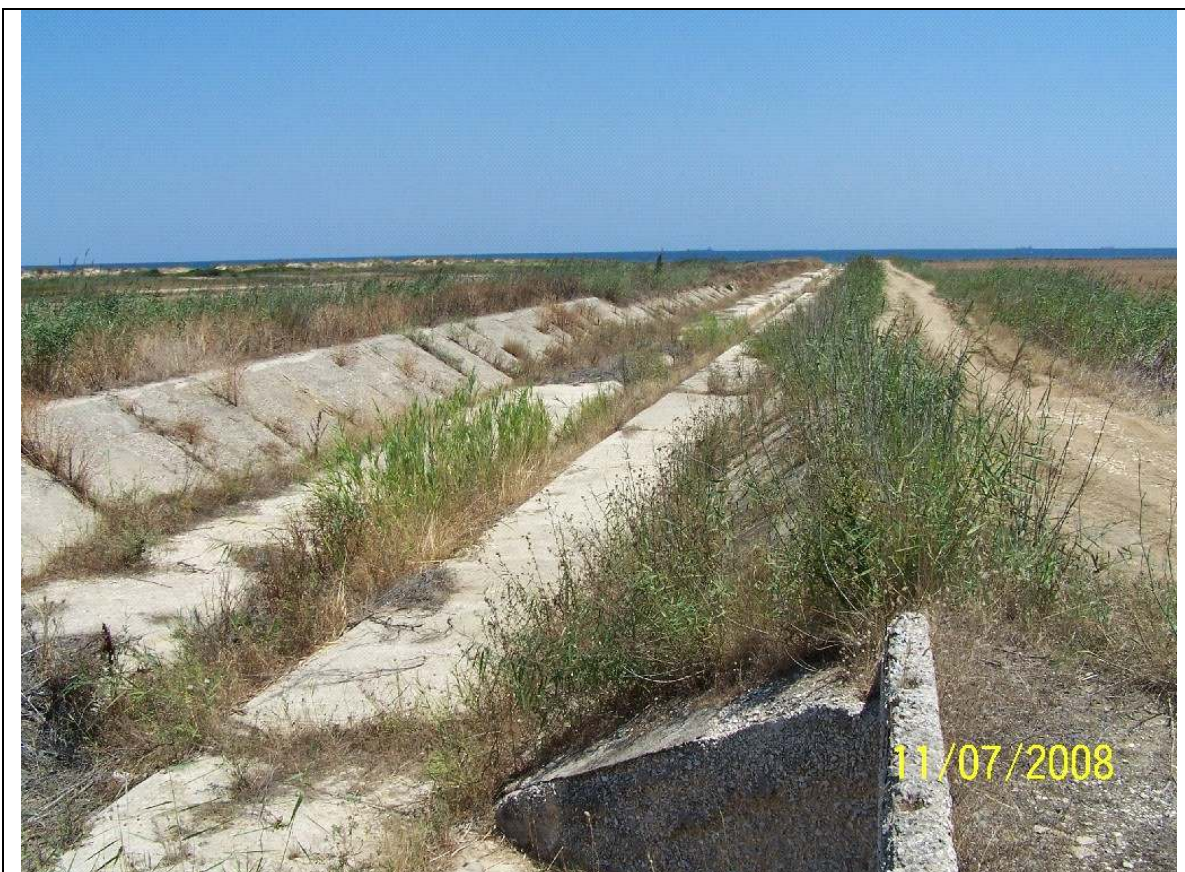
Foto 9 – Tratto terminale del Canale Foggia di Rau.
