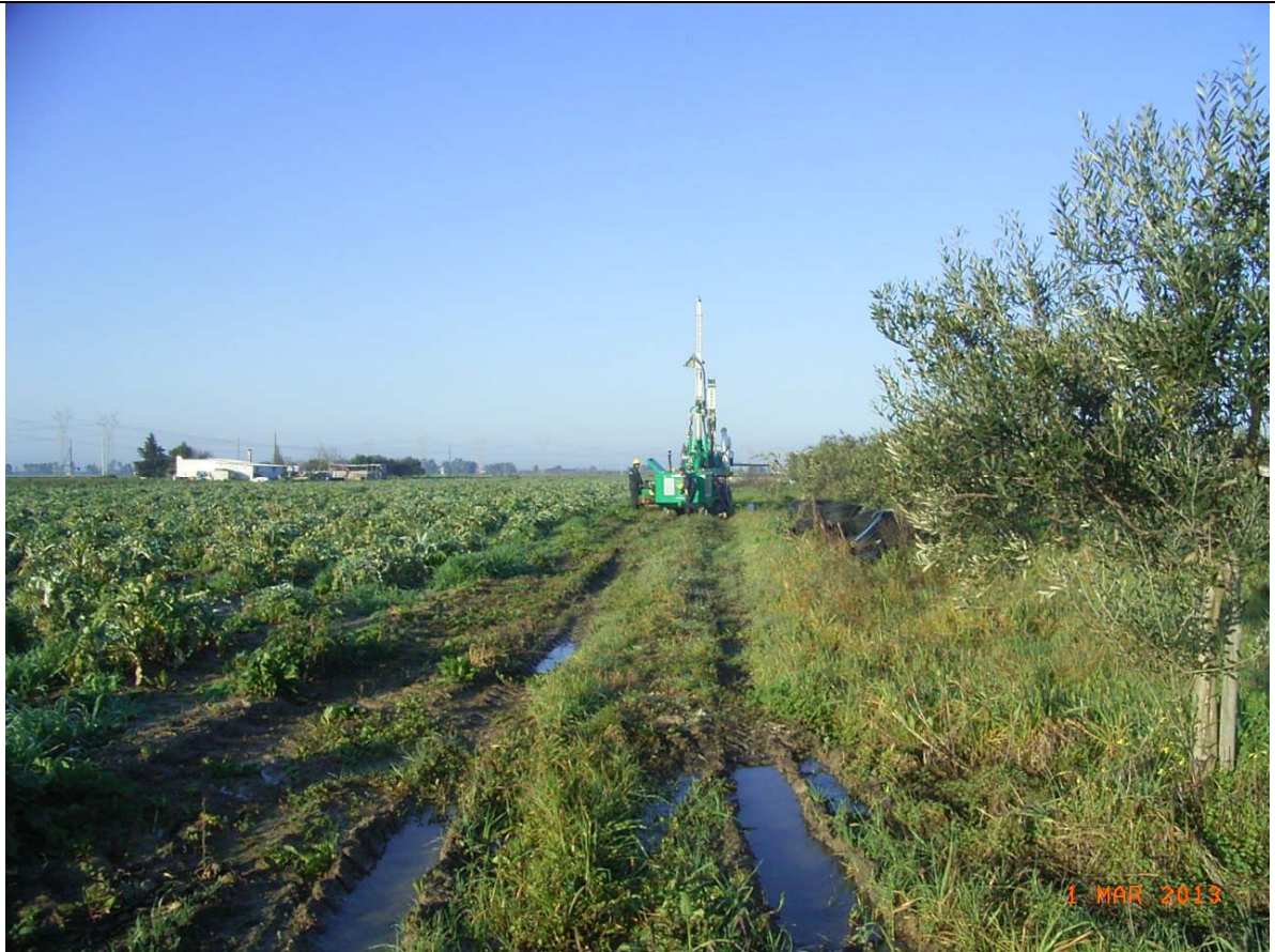
Foto 1 – Fase di esecuzione del sondaggio S1.
