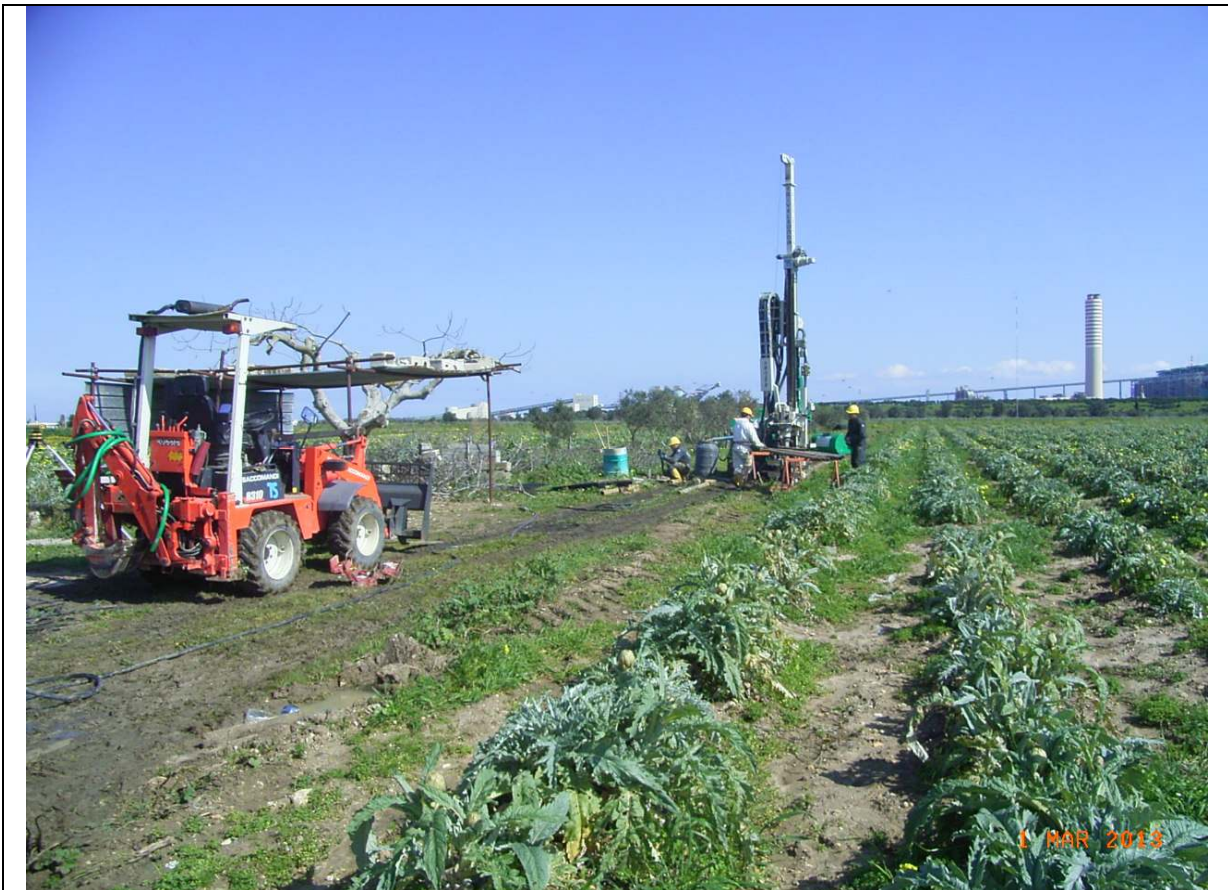
Foto 5 – Fase di esecuzione del sondaggio S2.
