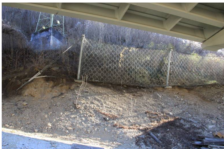
Figura 34 Barriera paramassi localizzata dietro la pila n. 13 del viadotto autostradale “Novale”.
