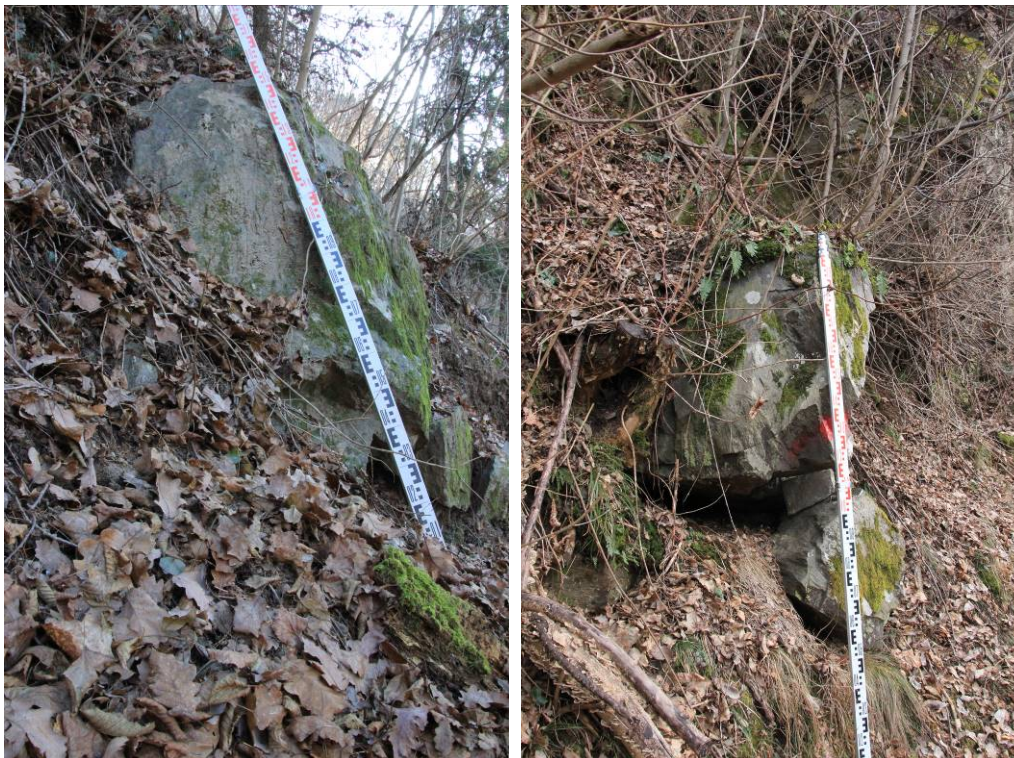
Figura 31. Blocchi isolati con processo di scalzamento al piede in atto.
