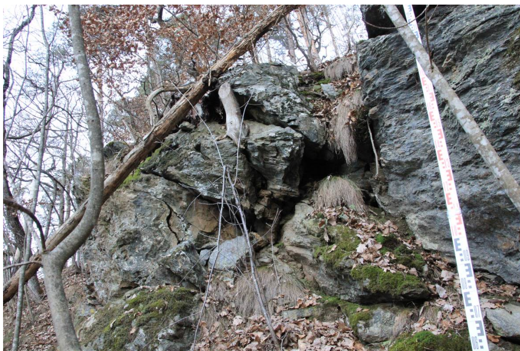
Figura 30. Ammasso roccioso fortemente allentato ed alterato, con fessure di trazione aperte.
