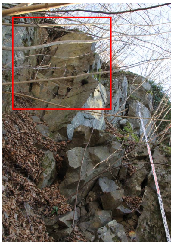
Figura 28. Nicchia di crollo con copertura vegetale rimasta sospesa nel vuoto.
