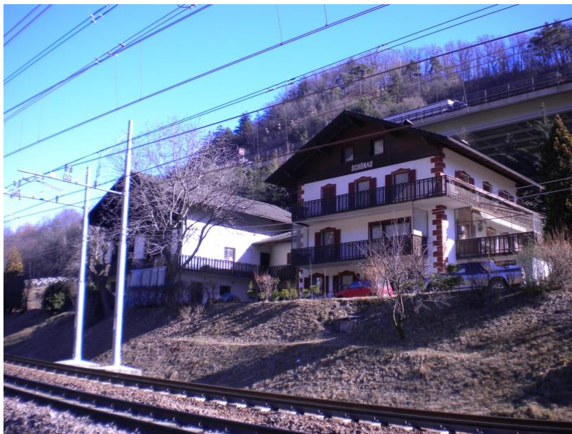
Figura 25 - Maso da demolire
