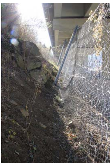
Figura 34 Barriera paramassi localizzata dietro la pila n. 13 del viadotto autostradale “Novale”.
