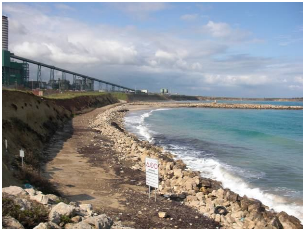
Figura 2.1.2: litorale in corrispondenza della centrale ENEL di Cerano.
