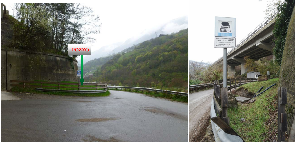
Figura 6-10- Ubicazione pozzo Autostrada - B_000587
