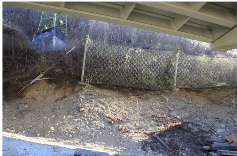
Figura 24. Barriera paramassi localizzata dietro la pila n. 13 del viadotto autostradale “Novale”.
