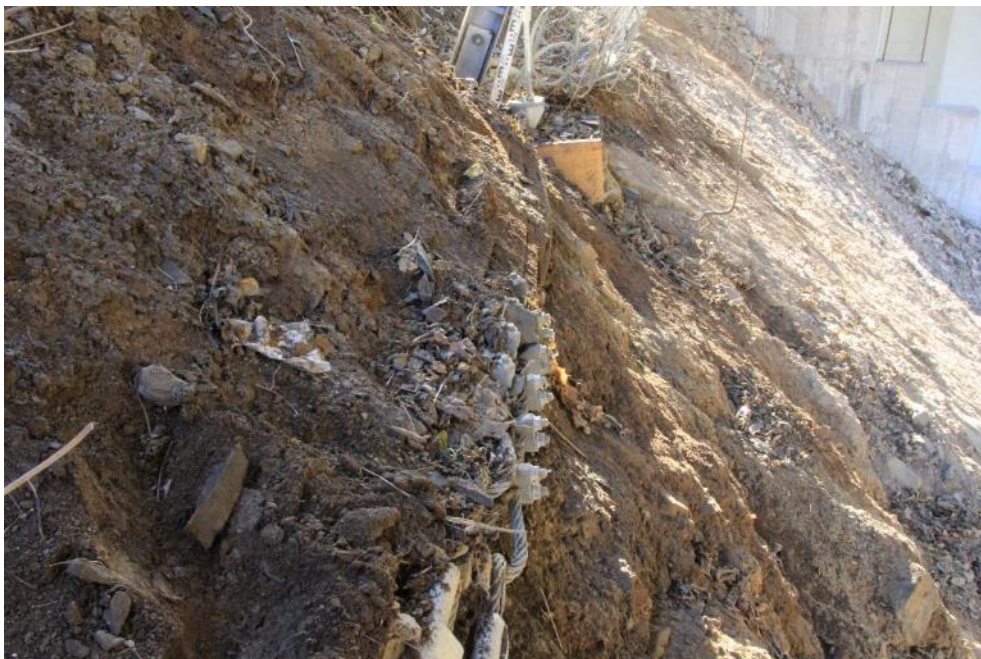
Figura 22. Funi perimetrali basse con sistema frenante sepolte nel detrito.
