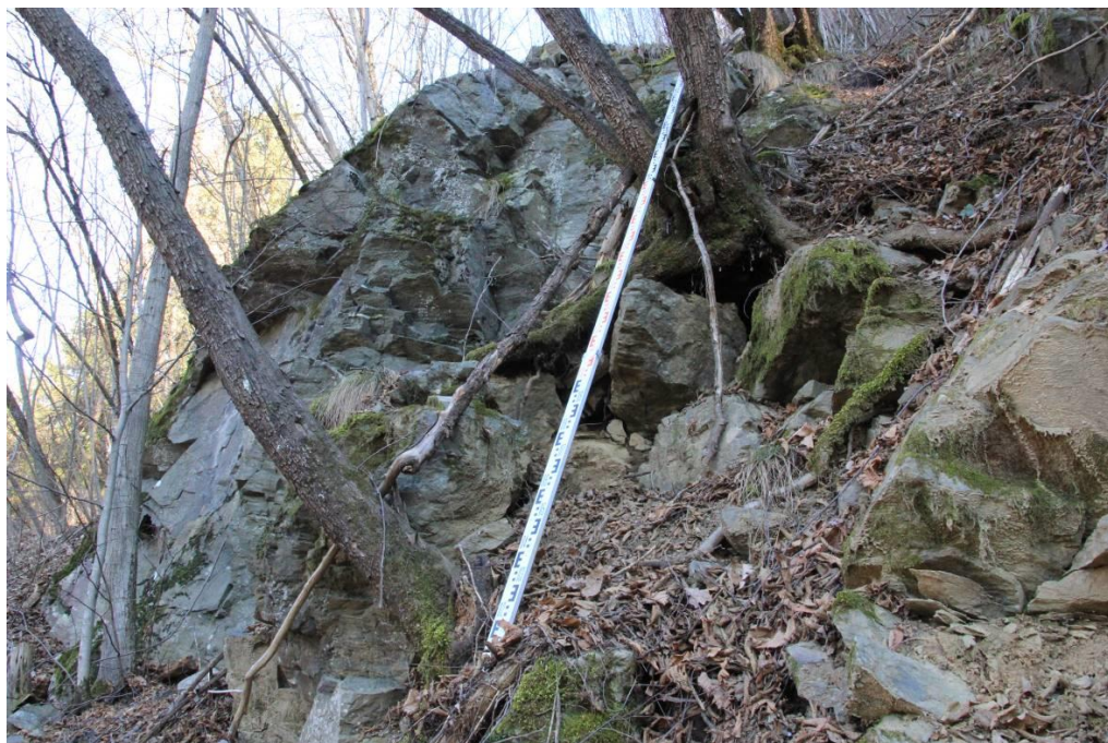
Figura 6. Vegetazione in crescita all'interno dell'ammasso roccioso fratturato.
