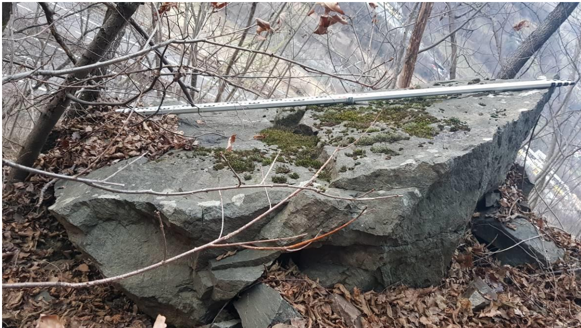
Figura 10. Elementi di crollo presenti al piede delle pareti rocciose affioranti sul pendio.
