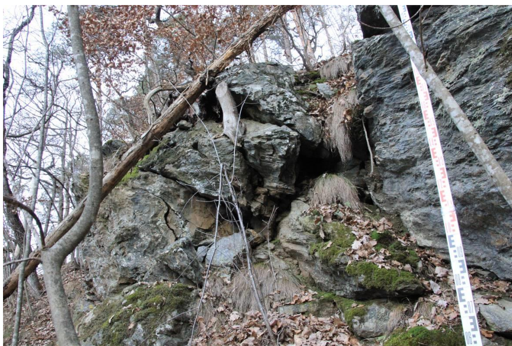
Figura 7. Ammasso roccioso fortemente allentato ed alterato, con fessure di trazione aperte.
