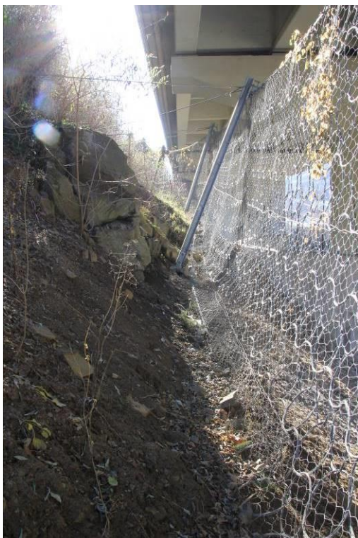
Figura 24. Barriera paramassi localizzata dietro la pila n. 13 del viadotto autostradale “Novale”.
