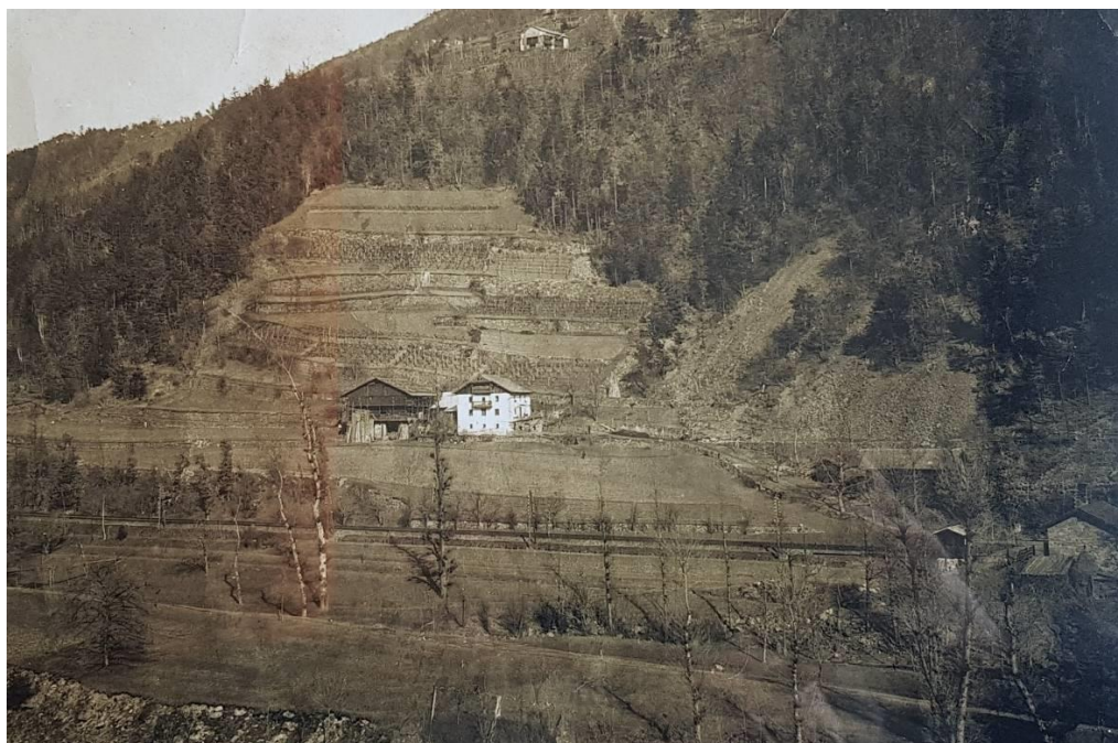
Figura 3. Immagine fotografica del maso “Schönau” prima della sua demolizione per la costruzione del viadotto autostradale, 1900 (archivio proprietario Markus Schrott).
