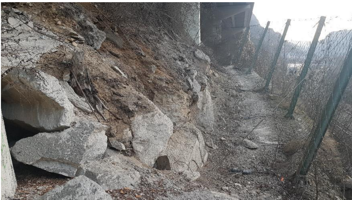
Figura 31. Tratto di barriere esistenti all'altezza della pila n. 23 del viadotto autostradale "Novale".
