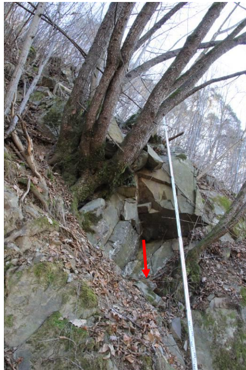
Figura 14. Intersezione tra due famiglie di discontinuità che determina una rottura per scivolamento a cuneo.
