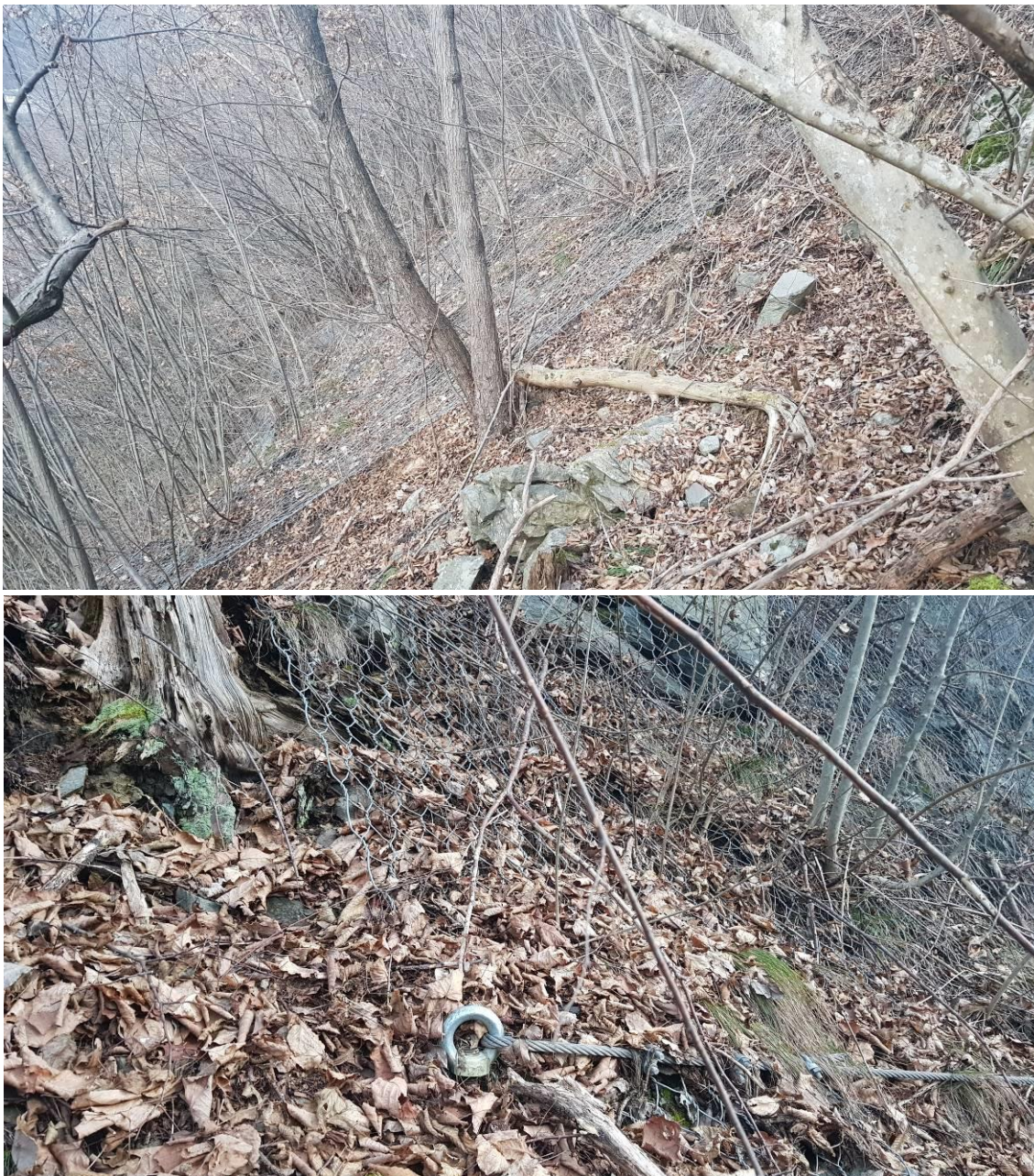
Figura 25. Reti metalliche a doppia torsione zincate localizzate a monte del viadotto autostradale “Novale” tra le pile n. 17 e n. 22.
