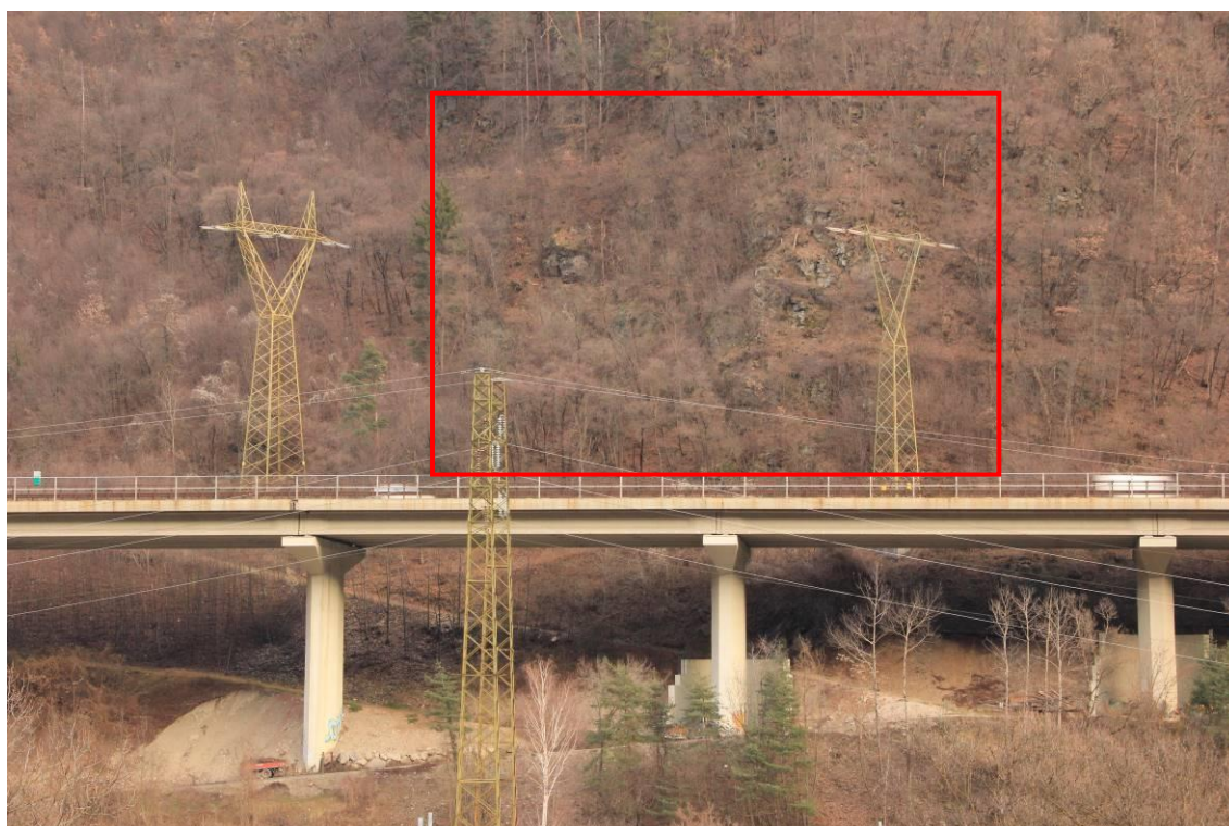
Figura 11. Affioramenti rocciosi presenti sul versante sovrastante gli interventi in progetto.
