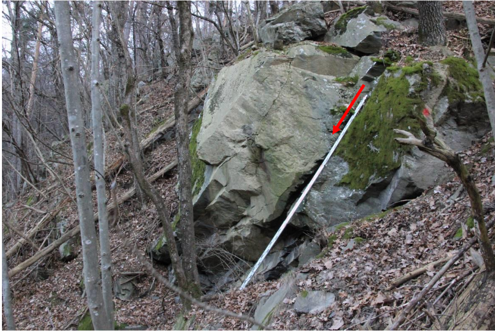
Figura 13. Superficie di discontinuità a franappoggio che determina un meccanismo di rottura con scivolamento piano dell'elemento roccioso.
