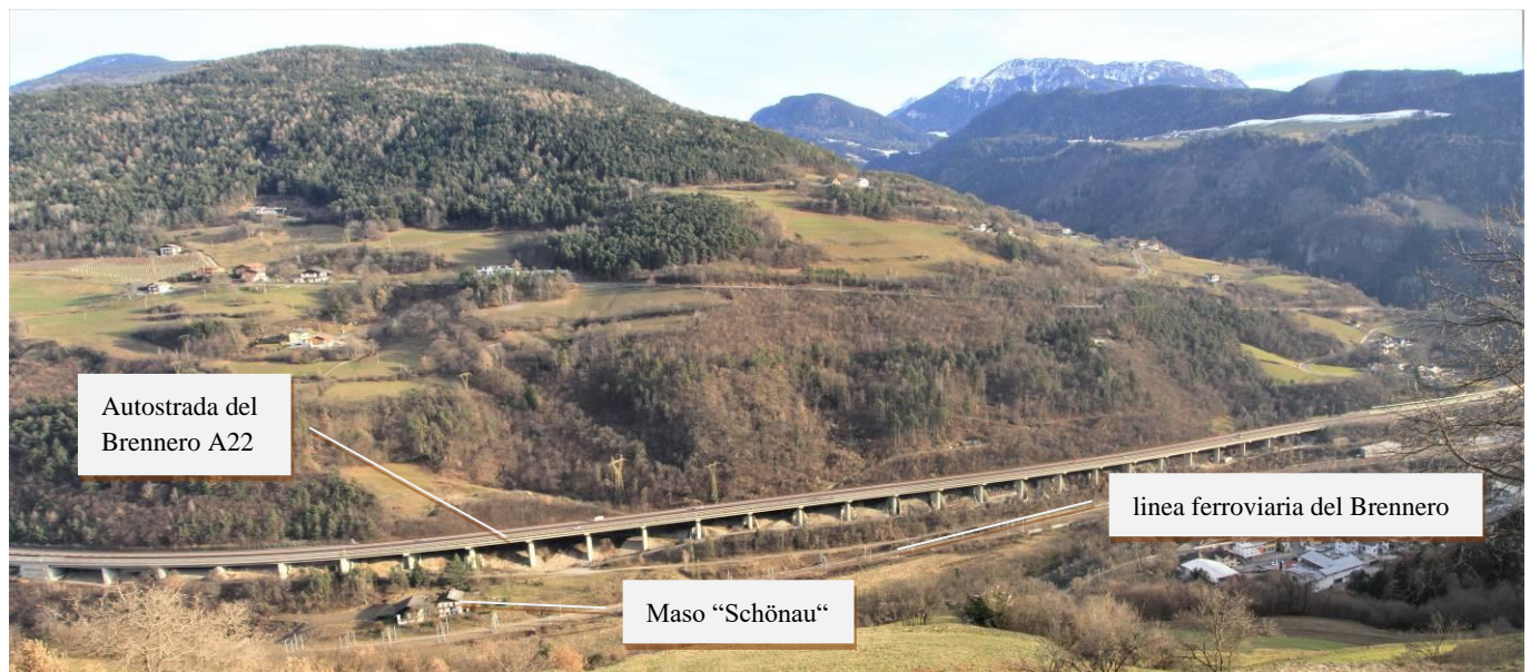
Figura 1. Vista panoramica del tratto di fondovalle interessato dagli interventi.
