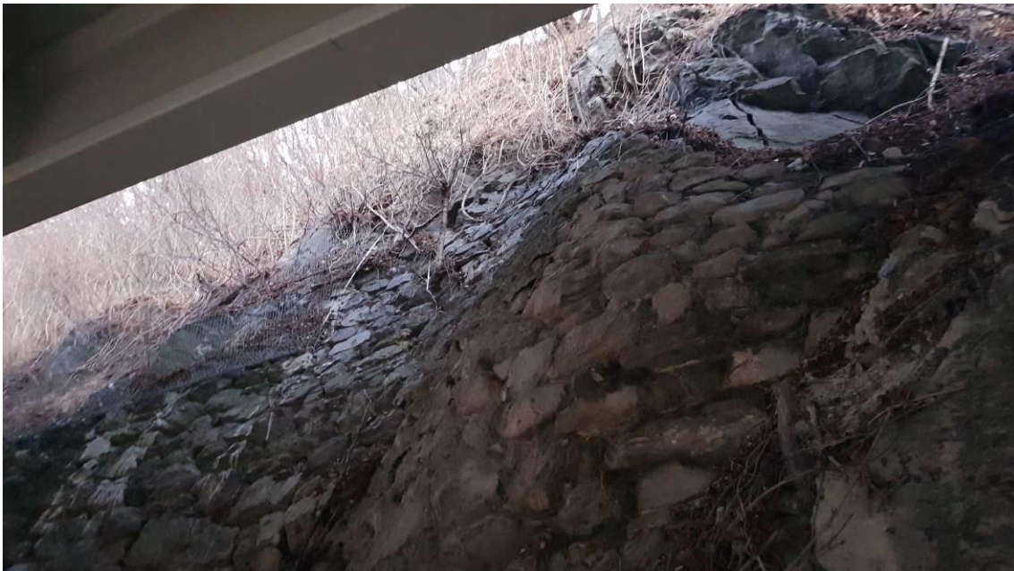
Figura 29. Muri in pietra e rete metallica localizzati tra le pile n. 19 e n. 20 del viadotto autostradale “Novale”.
