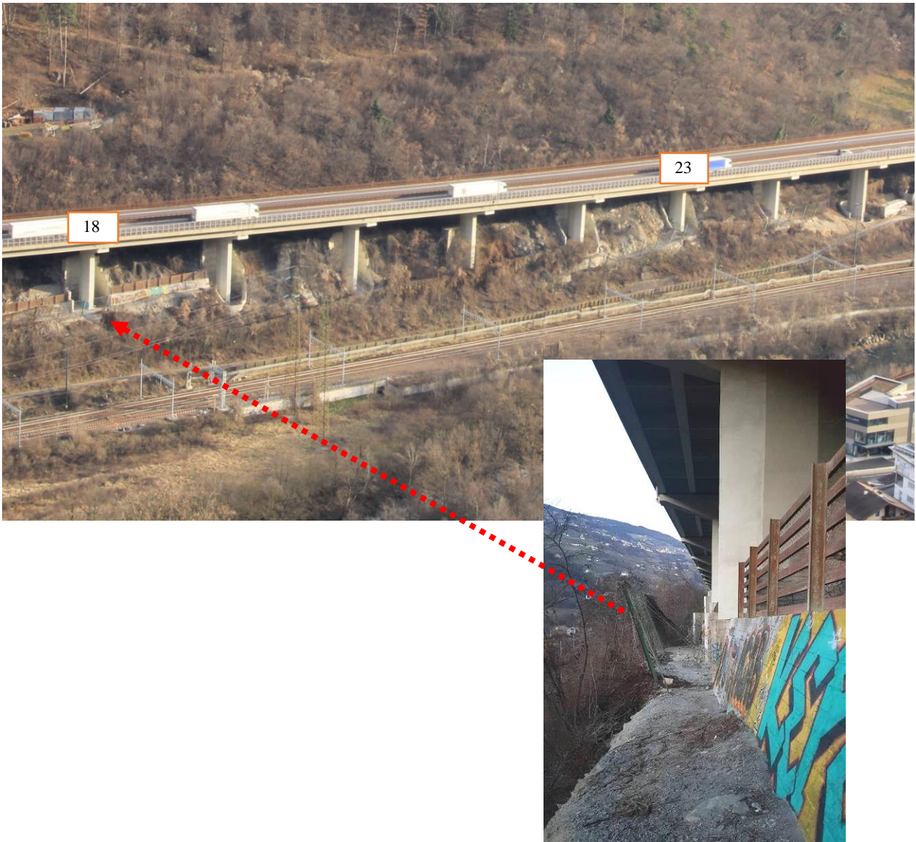
Figura 30. Tratto compreso tra le pile n. 18 e n. 23 del viadotto autostradale interessato dalla realizzazione delle nuove barriere come da PD.
