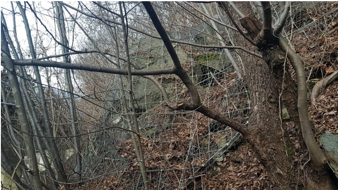
Figura 27. Pannelli in fune localizzati a monte della pila n. 21 del viadotto autostradale “Novale”.
