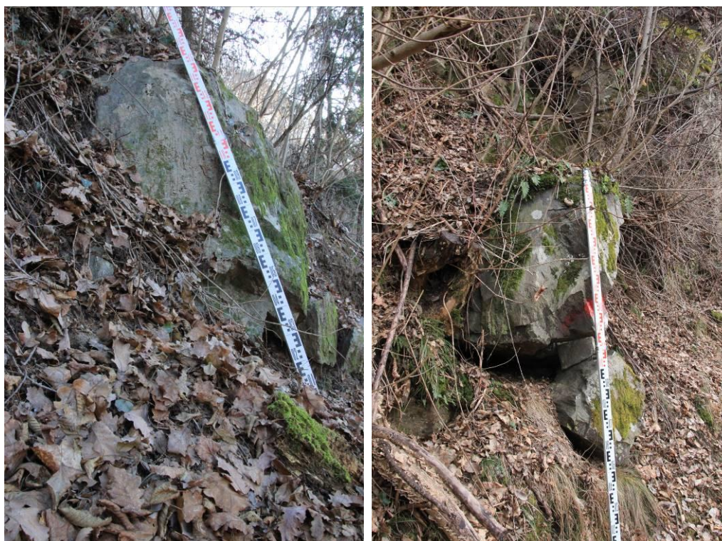
Figura 8. Blocchi isolati con processo di scalzamento al piede in atto.
