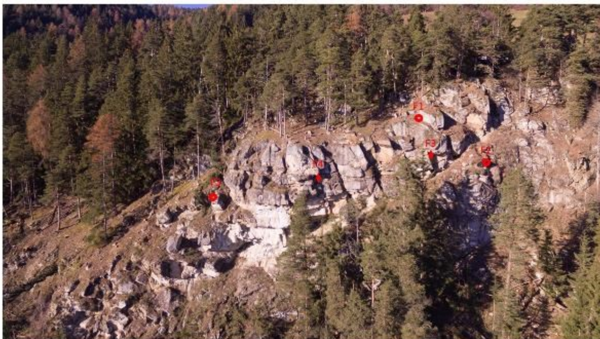
Fig. 1. L'ammasso roccioso sovrastante la linea ferroviaria della Val Pusteria sede del distacco di alcuni blocchi nel novembre 2019. I simboli in rosso indicano l'ubicazione degli strumenti installati (cerchio per estensimetri a barra e rombi per estensimetri a filo).
