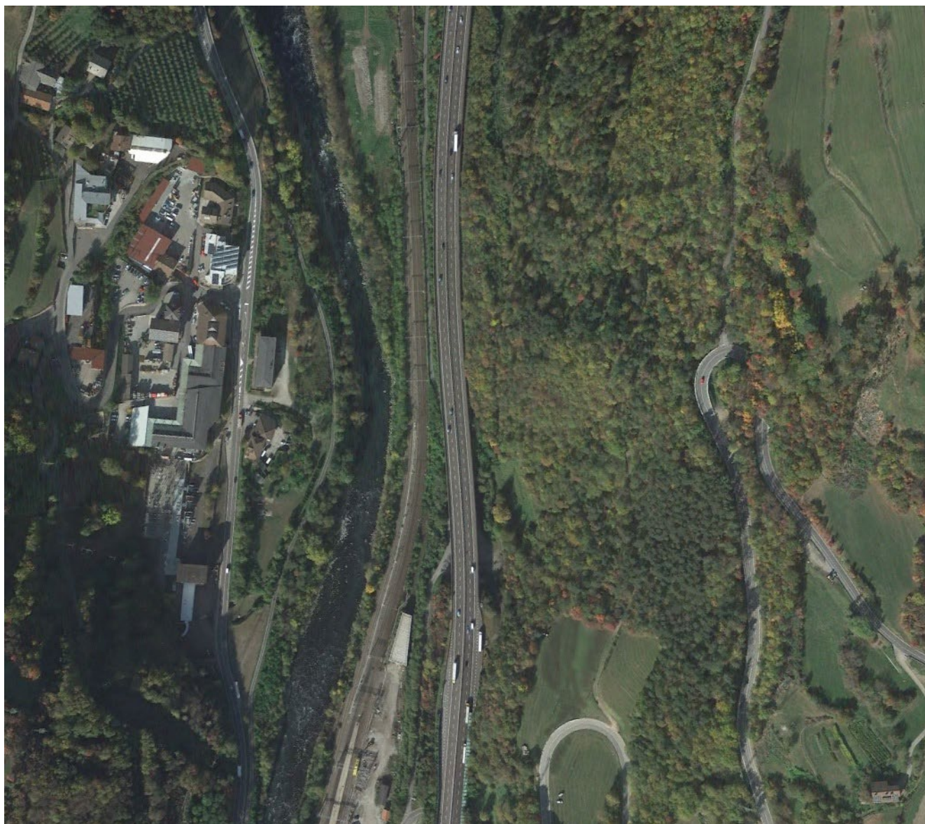
Figura 2 - Area oggetto di intervento
