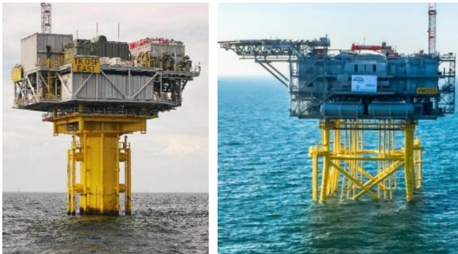
Figura 5 - esempi di stazione di trasformazione offshore con fondazione fissa
