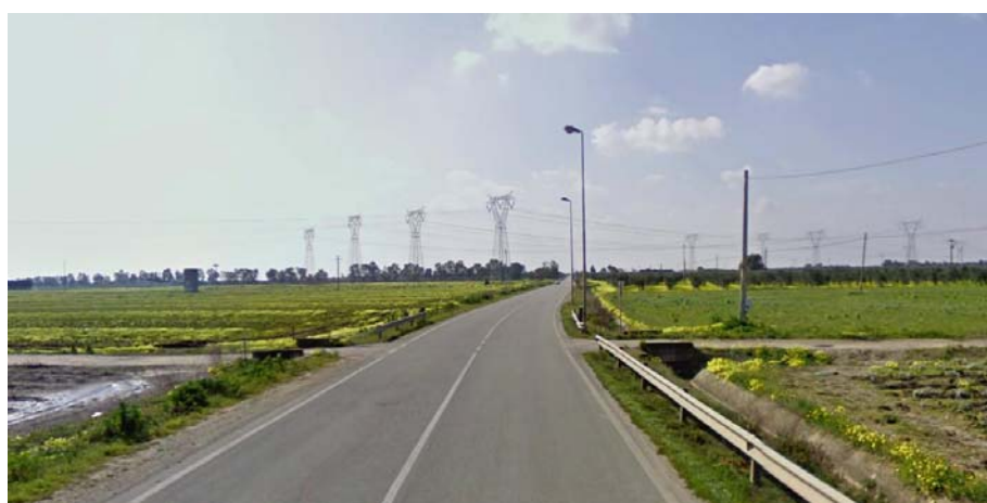
Strada Provinciale n. 87
