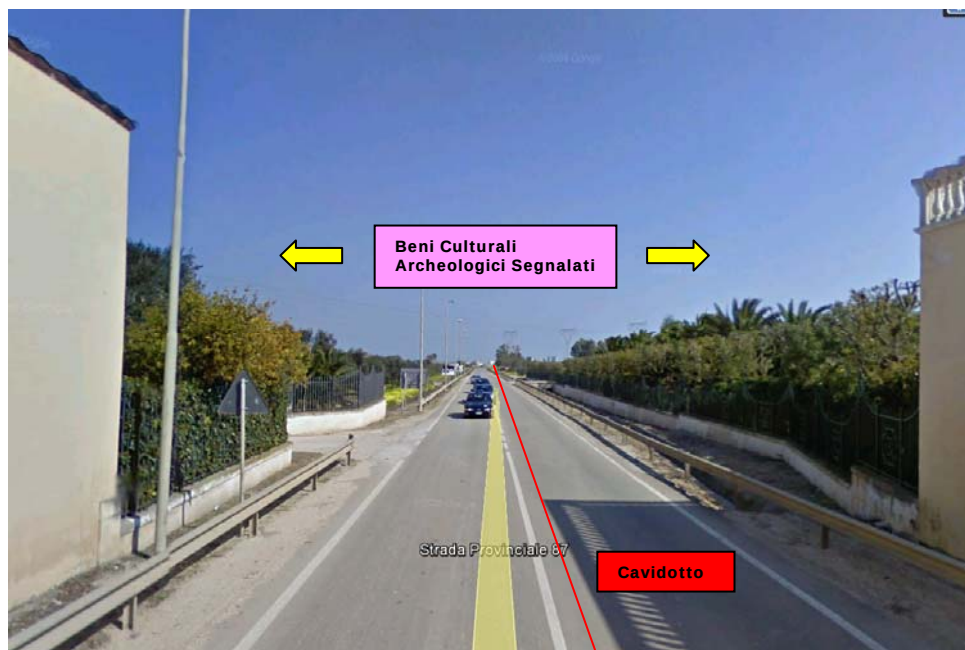
Fig. 2.28 : Vista della SP87 in corrispondenza del passaggio in prossimità degli edifici individuati tra i Beni Culturali Archeologici Segnalati
