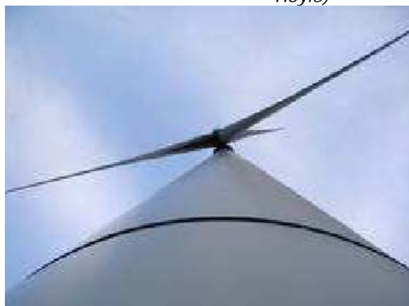
Fig. 4.64 : Collegamento flangiato tra settori della torre (North Hoyle)
