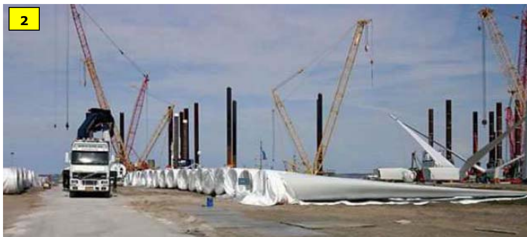
Fig. 4.15 : Pale impilate (1) su sei piani a quattro ordini di colonne e pronte per essere assiate o inviate sul sito (Vestas) e sistemate accostate (2) tra loro (Horns Rev)
