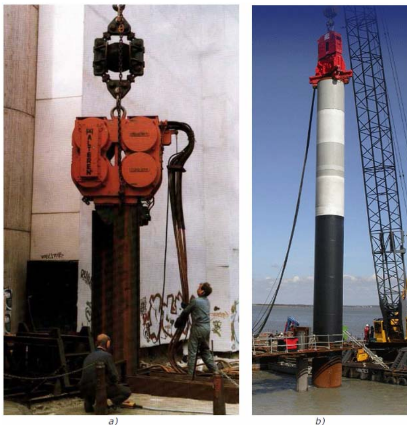
Fig. 4.58 : Vibroaffondatore elettrico Tünker da 623 kN (a) ed unità della Jean Lutz
