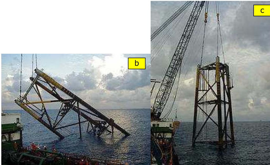
Fig. 4.47 : Il mancato rispetto delle procedure di immersione non consente ancora un equilibramento corretto delle membrature (b), solo quando sia finalmente raggiunto (c)
