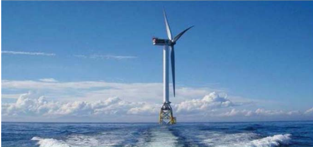
Fig. 3.5 : Struttura portante a jacket per turbina eolica 5M montata a Moray Firth (REpower)
