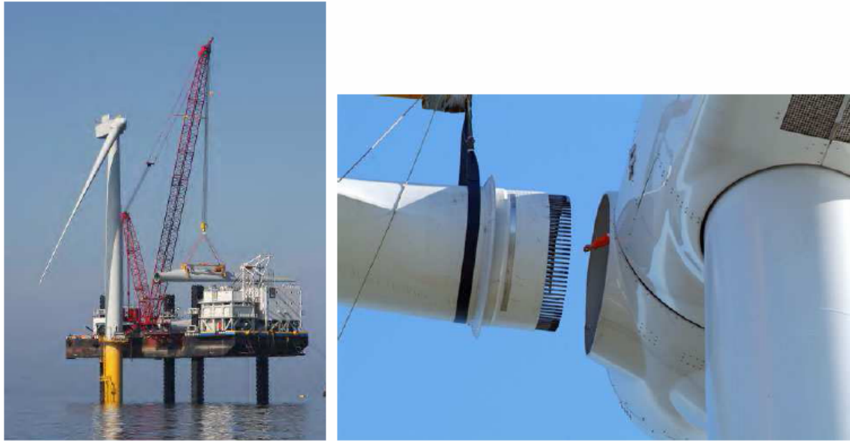
Fig. 4.78 : Installazione di pala singola (a; Rhyl Flats) ed accorgimenti per il montaggio (b; Lynn and Inner Dowsing)
