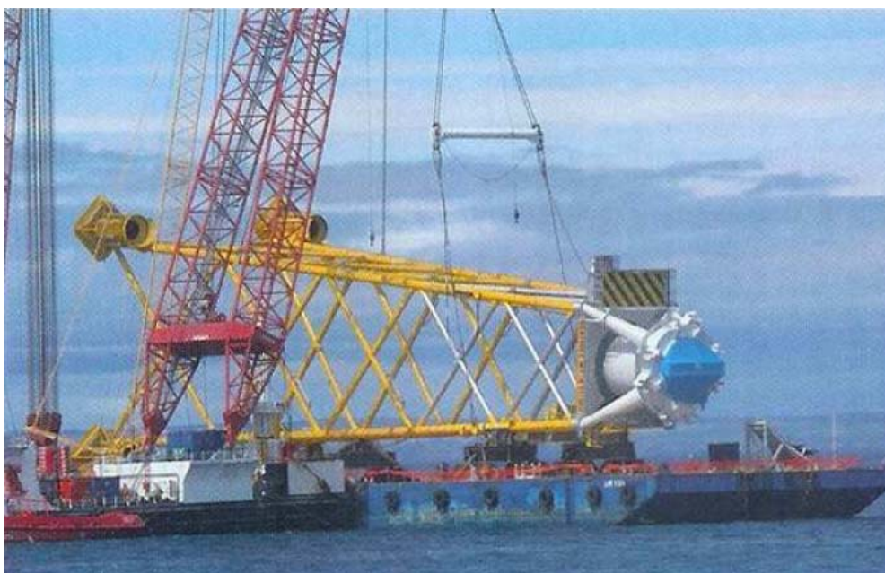
Fig. 4.34 : Sollevamento di castello a jacket per essere adagiato sul fondale mediante gru, sistemate su pontone (REpower)
