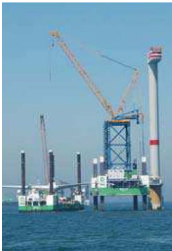
Fig. 4.35 : Jack-up con gru su supporto supplementare
