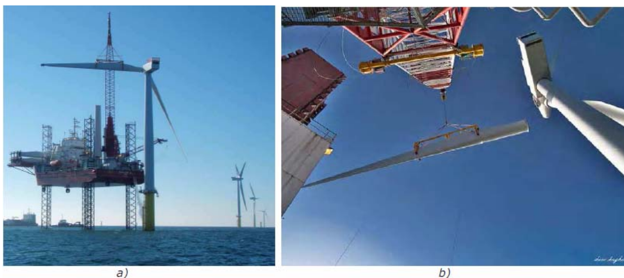
Fig. 4.77 : Installazione dell'ultima in unità dei campi Lillgrund (a) e Kentish Flats (b)
