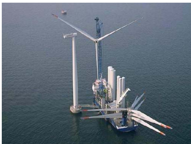
Fig. 4.19 : Montaggio di turbina Siemens 2,3 (Nysted)
