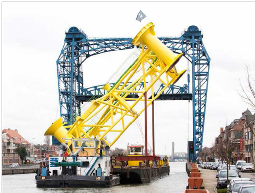
Fig. 4.50 : Trasporto della meta (GeoSea) per il posizionamento dei pali fondari (Ormonde)
