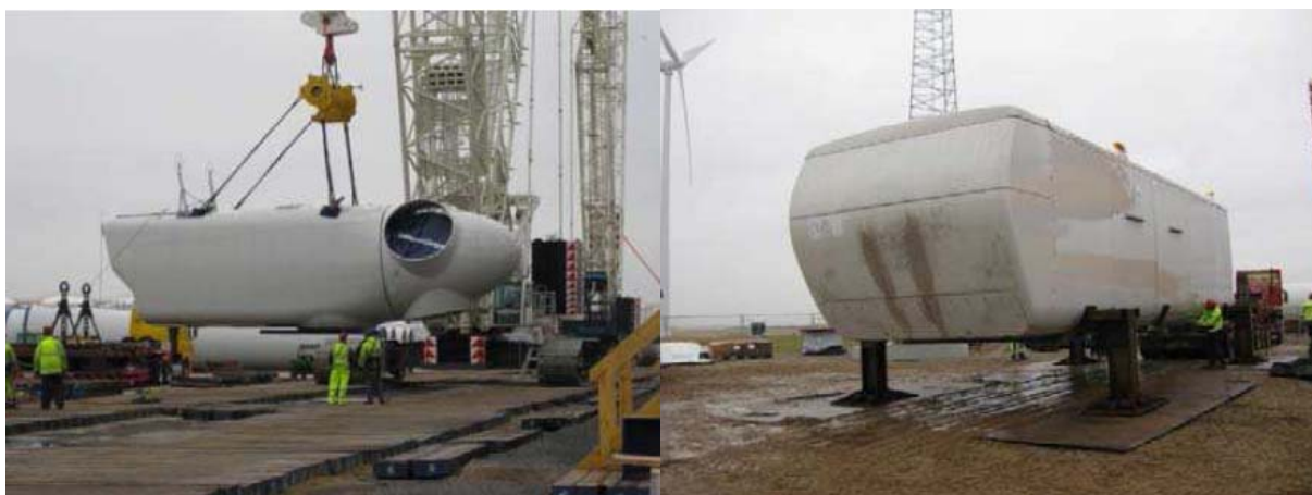
Fig. 4.11 : Navicella completa di mozzo (1) in sollevamento ed appoggiata su gambe di sostegno temporaneo (2) in cantiere (Vestas)
