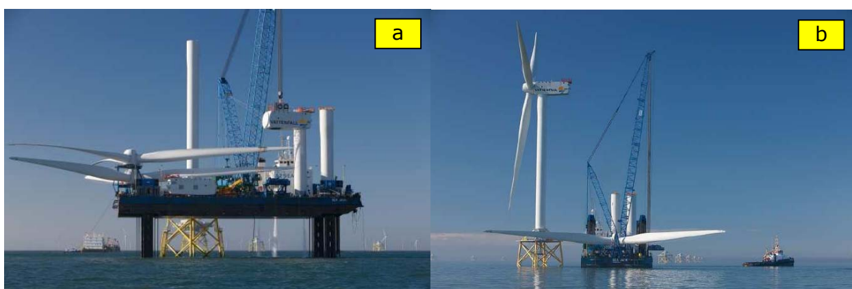
Fig. 4.51 : Turbina in fase d'installazione (a) ed installata (b) in primo piano con strutture fondarie completate sullo sfondo (Ormonde)
