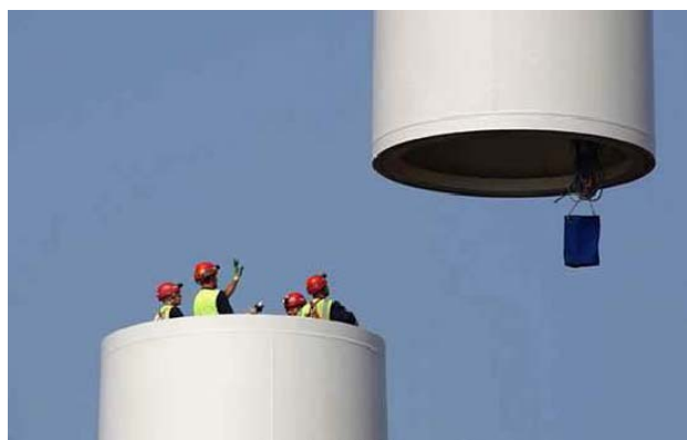
Fig. 4.63 : Sistemazione di concio successivo sul precedente, già in loco (North Hoyle)
