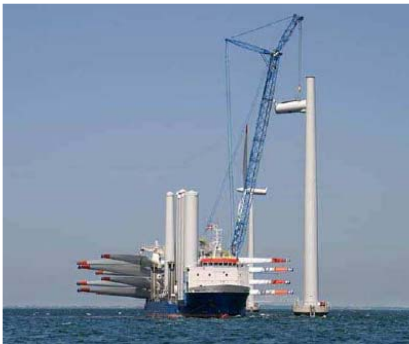
Fig. 4.26 : Nave al montaggio di navicella per il campo eolico di Horns Rev (G. Britse)
