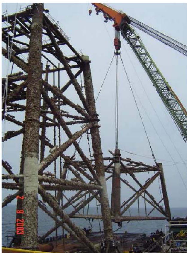
Fig. 6.2 : Rimozione di jacket (Shell)
