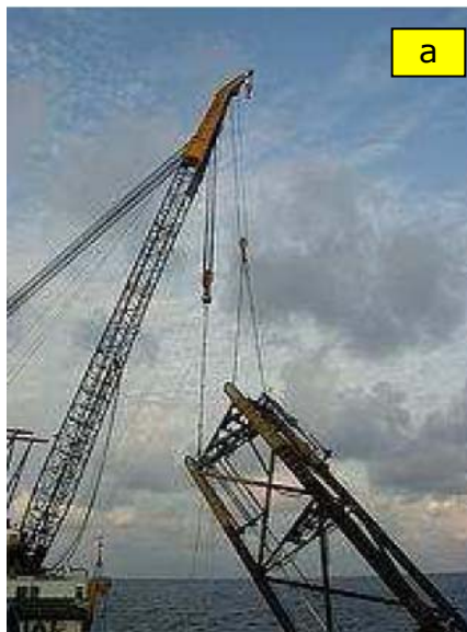
Fig. 4.46 : Imbracamento della testa della fondazione ed introduzione non corretta in acqua
