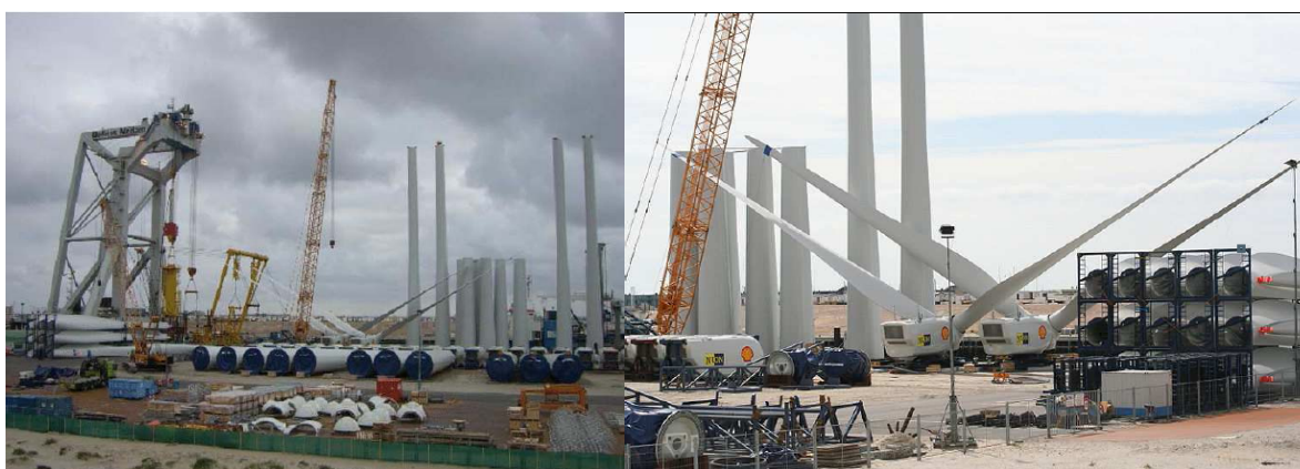
Fig. 4.21 : Componentistica primaria nel cantiere nel porto di IJmuiden prima dell'invio sul sito a mare (Egmond aan Zee)
