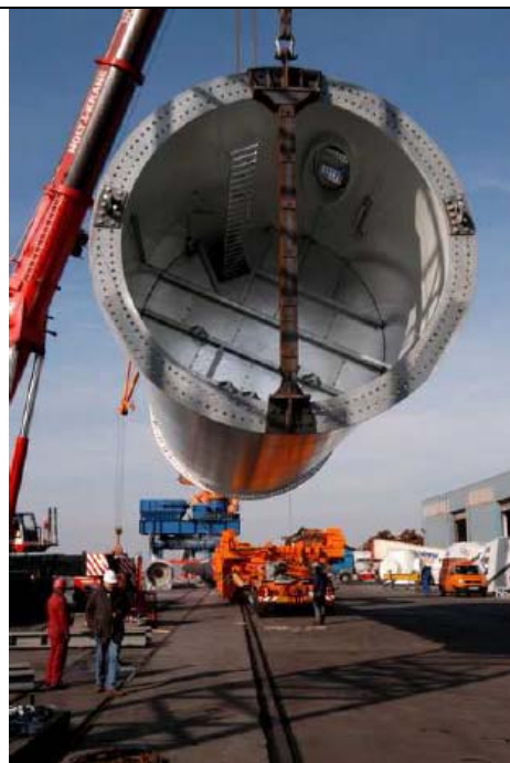
Fig. 4.38 : Accorgimenti per un trasporto sicuro e senza deformazioni di sezione della torre (REpower)
