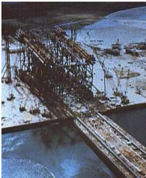
Fig. 4.31 : Caricamento di pesante jacket su chiatta mediante scivolamento guidato
