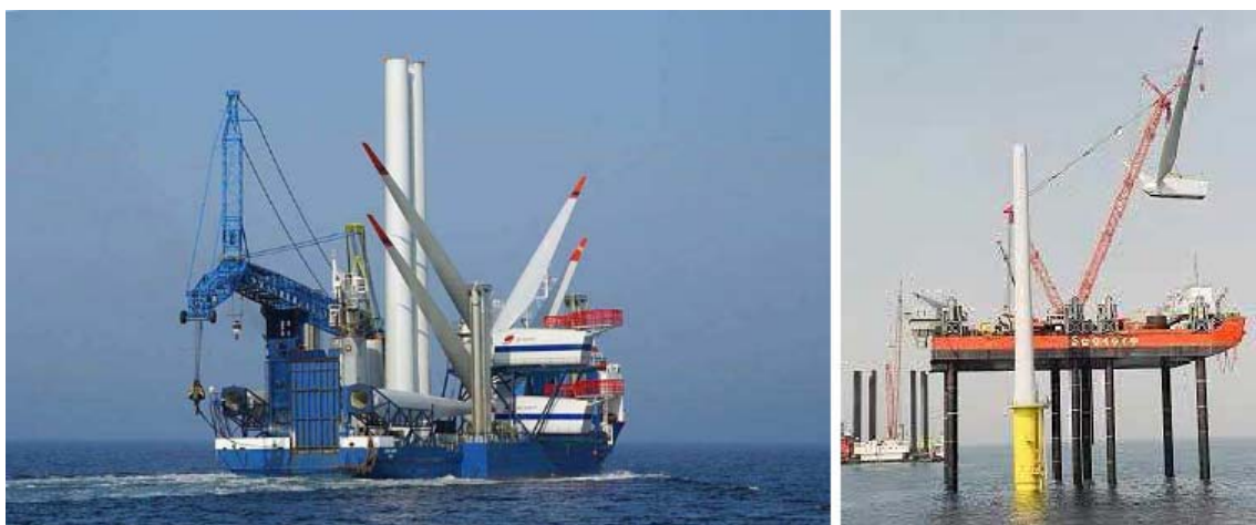
Fig. 4.75 : Installazione di navicella con rotore e due pale (Arklow Bank)
