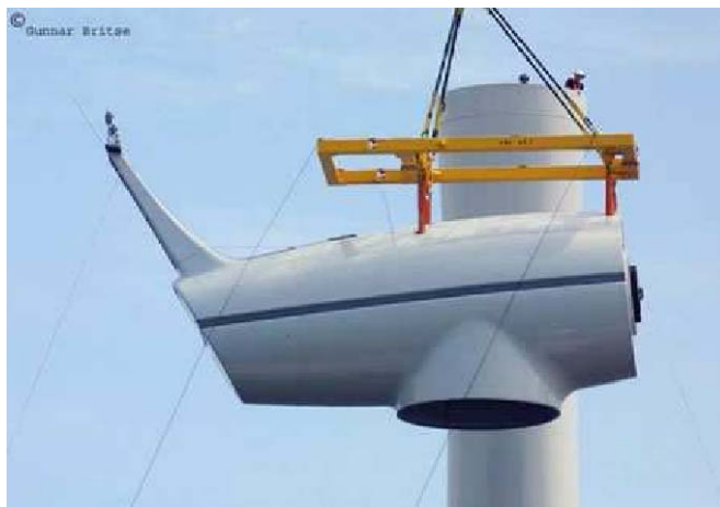
Fig. 4.65 : Sollevamento della navicella per essere impostata sull'ultimo tronco della torre (Noth Hoyle)
