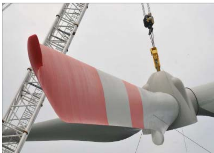
Fig. 4.20 : Sollevamento del rotore della turbina Bard 5.0 (Bard Offshore 1)
