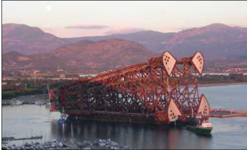
Fig. 4.29 : Movimentazione a mare di struttura fondaria (Interema)
