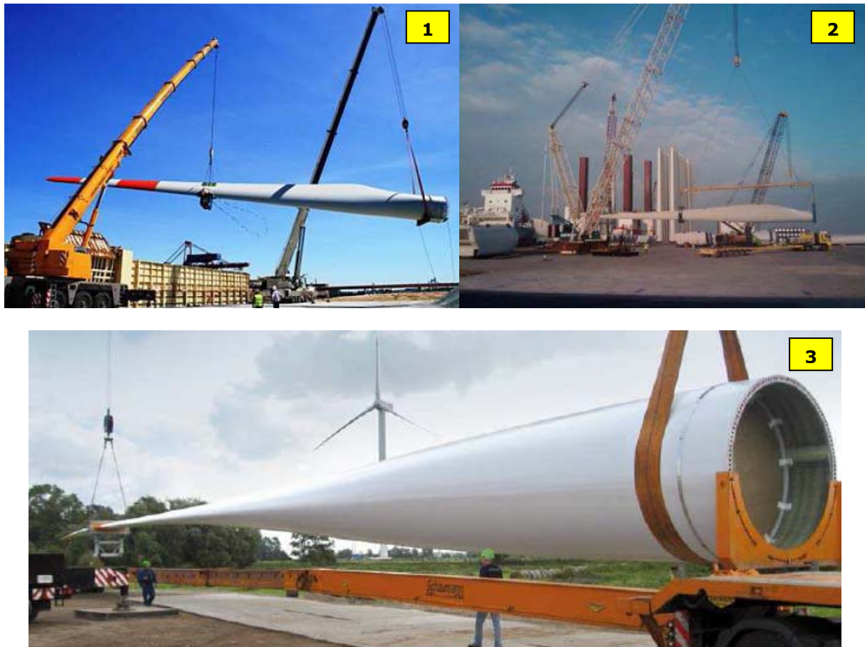
Fig. 4.8 : Pala (PN Rotor) in fase di carico su battello a Stade (DE), scarico da nave mediante trave di supporto in cantiere (Vestas) e movimentazione (3) per turbina 5M (Thornton Bank)
