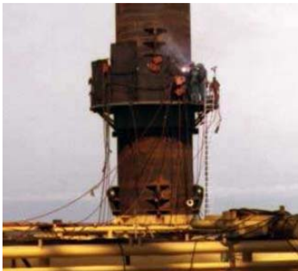
Fig. 4.57 : Operazione di saldatura su jacket a mare
