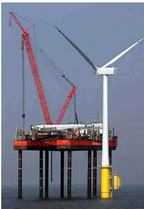
Fig. 4.66 : Predisposizione dell'innalzamento dell'ultima pala ad installazione della navicella con il rotore e con la coppia di pale della turbina eolica (G. Britse)
