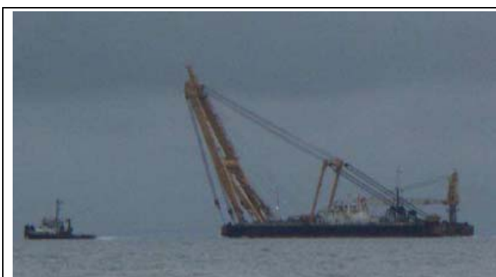
Fig. 4.42 : Pontone impiegato nei lavori a mare sul sito di Robin Rig
