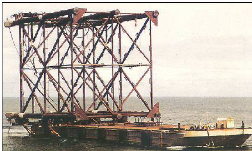
Fig. 4.30 : Trasporto a mare di jacket di grandi dimensioni (Mc Dermont)
