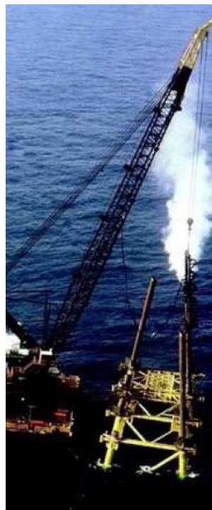
Fig. 4.55 : Battipalo per l’inserimento di pali di ancoraggio di jacket
