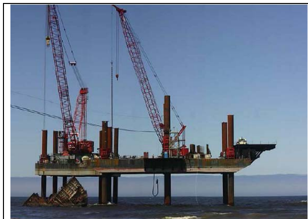
Fig. 4.40 : Jack-up accoppiati in operazioni di smantellamento
