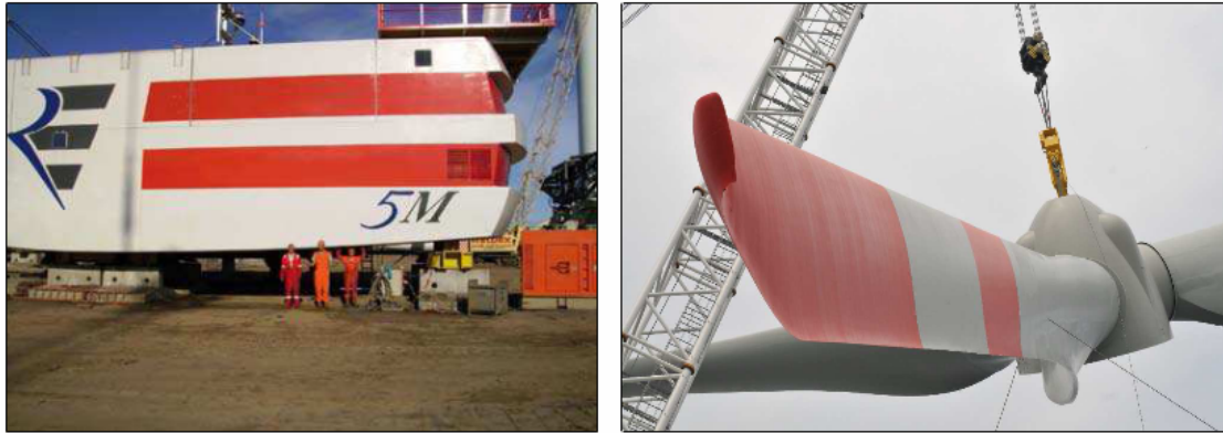
1) 2) Fig. 4.71 : Navicella di turbina 5M REpower (a) e rotore della Bard 5.0 (b)
