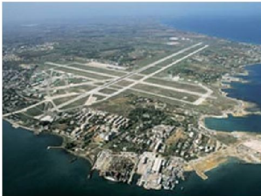
Fig. 115 Vista aerea dell'aeroporto di Brindisi
