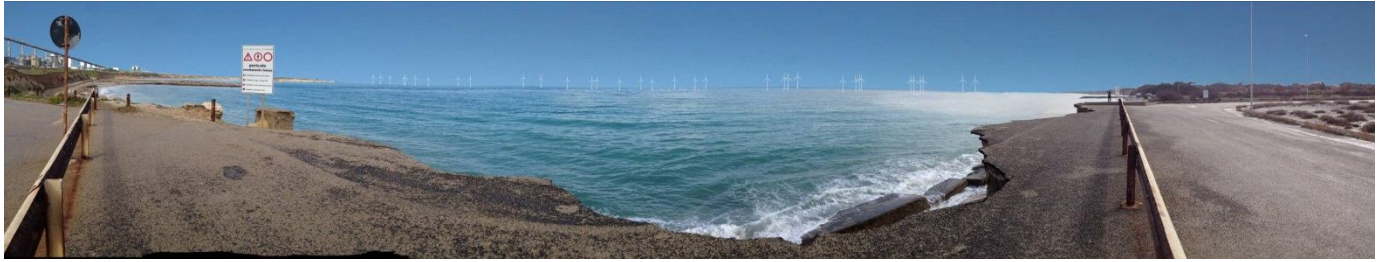
Fig. 98 Vista 3 dalla Centrale Enel Cerano (post operam)
