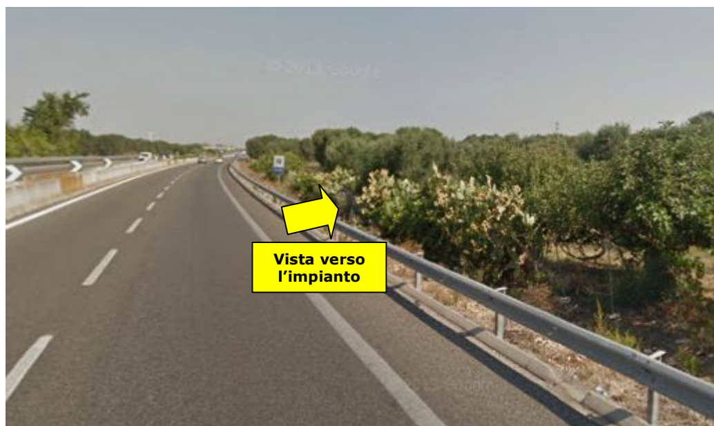
Fig. 109 Vista dalla SS613 verso il parco eolico
