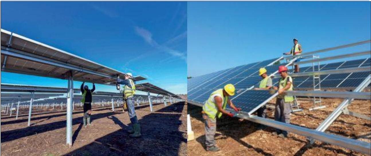
Figura 17: Montaggio tracker e moduli fotovoltaici
