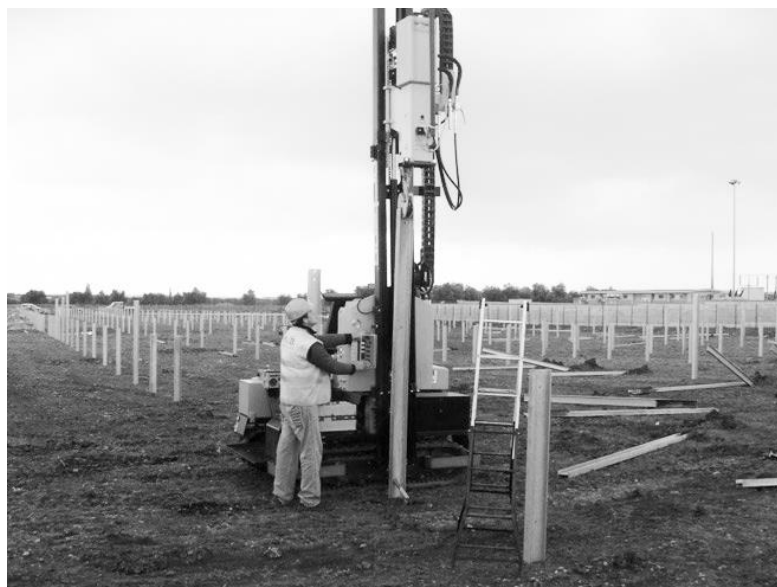
Figura 15 – Infissione con macchina battipalo
