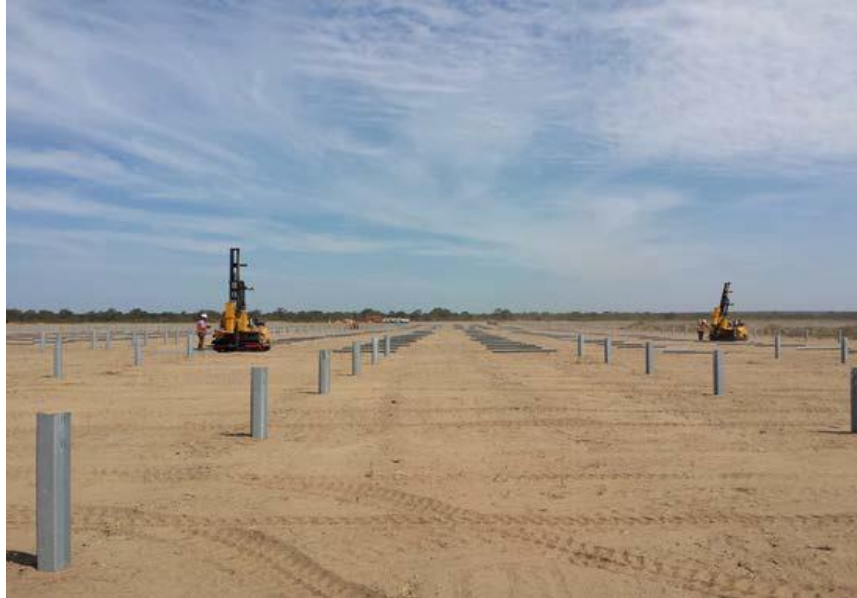
Figura 14 – Posa in opera profili di palificazione
