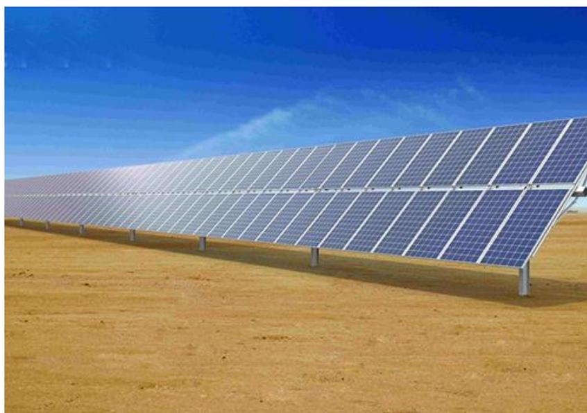
L'utilizzo di tali strutture permette di orientare i moduli fotovoltaici favorevolmente rispetto ai raggi solari nel corso della giornata, mantenendo invariata l'inclinazione dell'asse di rotazione del pannello rispetto al terreno, ovvero mantenendo invariato l'angolo di TILT.
