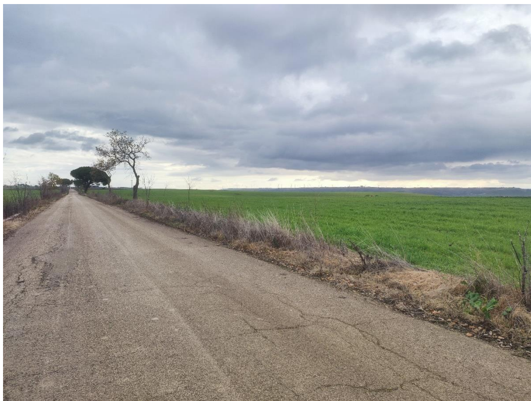
Foto 1- Vista S-E rispetto all'impianto
