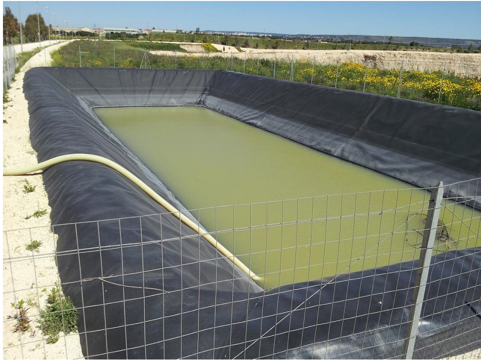
Foto 3 – Esempio di vasca raccolta acque piovane.
