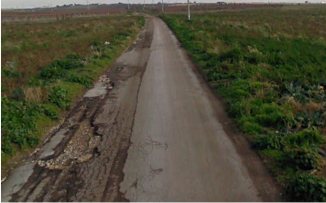
Fig. 23_ Strada Vicinale non denominata, interessata dalla posa dell'elettrodotto di connessione alla rete (Tratto intermedio)
