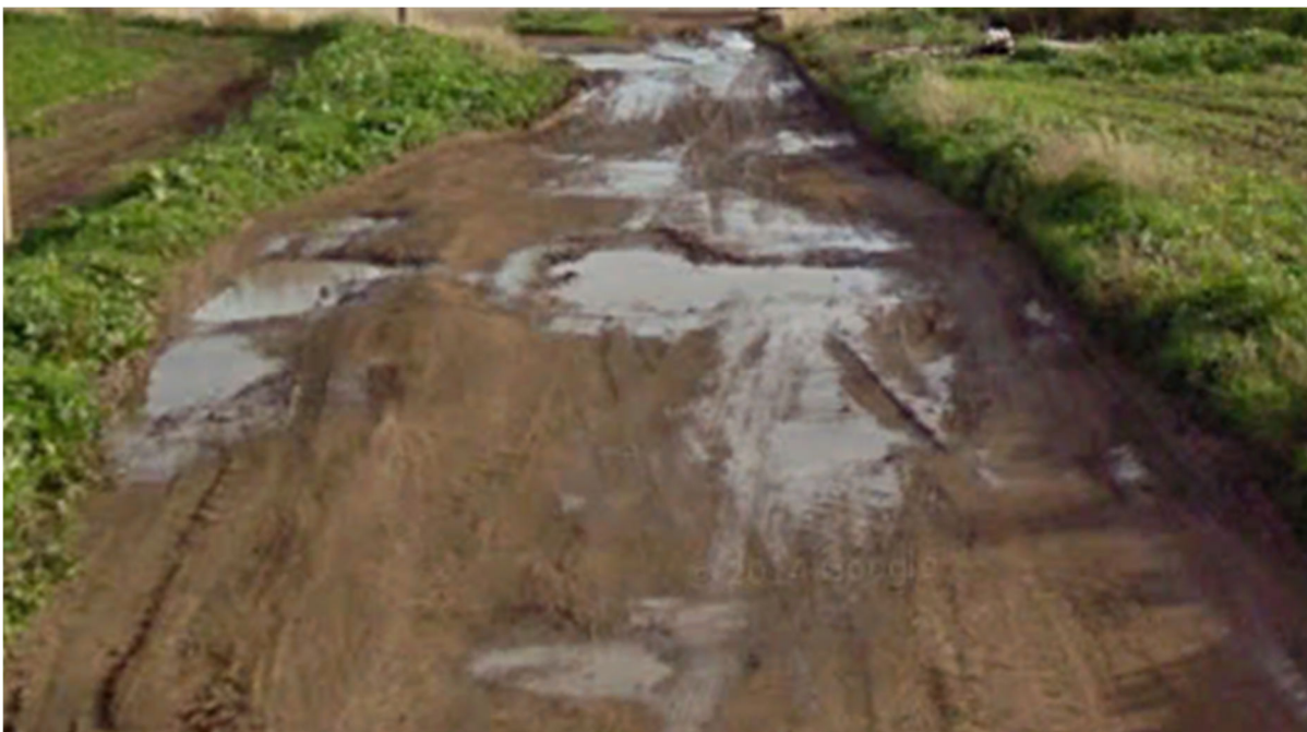
Fig.24_ Strada Vicinale non denominata, interessata dalla posa dell'elettrodotto di connessione alla rete (Tratto finale in corrispondenza dell'incrocio con la SP83)
