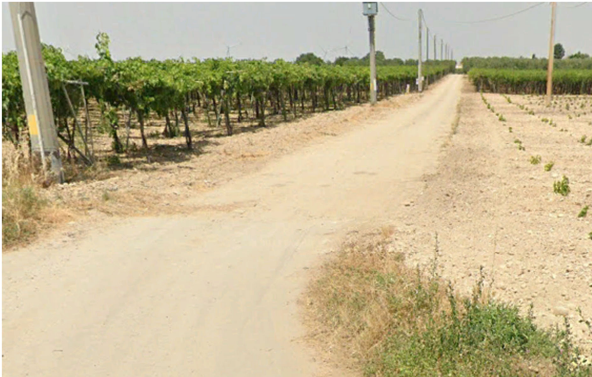
Fig.27_ Strada di accesso alla Stazione elettrica
