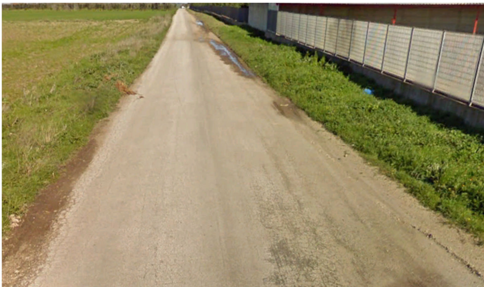
Fig.22 _ Strada Vicinale non denominata, interessata dalla posa dell'elettrodotto di connessione alla rete (Tratto iniziale)
