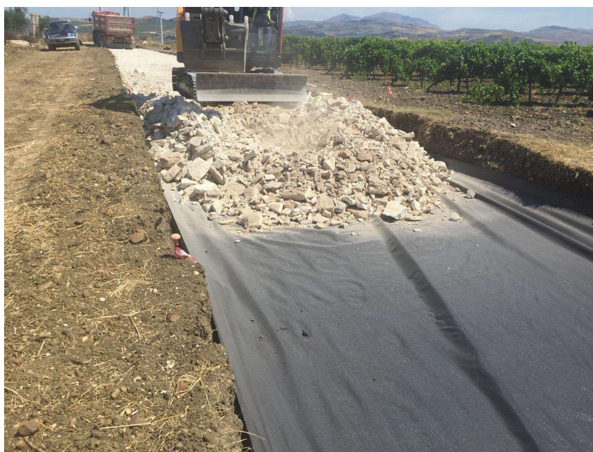
Fig.4. Posa in opera di geocomposito e fondazione stradale
