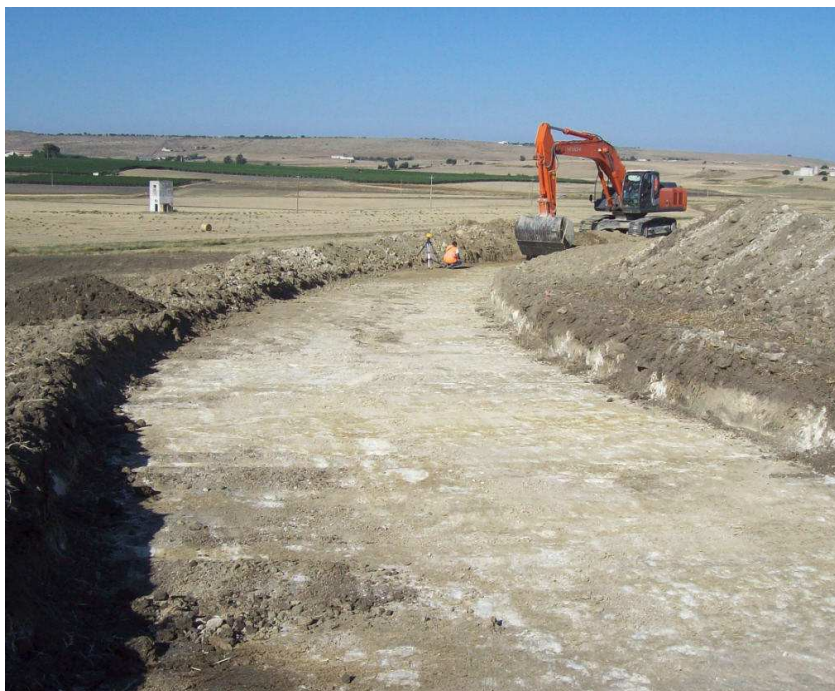
Fig.3. Apertura sede stradale
