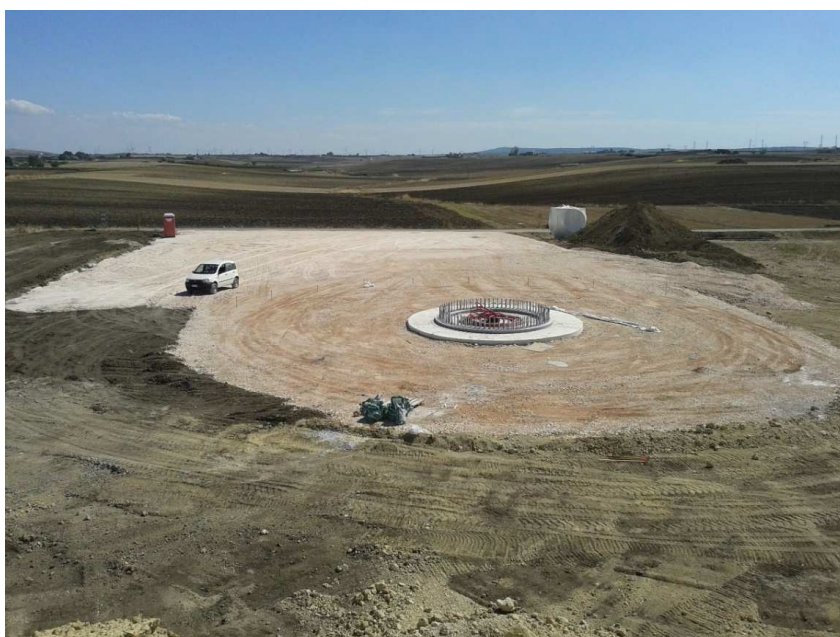
Fig.1. Piazzola di montaggio in fase di cantiere
