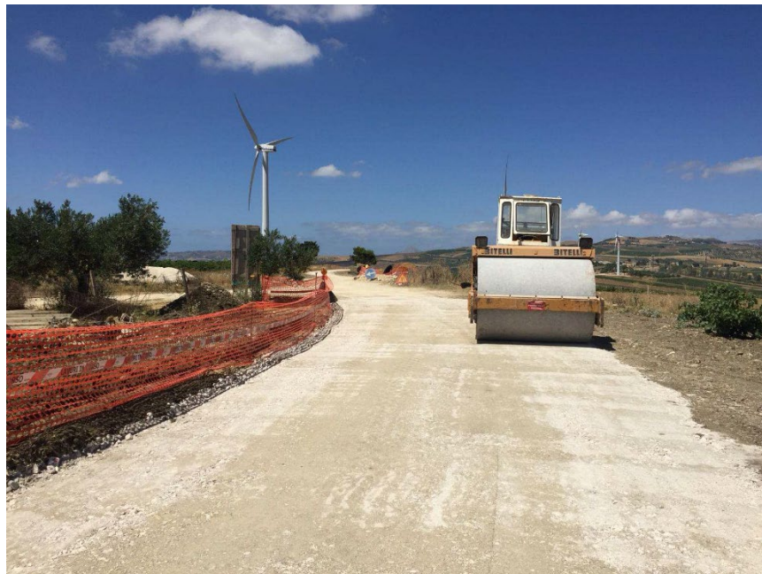
Fig.5. Compattazione strato di finitura
