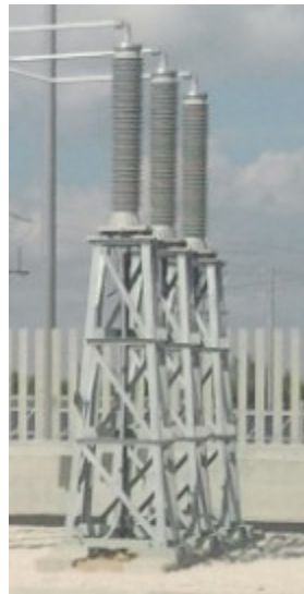
Fig. 15. Terminale cavo AT tipo.
