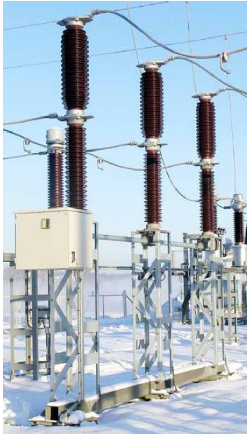
Fig. 19. Particolare Interruttore con TA incorporato.
