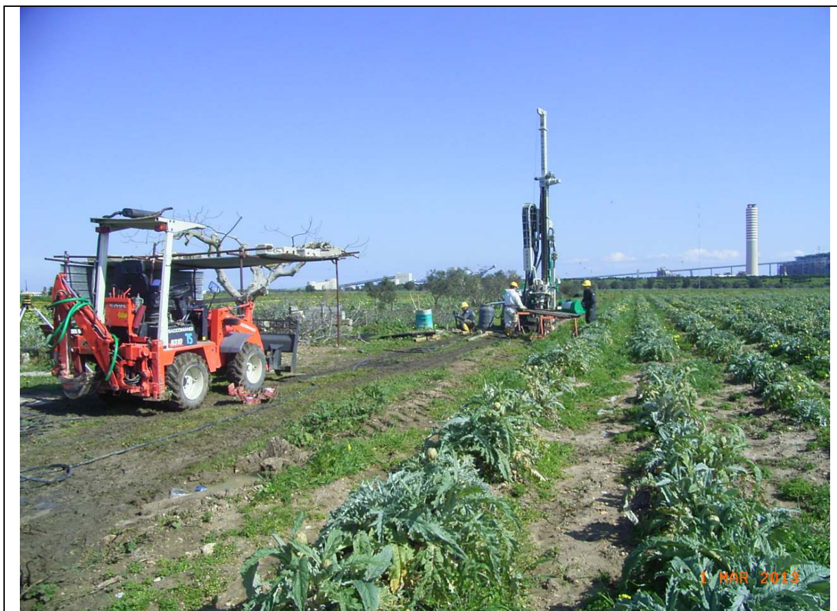
Foto 5 – Fase di esecuzione del sondaggio S2.
