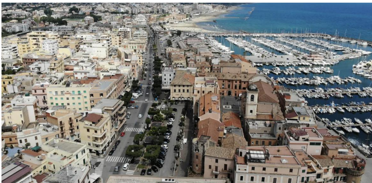
Figura 2.67 – vista dall'alto di Nettuno, a dx il borghetto con il porto turistico, a sx l'espansione più recente
