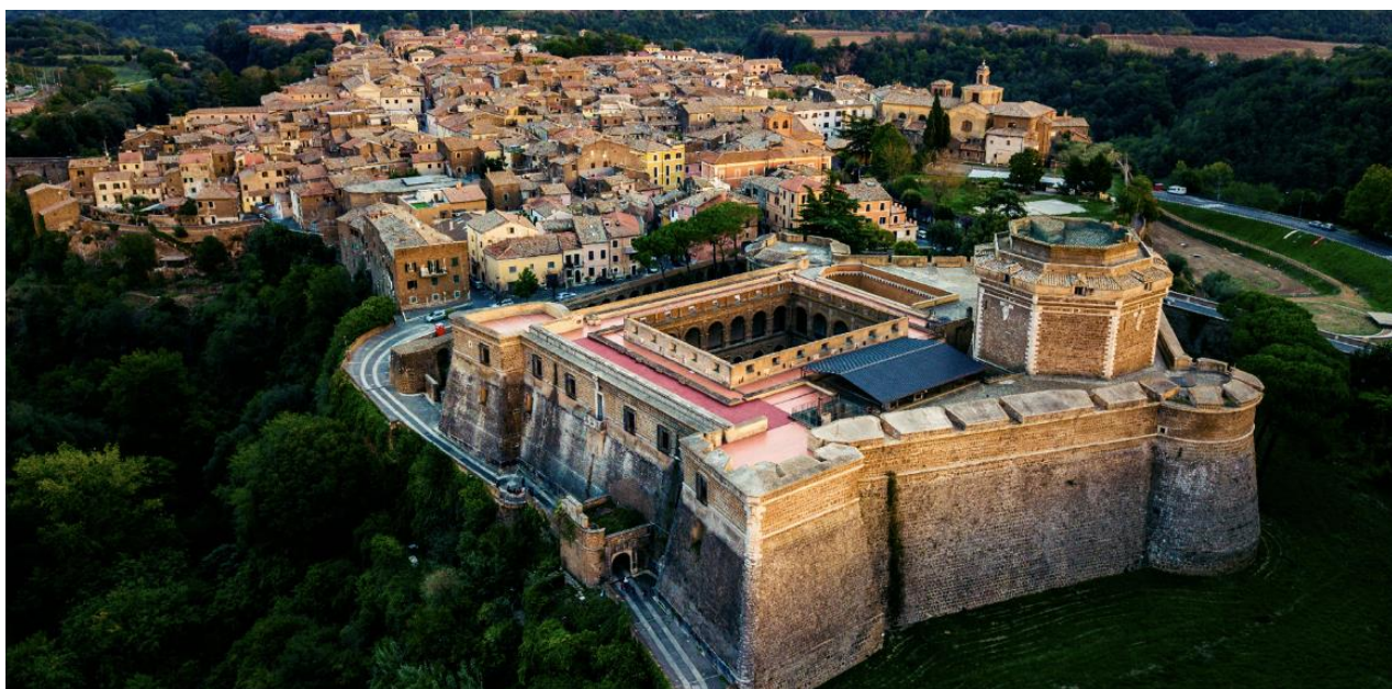
Figura 2.80 - Il Forte Sangallo
