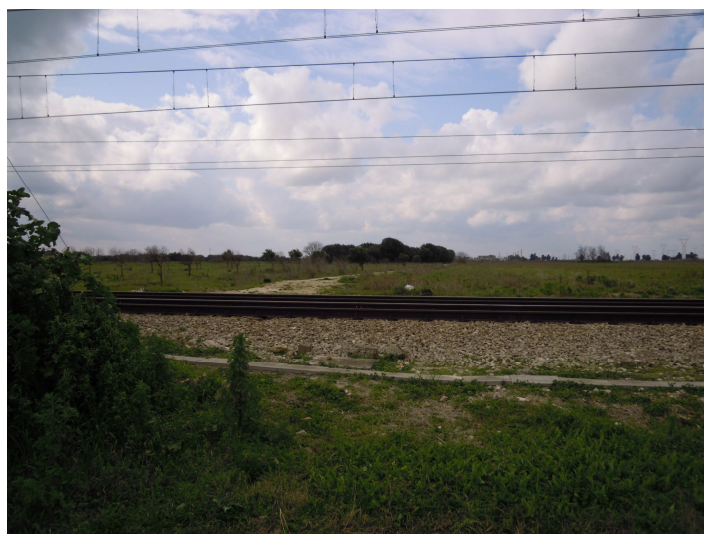
Foto 3: vista del tratto in cui il cavidotto attraversa la Ferrovia dello Stato
