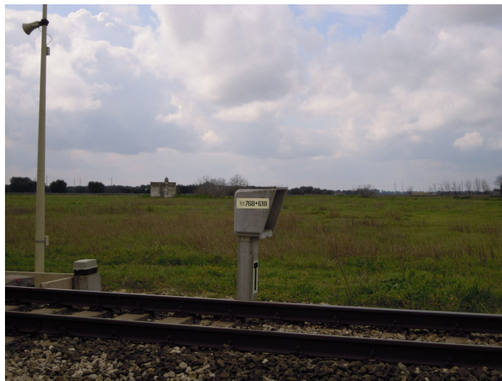
Foto 2: vista della progressiva in cui il cavidotto attraversa la Ferrovia dello Stato
