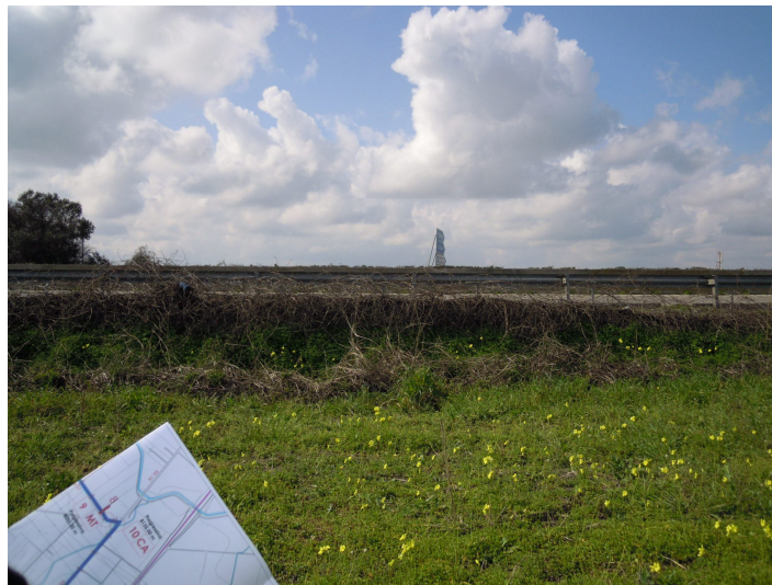
Foto 1: vista del tratto in cui il cavidotto attraversa la S.S. n.613
