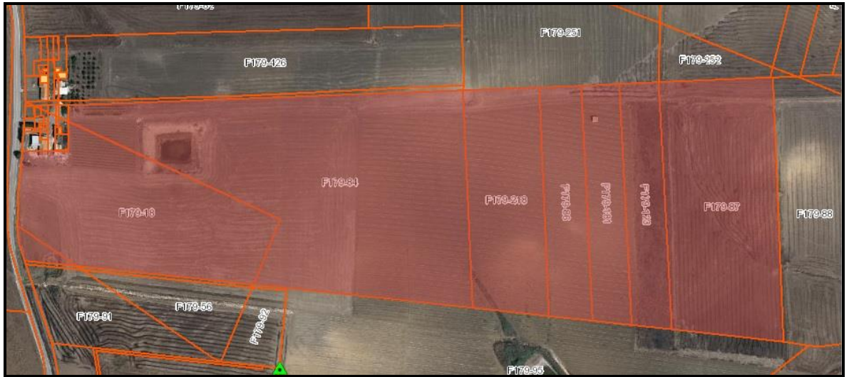
Figura 2 - Inquadrimento su fotografia aerea – Parco fotovoltaico “AGV Caltafalsa”
