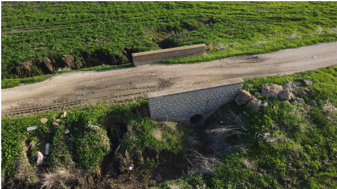
Interferenza 24 – Attraversamento idraulico, Comune di Trapani
