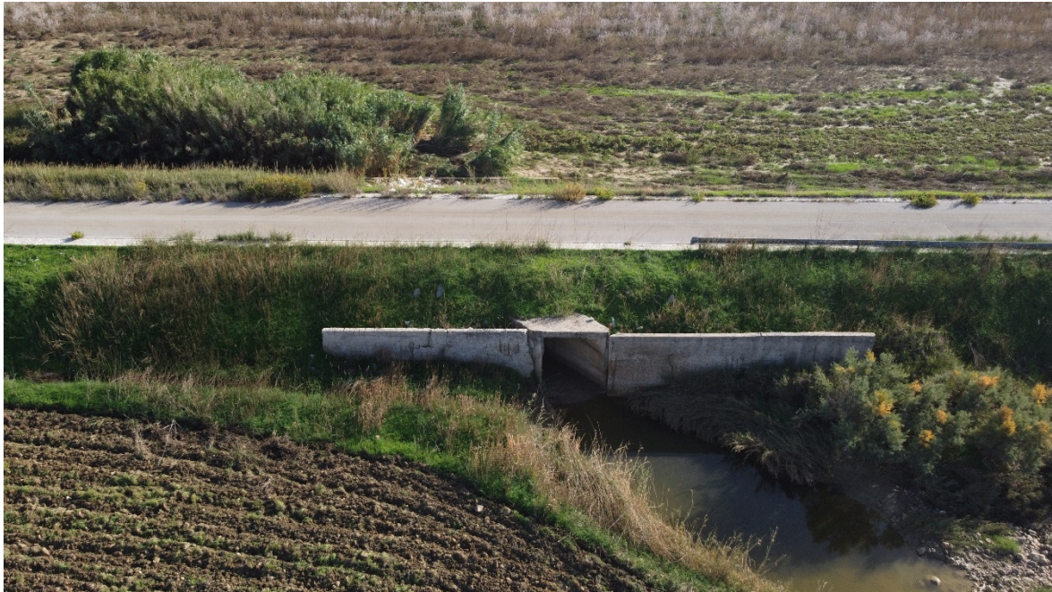
Interferenza 8 – Attraversamento idraulico, Comune di Marsala
