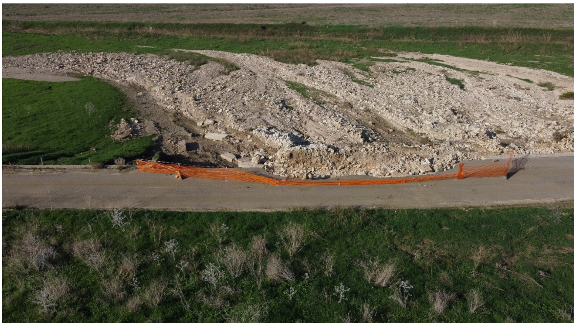
Interferenza 10 – Attraversamento zona in frana, Comune di Marsala
