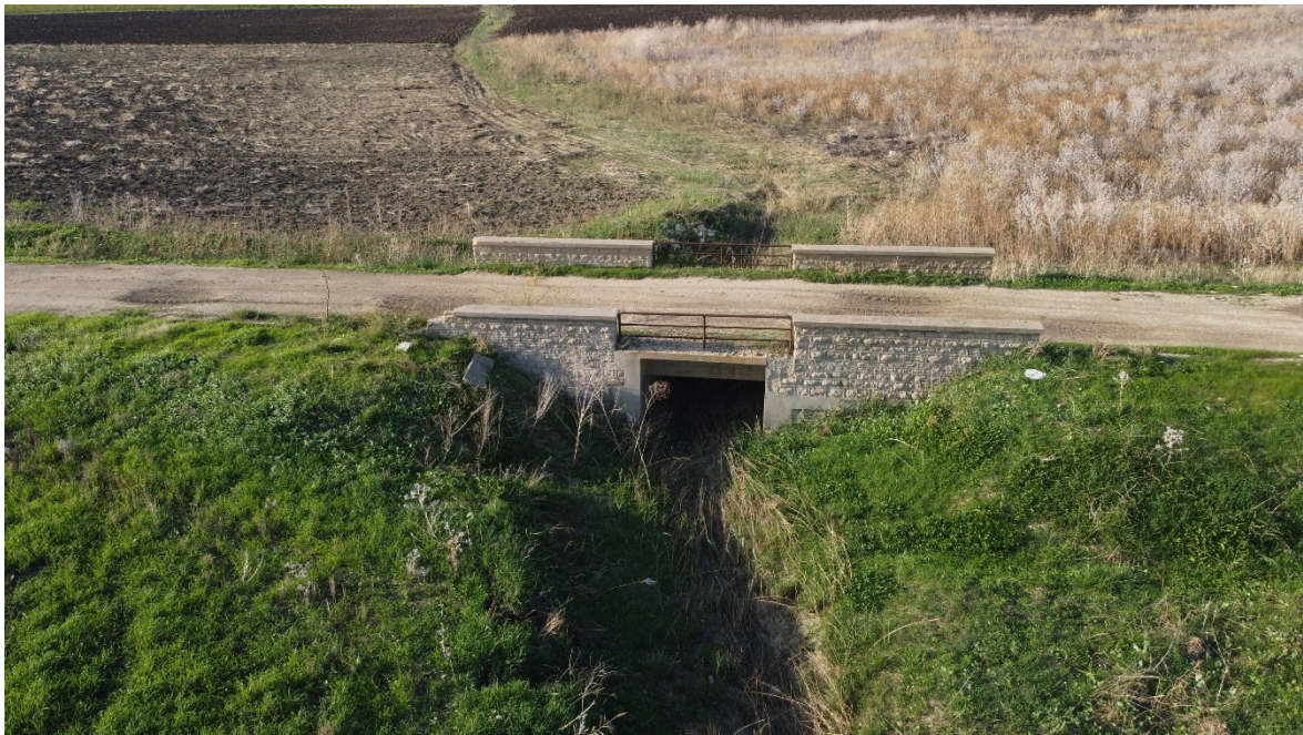
Interferenza 21 – Attraversamento idraulico, Comune di Trapani
