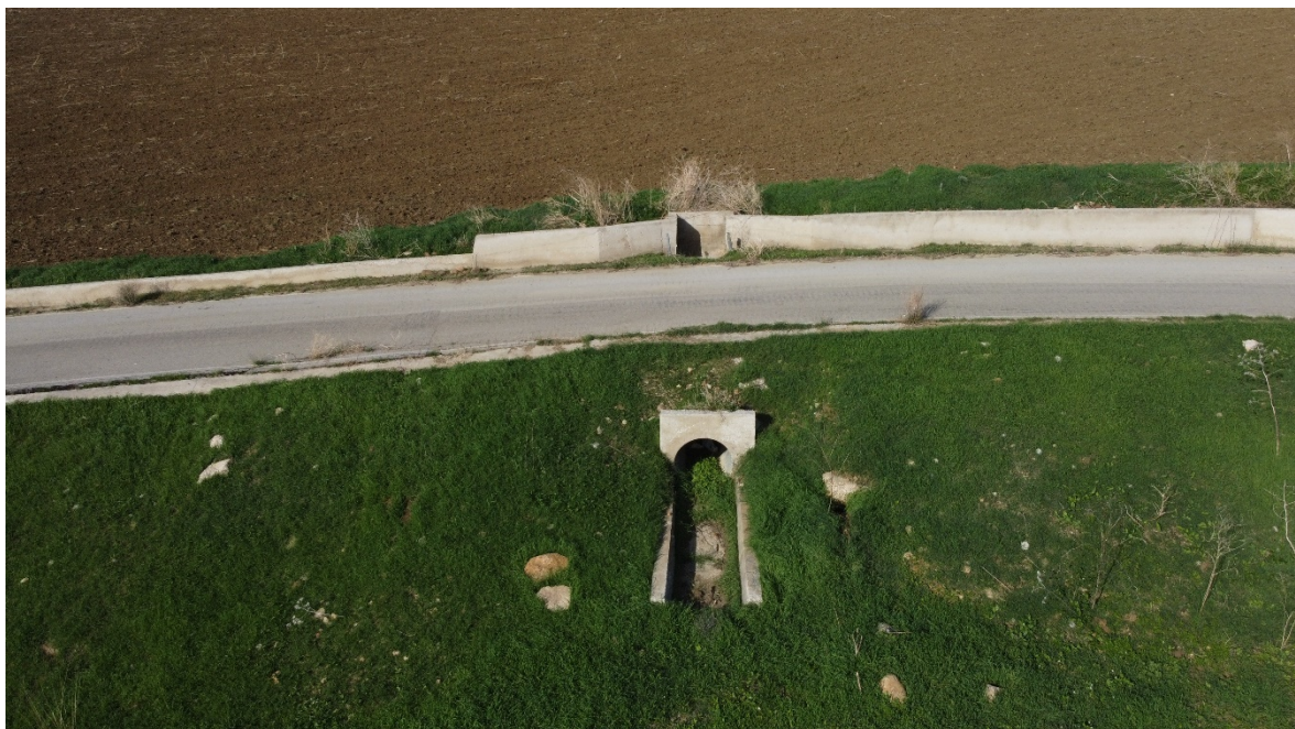
Interferenza 4 – Attraversamento idraulico, Comune di Salemi
