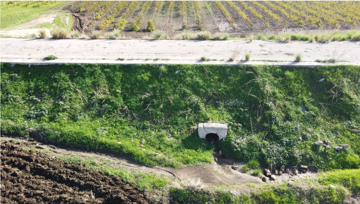
Interferenza 3 – Attraversamento idraulico, Comune di Salemi
