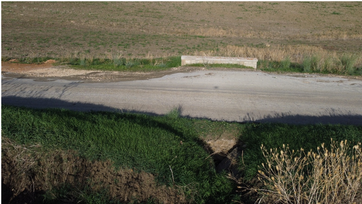
Interferenza 17 – Attraversamento idraulico, Provincia di Trapani
