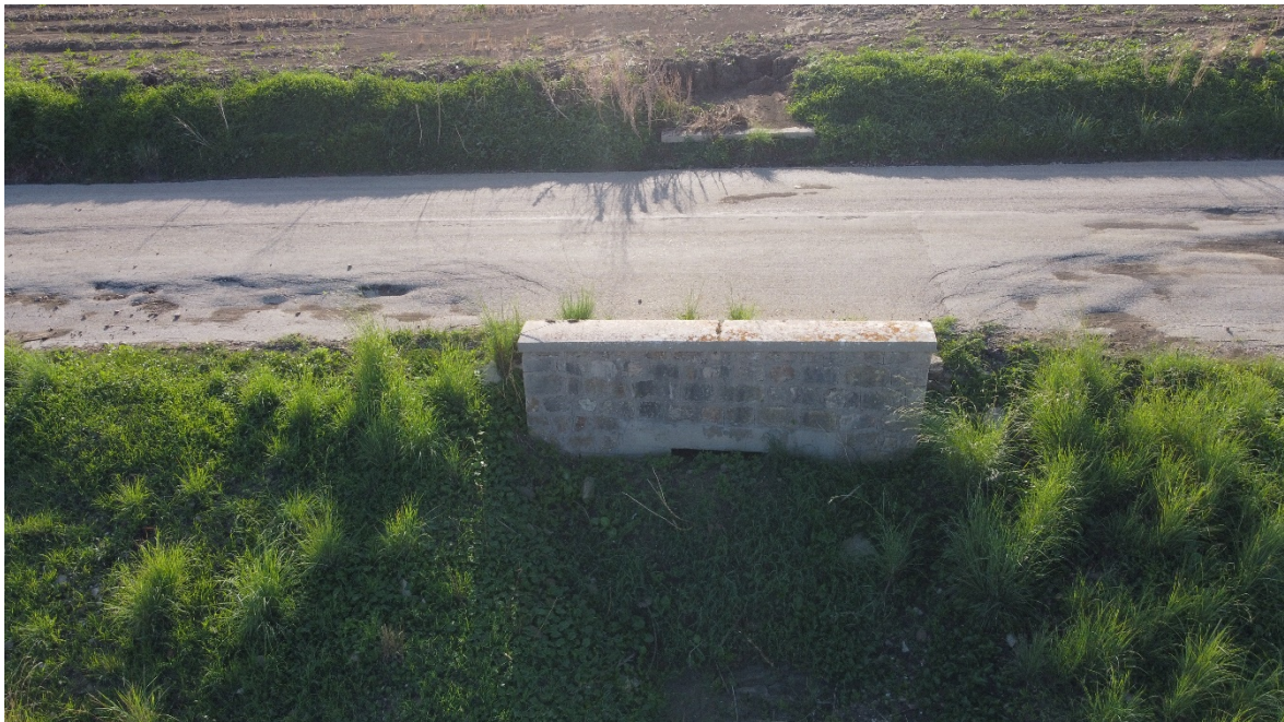
Interferenza 16 – Attraversamento idraulico, Provincia di Trapani
