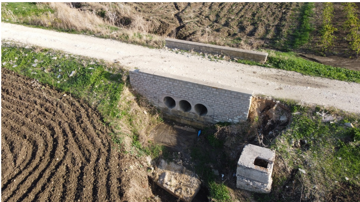
Interferenza 22 – Attraversamento idraulico, Comune di Trapani
