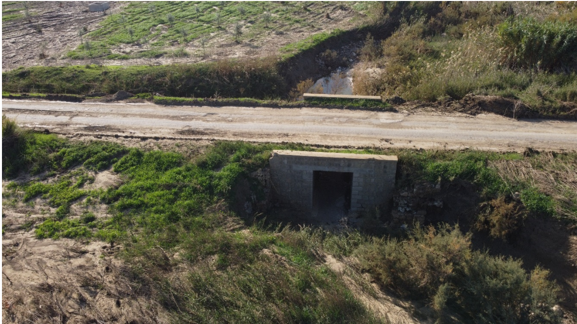
Interferenza 13 – Attraversamento idraulico, Comune di Marsala
