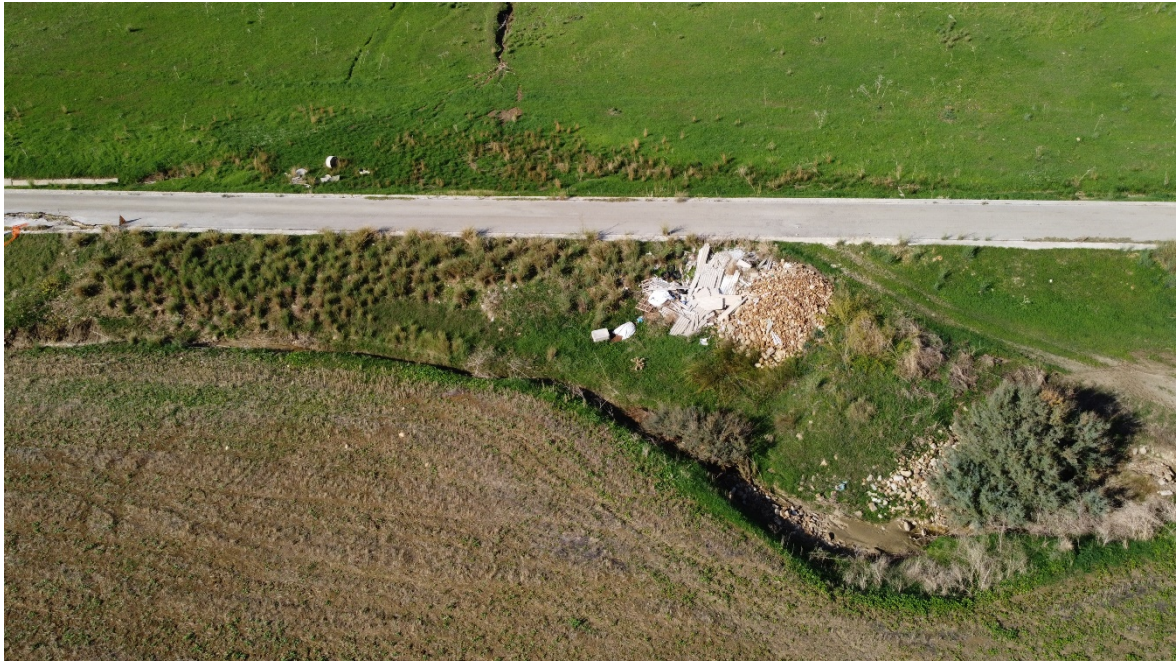
Interferenza 6 – Attraversamento idraulico, Comune di Salemi
