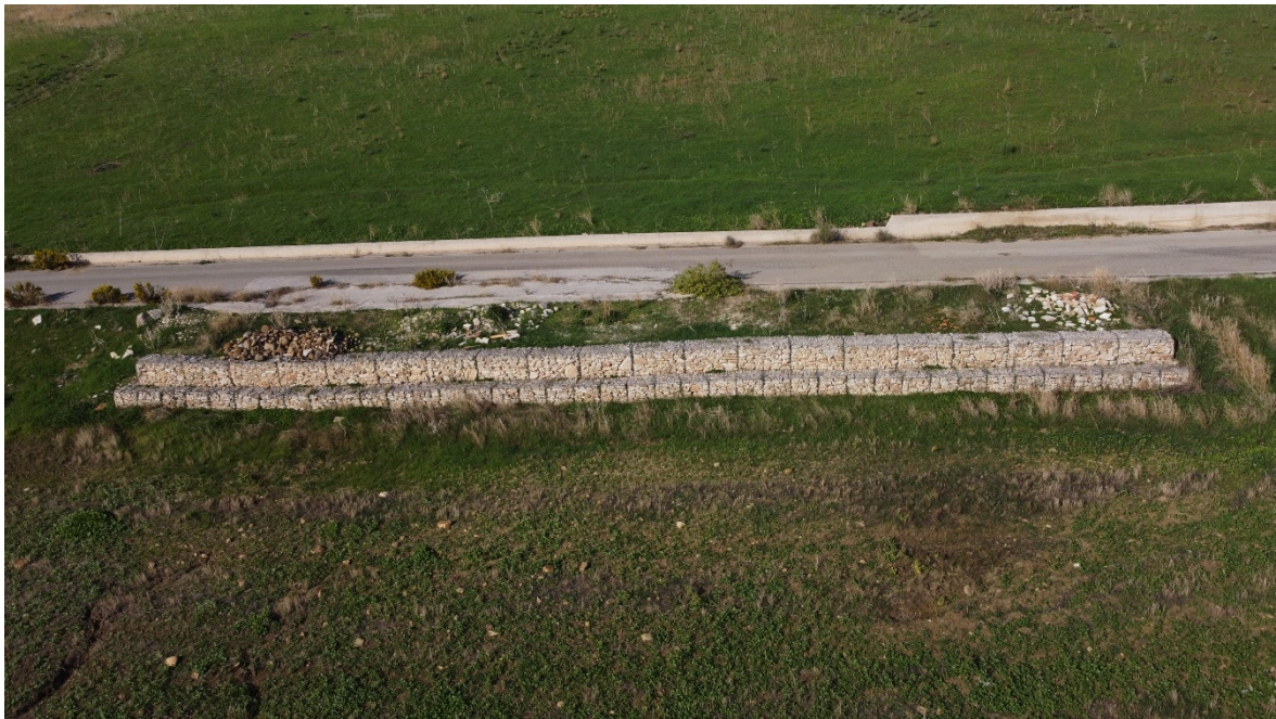
Interferenza 5 – Attraversamento zona in frana, Comune di Salemi
