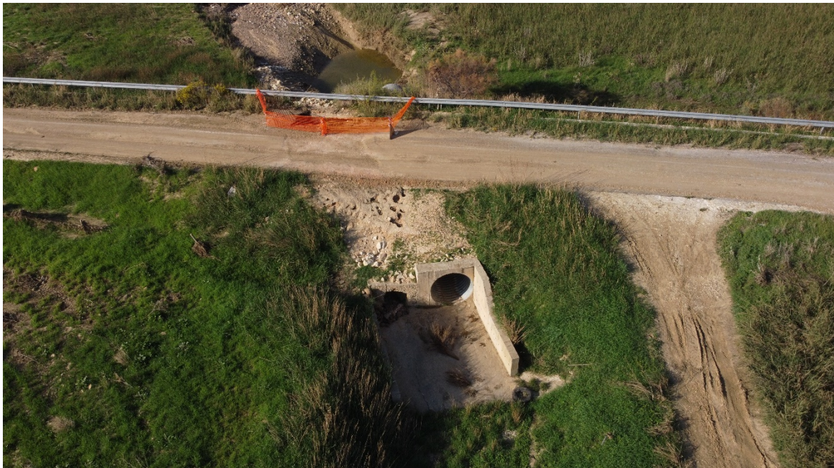
Interferenza 9 – Attraversamento idraulico, Comune di Marsala
