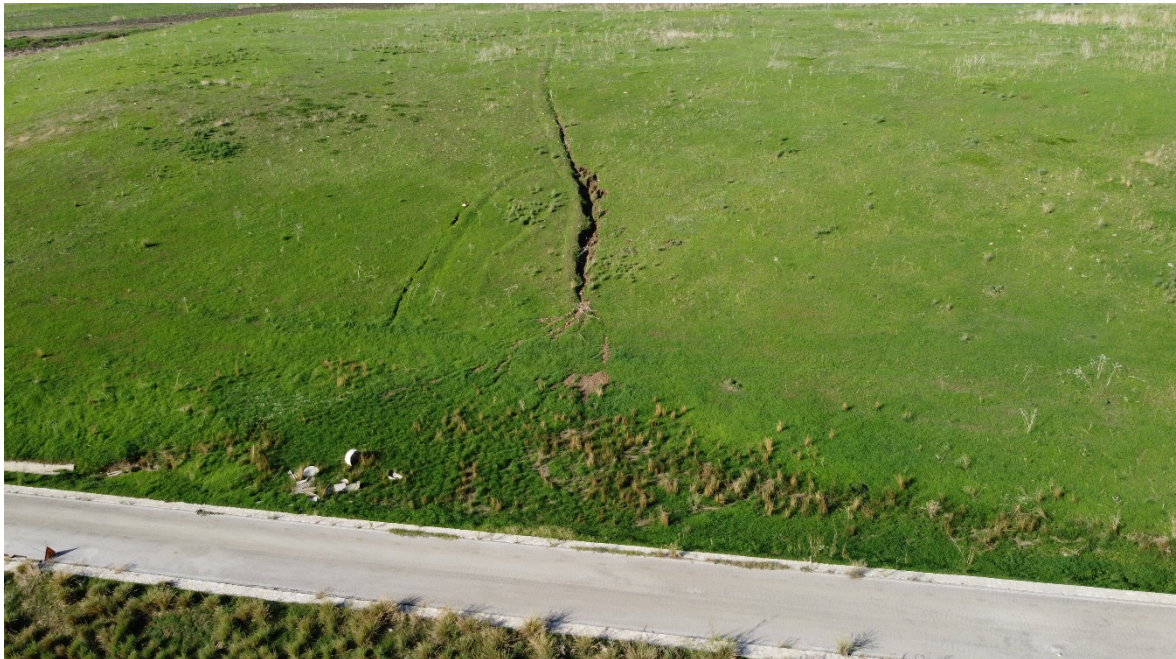
Interferenza 6 – Attraversamento idraulico, Comune di Salemi
