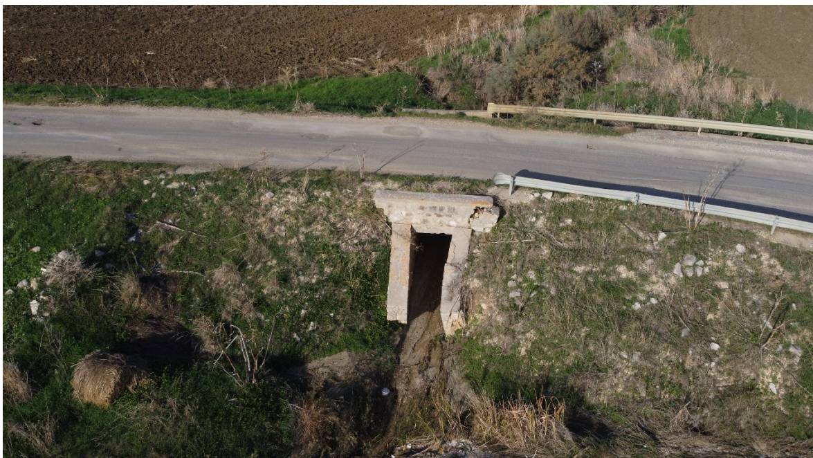
Interferenza 20 – Attraversamento idraulico, Provincia di Trapani
