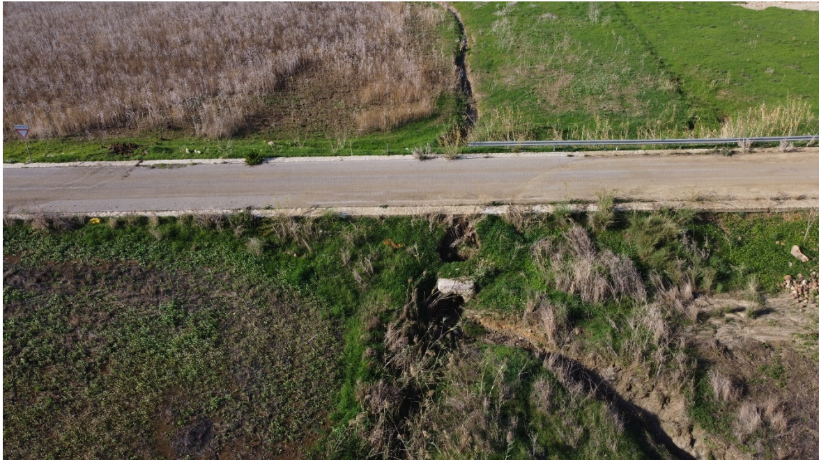
Interferenza 11 – Attraversamento idraulico, Comune di Marsala
