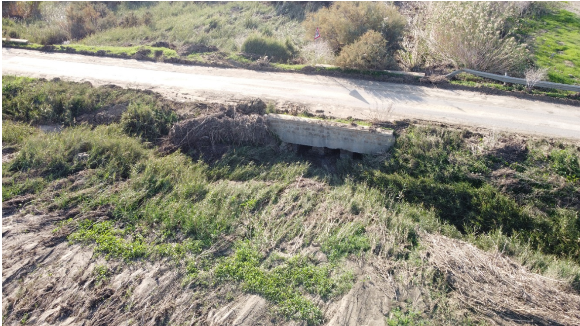
Interferenza 15 – Attraversamento idraulico, Provincia di Trapani
