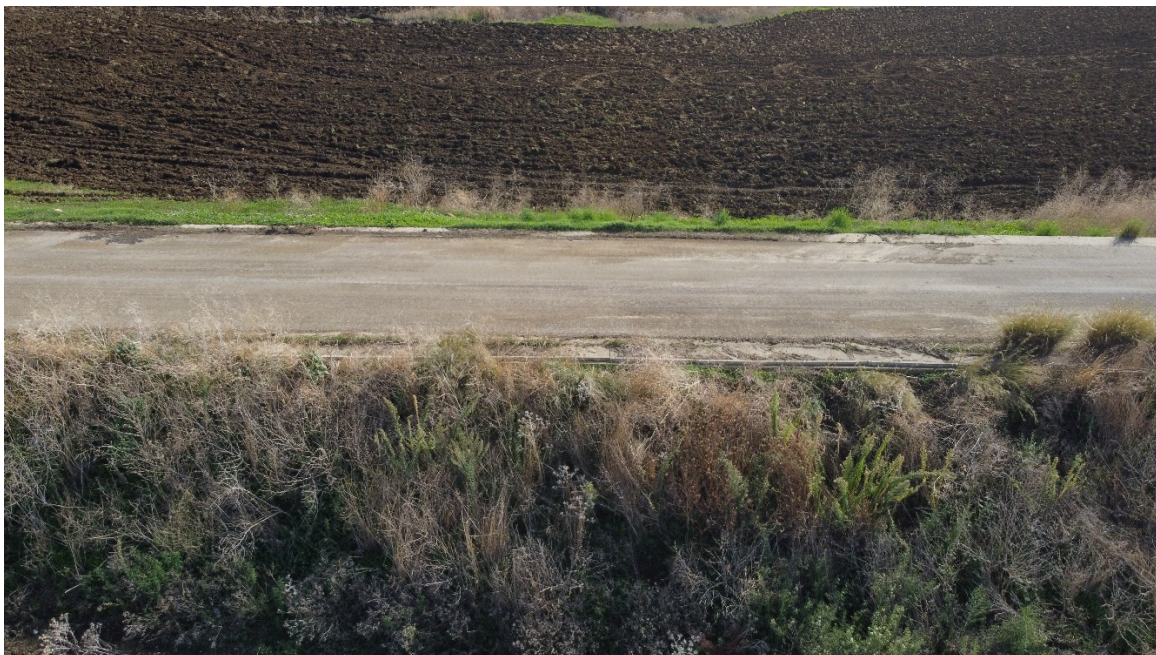
Interferenza 1 – Attraversamento canale di scolo, Comune di Salemi
