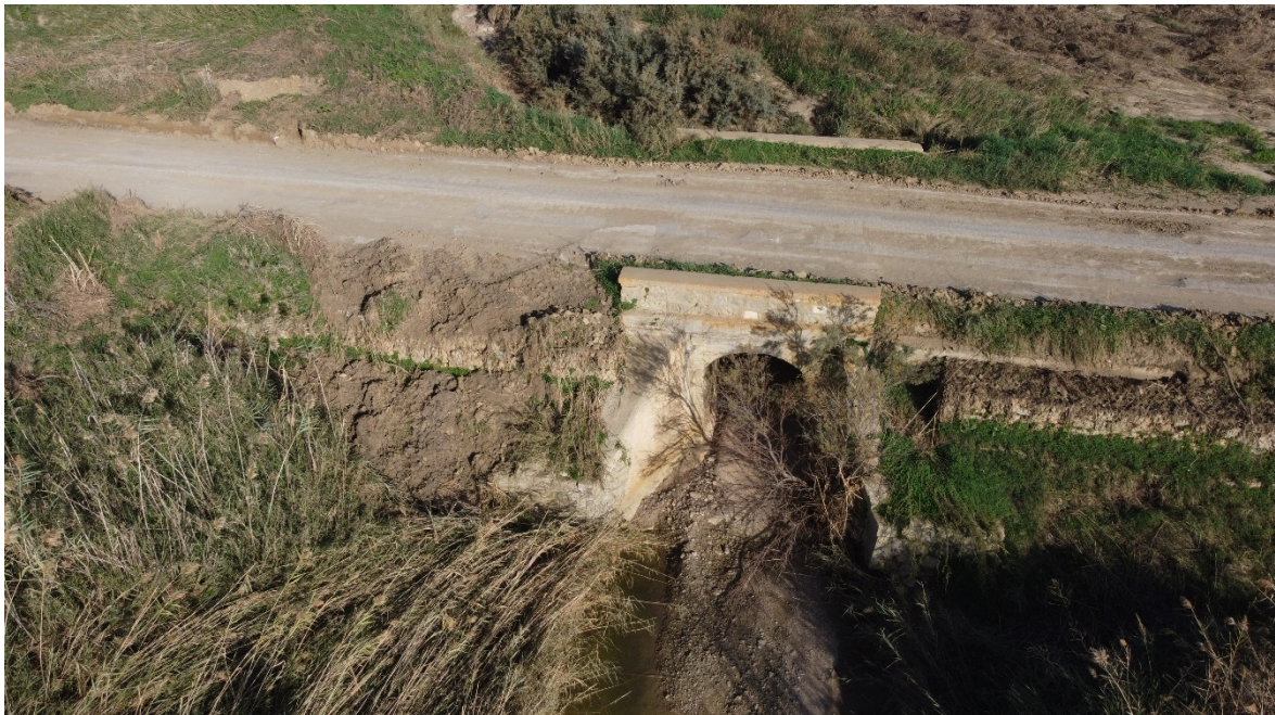
Interferenza 14 – Attraversamento idraulico, Comune di Marsala
