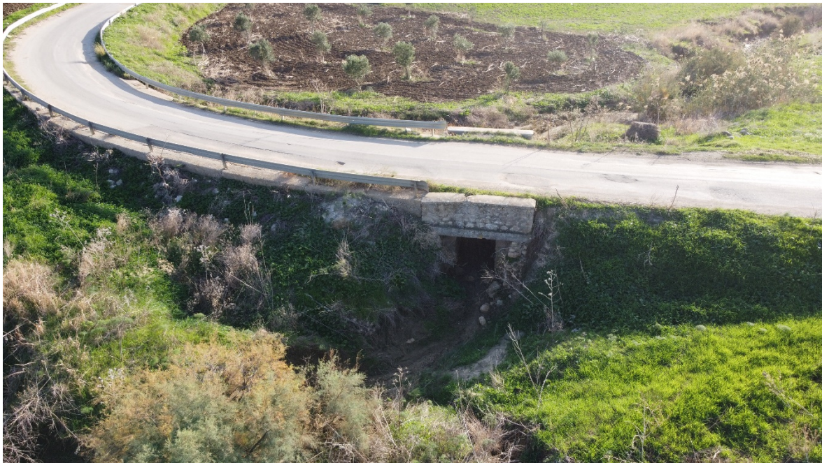
Interferenza 19 – Attraversamento idraulico, Provincia di Trapani
