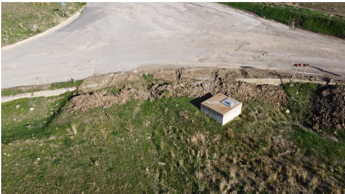
Interferenza 18 – Attraversamento rete idrica, Provincia di Trapani
