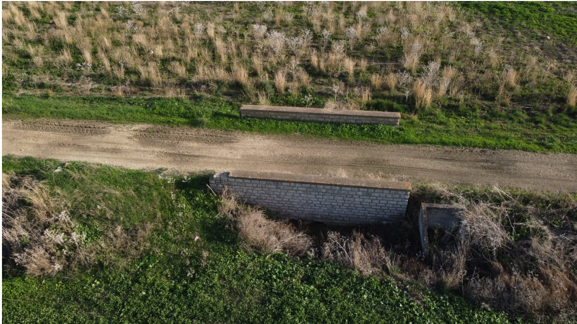
Interferenza 23 – Attraversamento idraulico, Comune di Trapani
