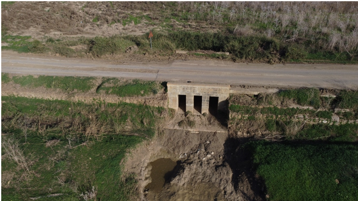
Interferenza 12 – Attraversamento idraulico, Comune di Marsala
