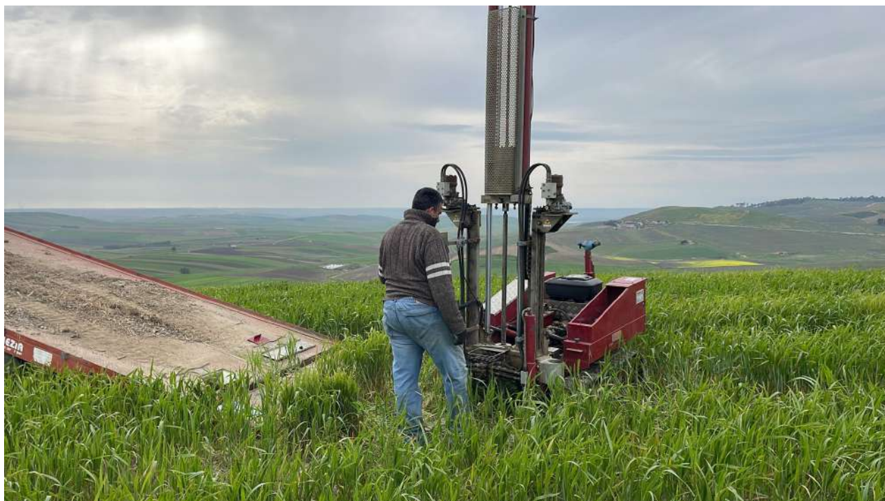
Prova DPSH 9 eseguita in situ
