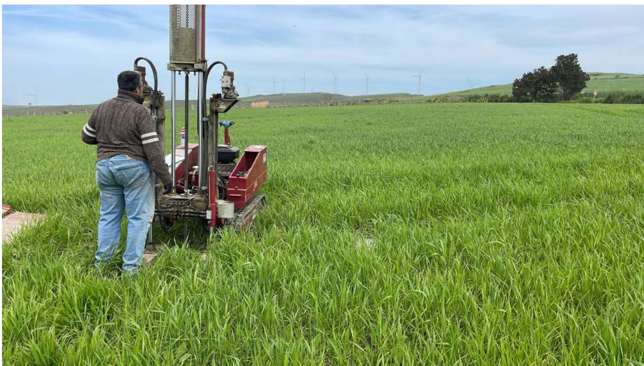
Prova DPSH 5 eseguita in situ
