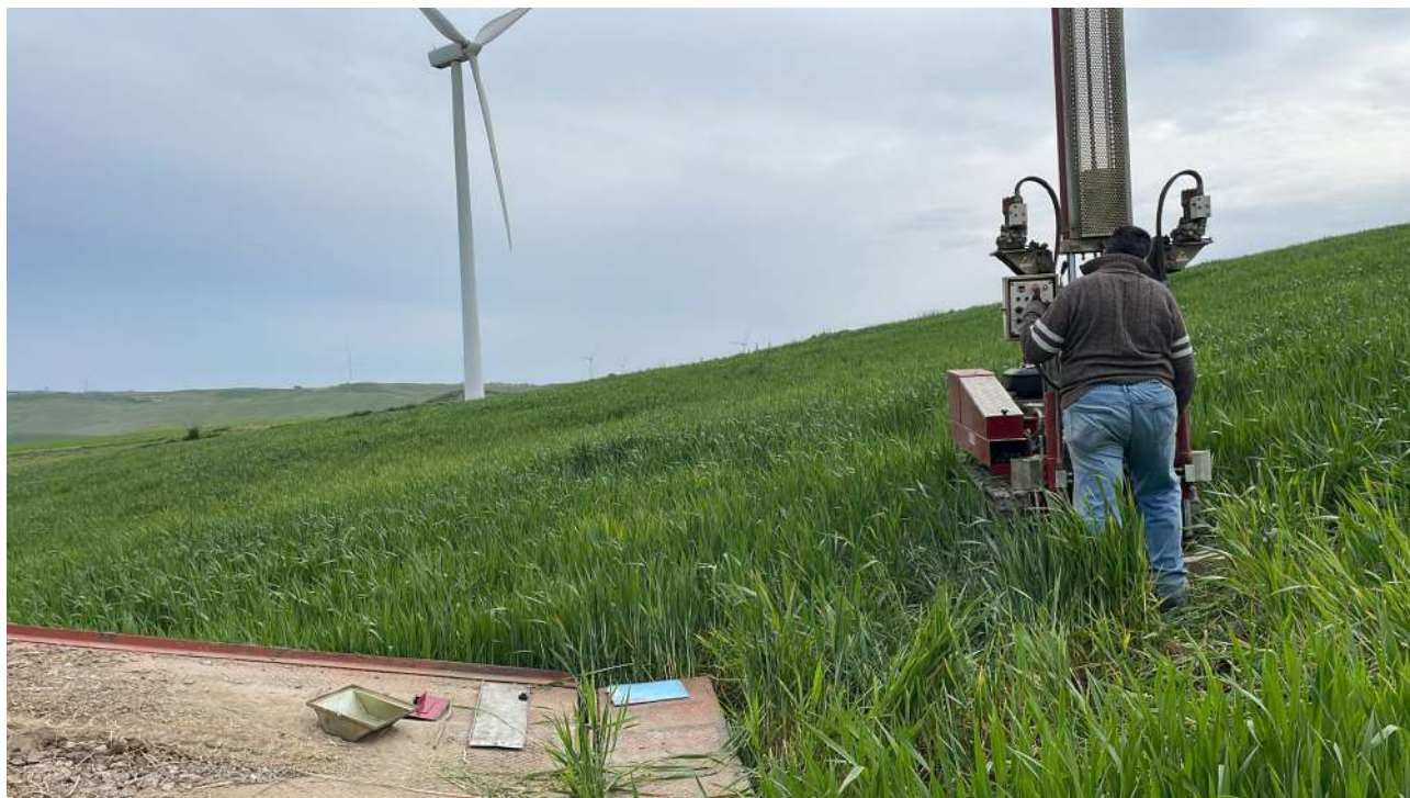
Prova DPSH 10 eseguita in situ
