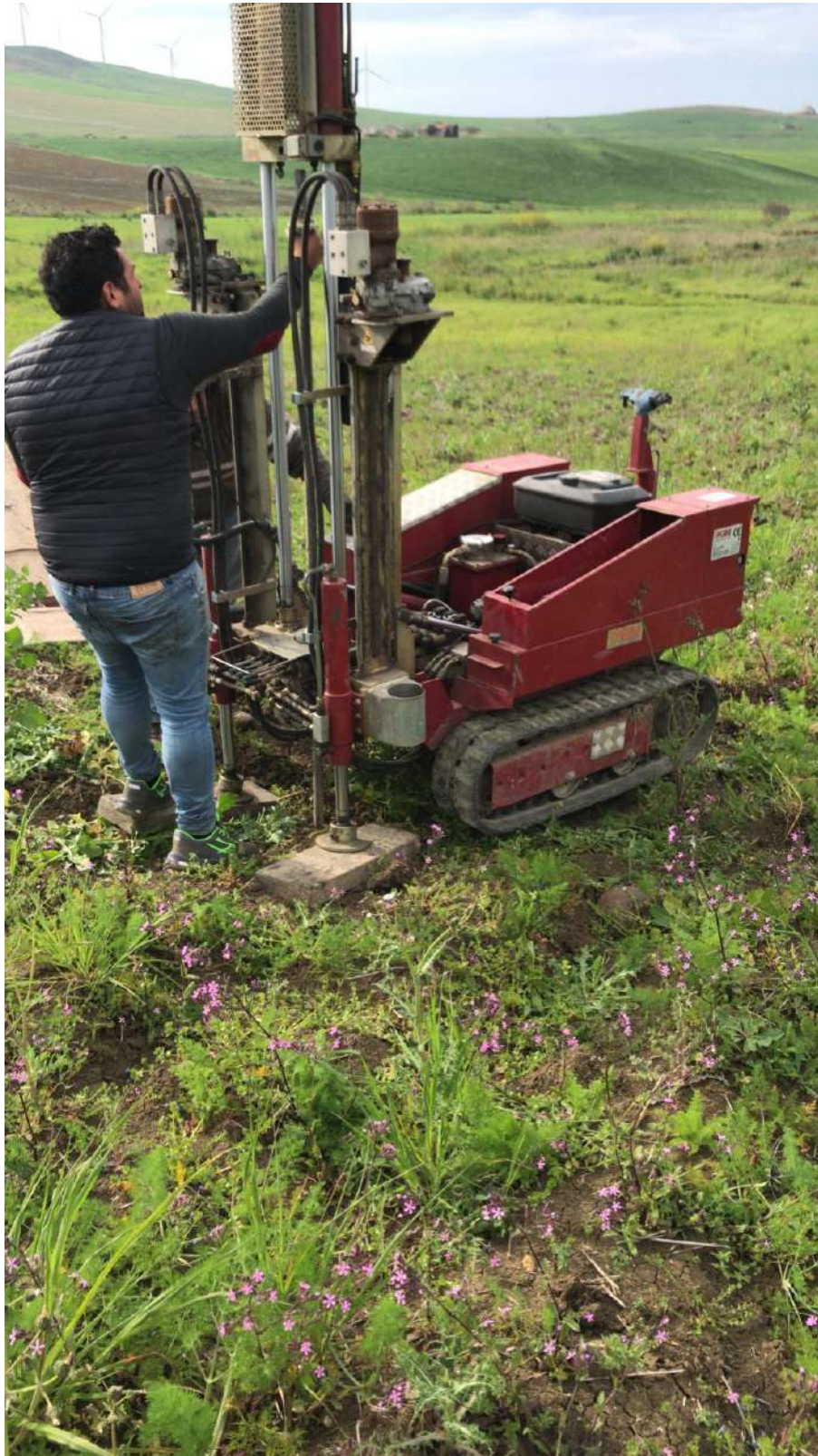
Prova DPSH 11 eseguita in situ
