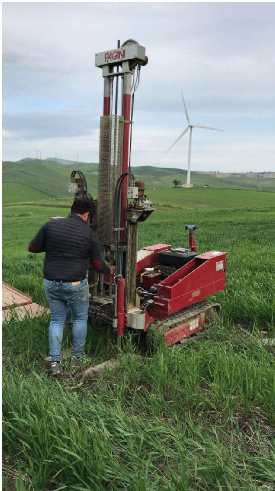
Prova DPSH 12 eseguita in situ
