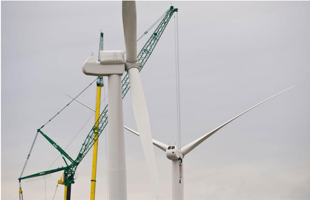
*Figura 7 - operazioni di lifting aerogeneratori*
