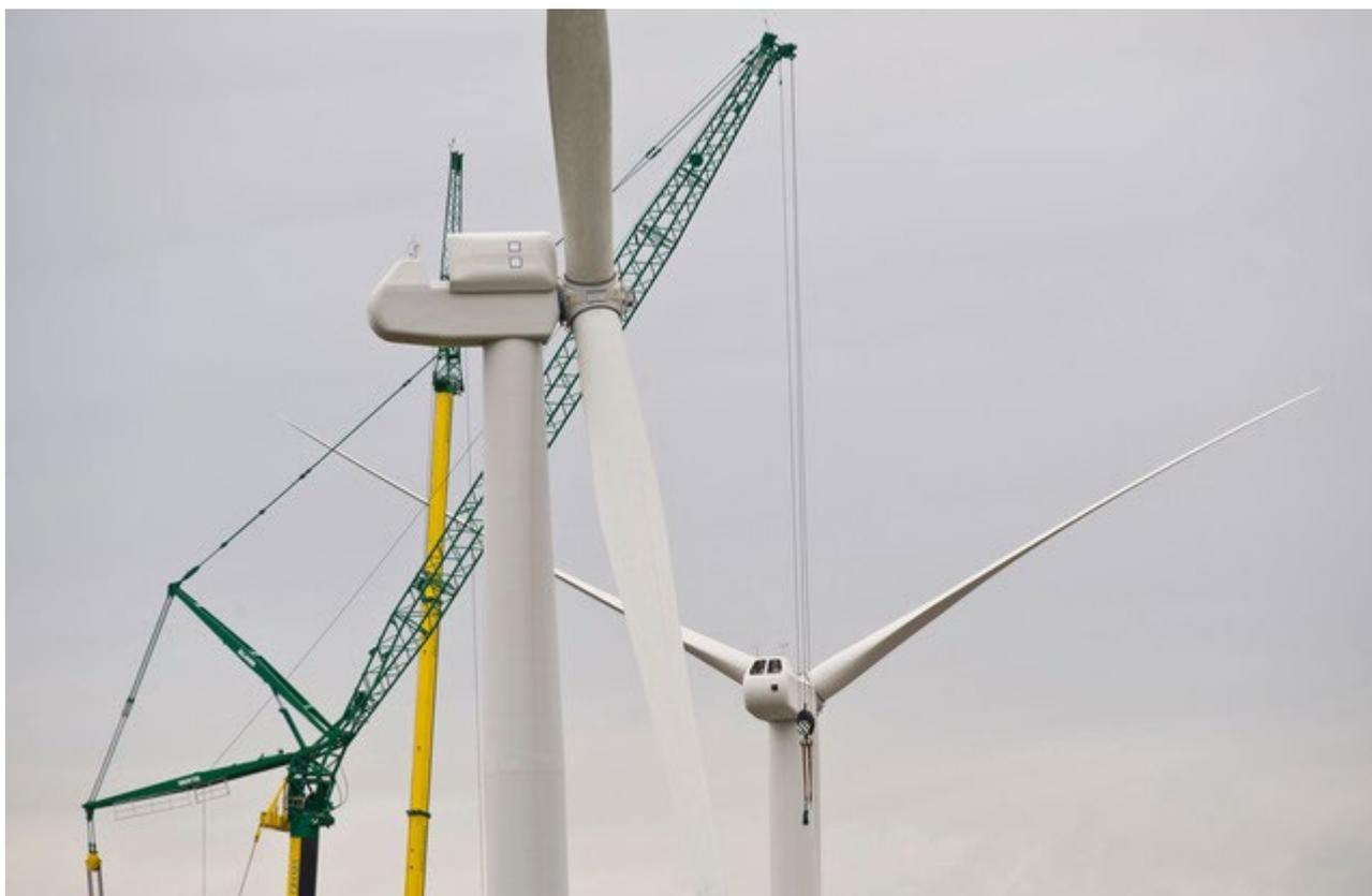
Figura 2- posa in opera aerogeneratori
