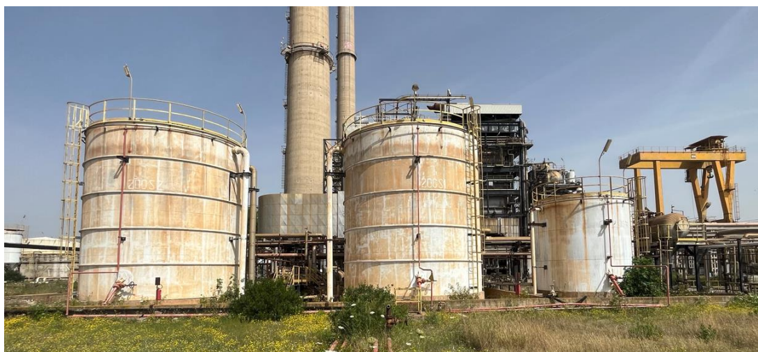
Figura 32 – I serbatoi oggetto di demolizione (sigla C di figura 29)
