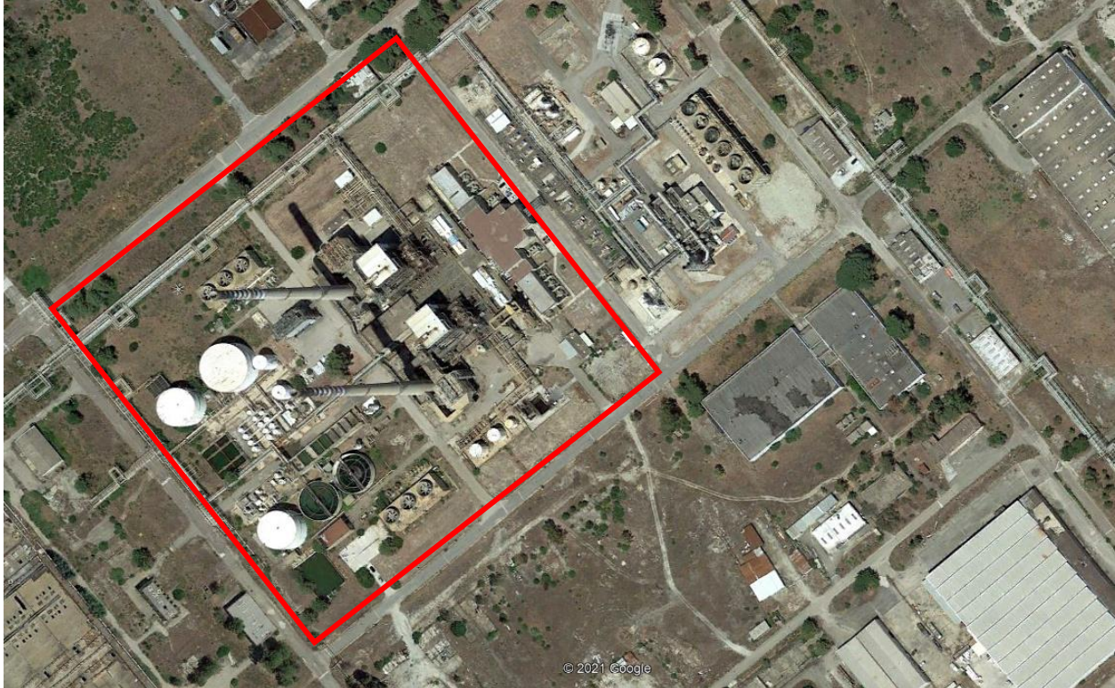
Figura 2 Localizzazione della centrale di Ottana Energia
