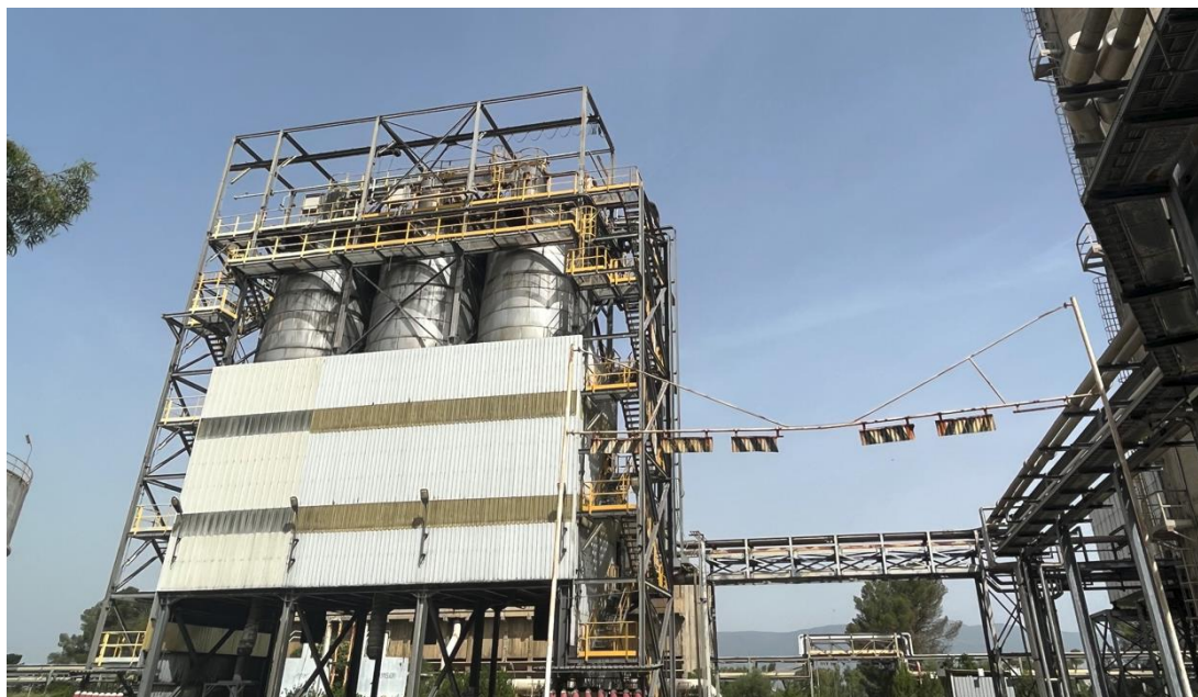
Figura 31 – Il deposito ceneri della caldaia G100 oggetto di demolizione (sigla B di figura 29)
