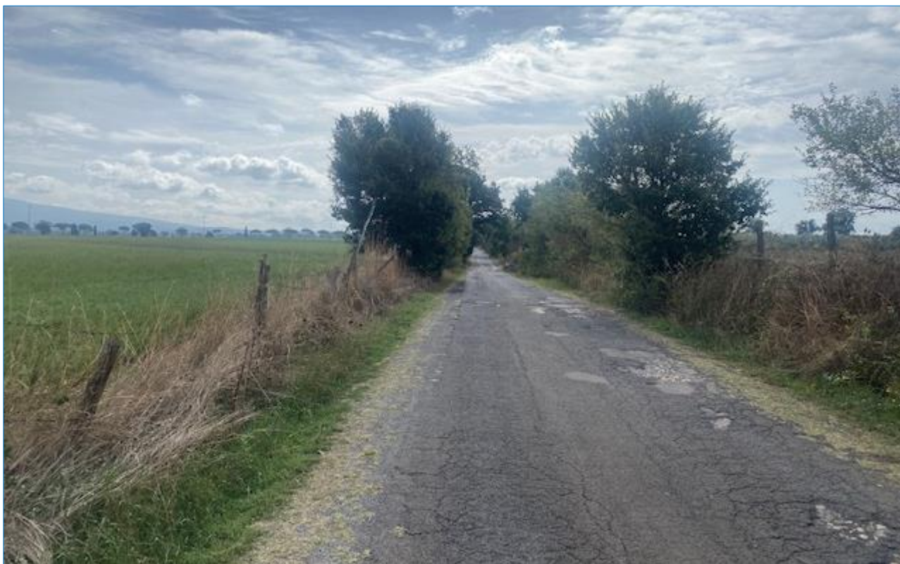
Figura 47: fotografia di dettaglio passaggio cavidotto
