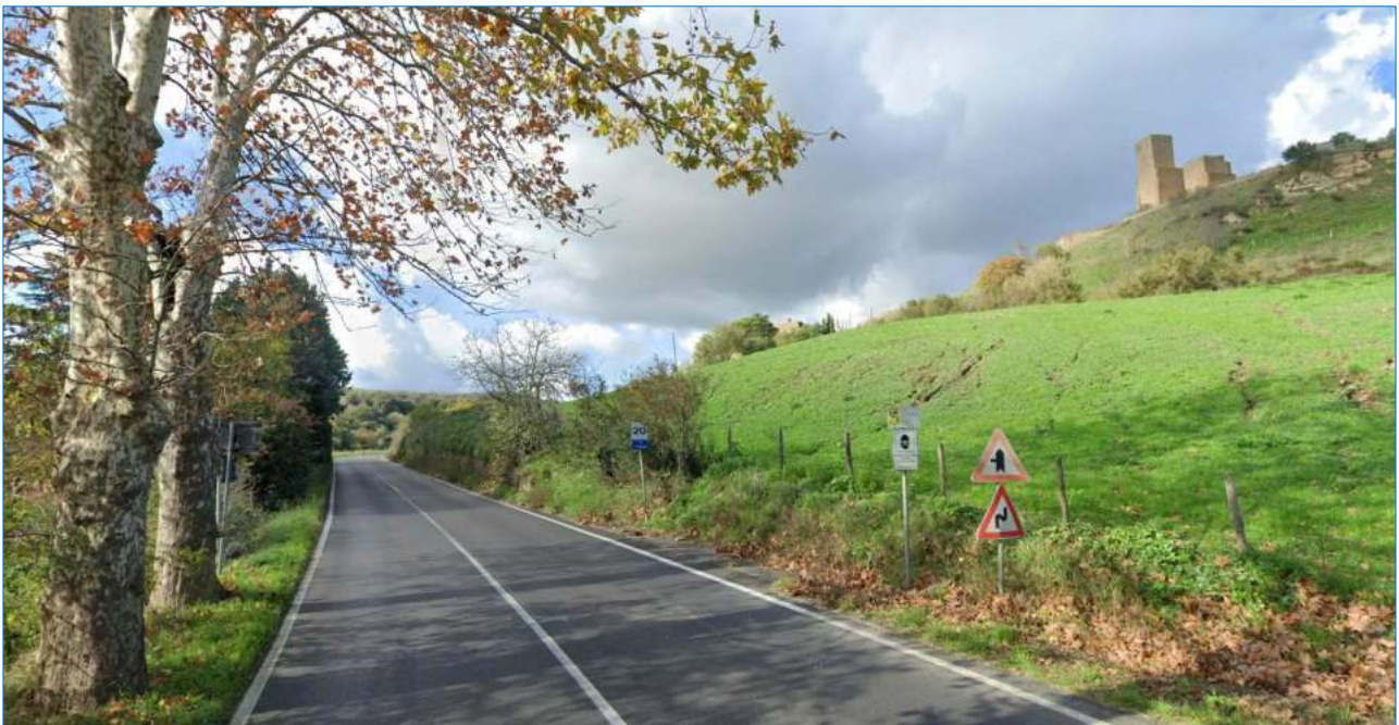
Figura 40 vista dell'SP02 dopo il ponte sul fiume Marta in direzione Tuscania
