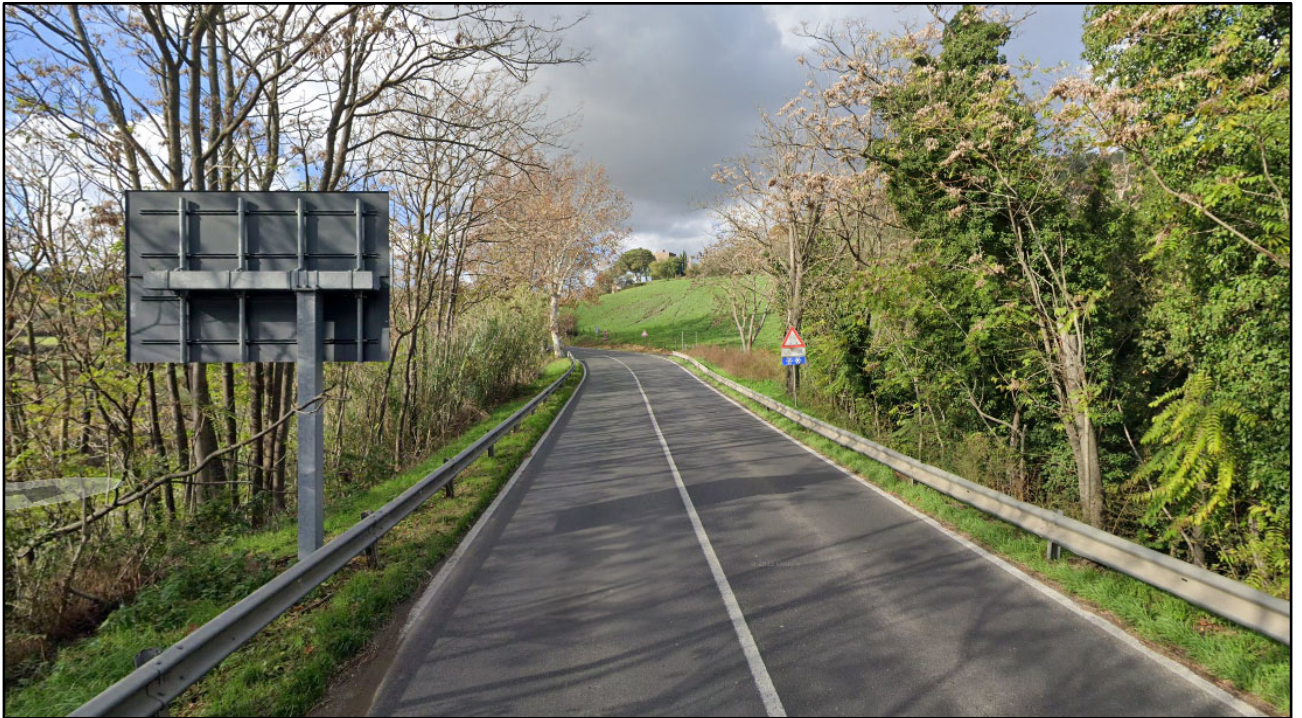
Figura 13 - PdV_6 SP2- Tuscanese –ponte stradale di attraversamento Fiume Marta – Tratto fine area ZSC.
