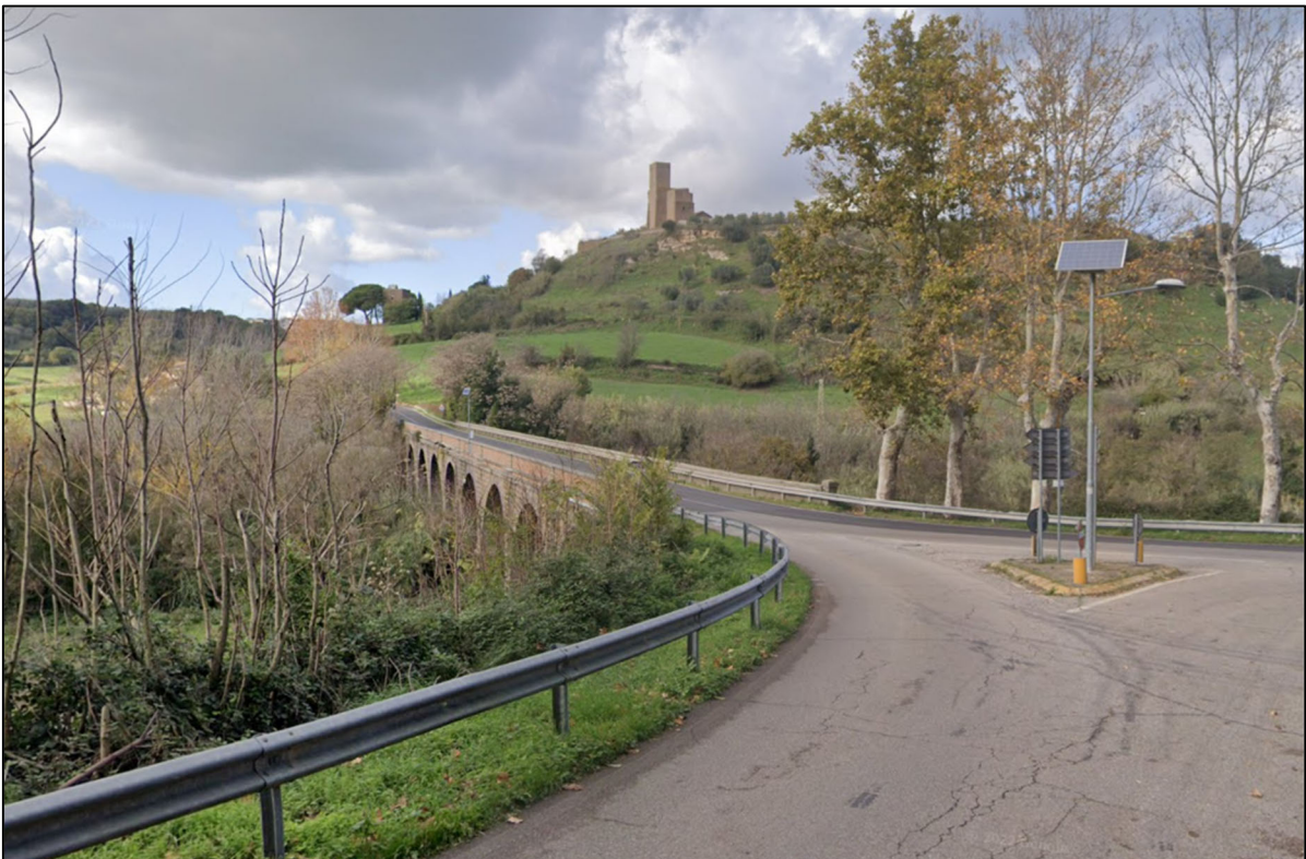
Figura 10 - PdV_3 SP2- Tuscanese – inizio ponte stradale di attraversamento Fiume Marta
