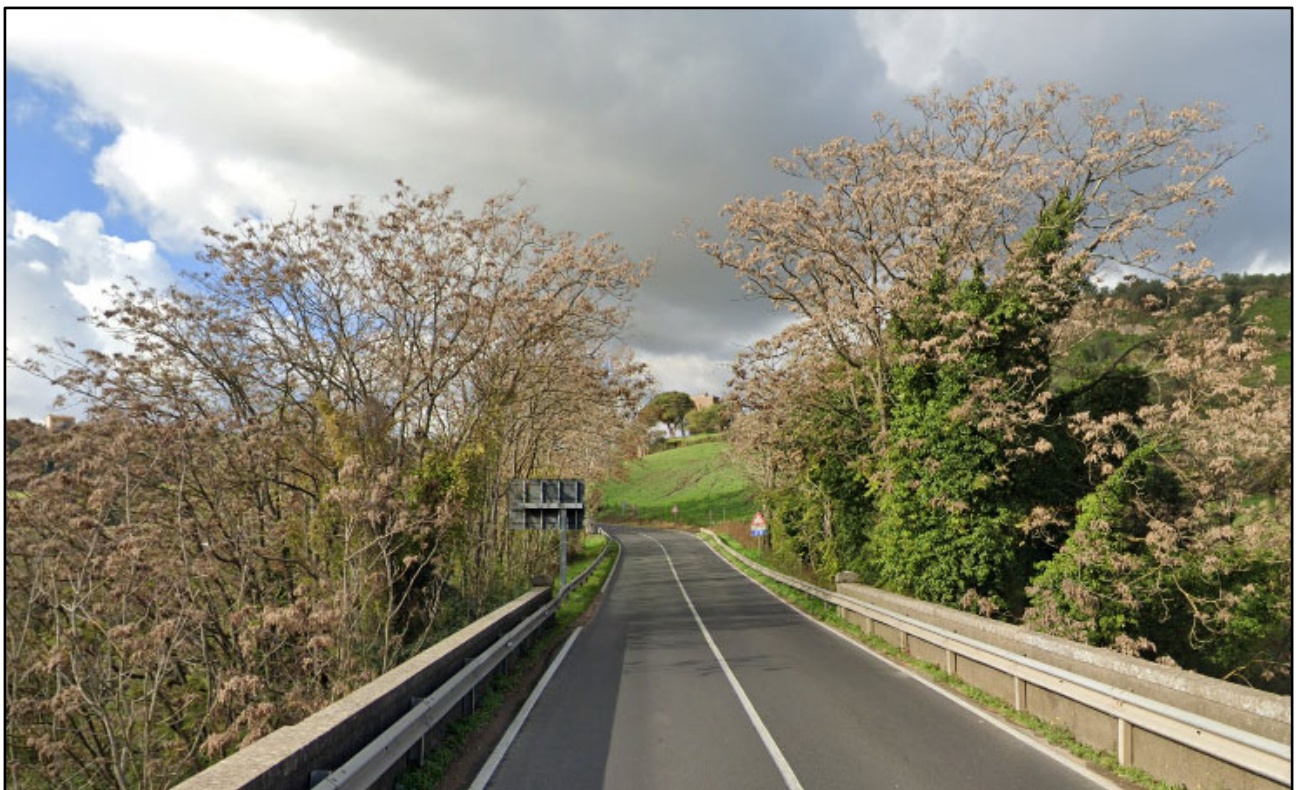
Figura 12 - PdV_5 SP2- Tuscanese –ponte stradale di attraversamento Fiume Marta
