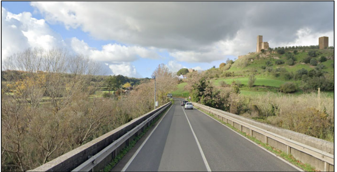
Figura 11 - PdV_4 SP2- Tuscanese –ponte stradale di attraversamento Fiume Marta
