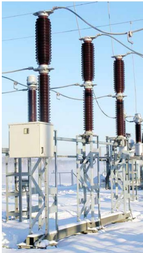
Fig. 22. Particolare Interruttore con TA incorporato.
