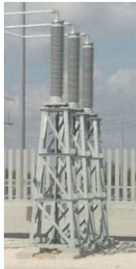
Fig. 18. Terminale cavo AT tipo.
