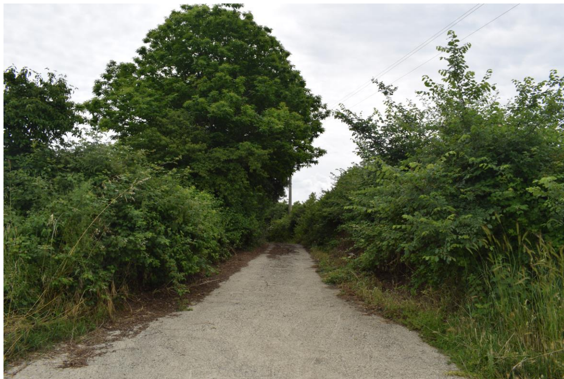
Foto 6 Lato Nord di Strada Monte Carognone (12)
