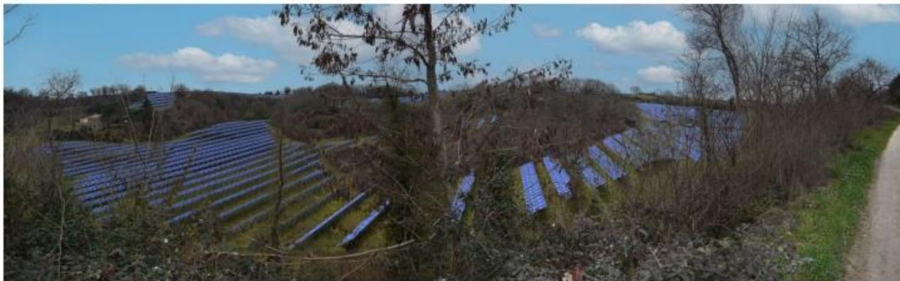
Figura 30 Esempi di mitigazione dell'impatto visivo dell'impianto
