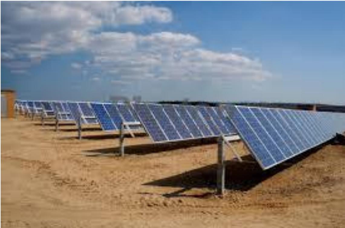
Figura 5 Esempio di impianto fotovoltaico su struttura mobile
