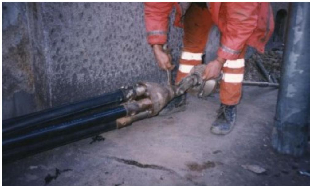
Fig. 3.2: Alesatore con tubazioni agganciate
