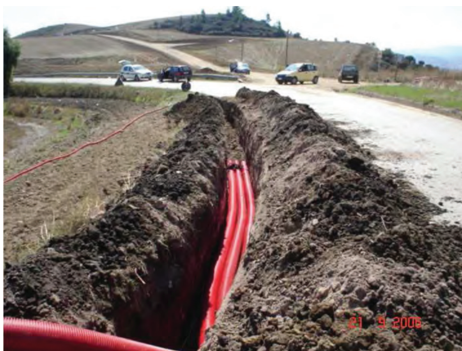
Foto illustrativa della messa in posa dei cavidotti MT
