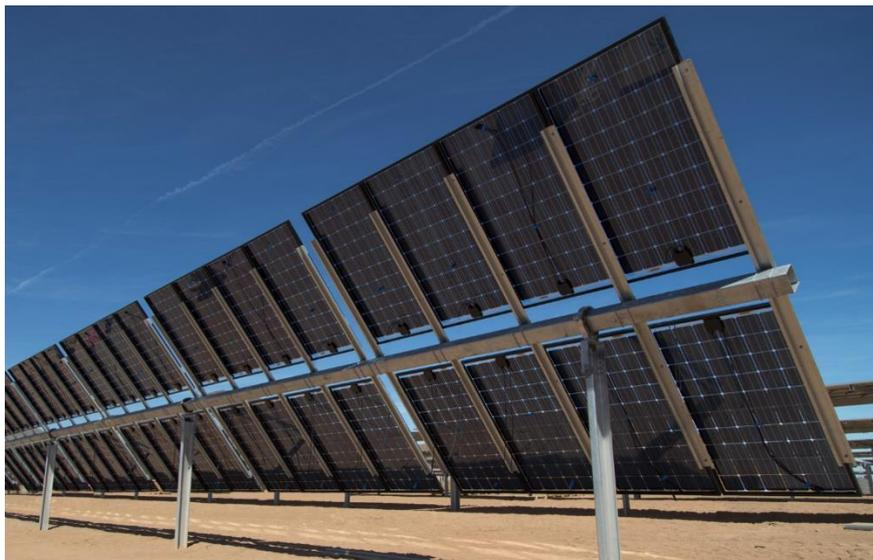
**Figura 4-5: Esempio struttura e modulo FV bifacciale**
