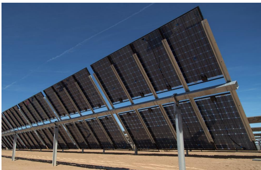
Figura 4-5: Esempio struttura e modulo FV bifacciale
