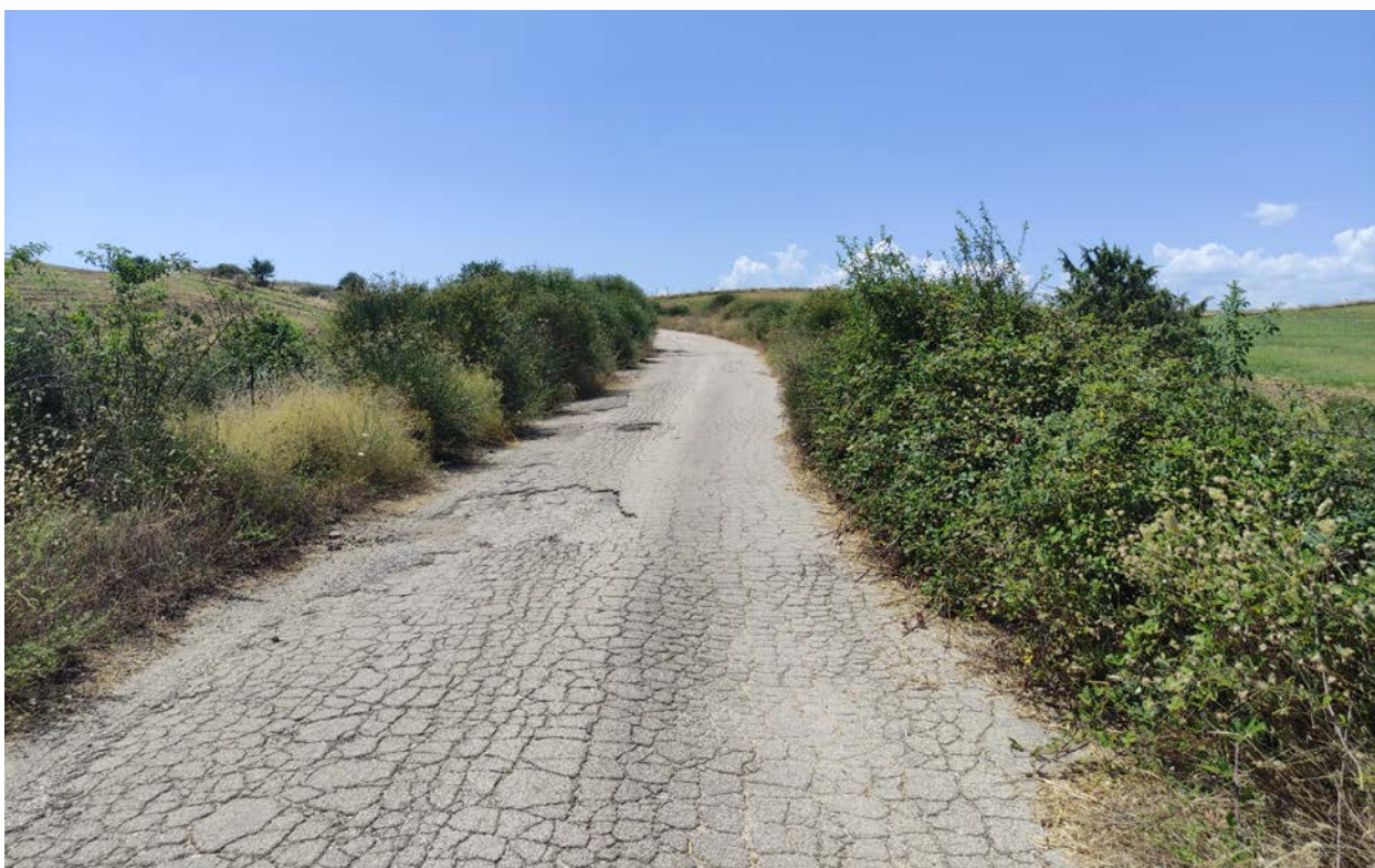
Vista della strada comunale contrada "San Domenico", a circa 170 metri di distanza in linea d'aria dalle aree di impianto (che non risultano visibili), interessata dal tracciato del cavidotto interrato MT di collegamento tra l'impianto e la sottostazione di consegna e trasformazione 30/36 kV.
